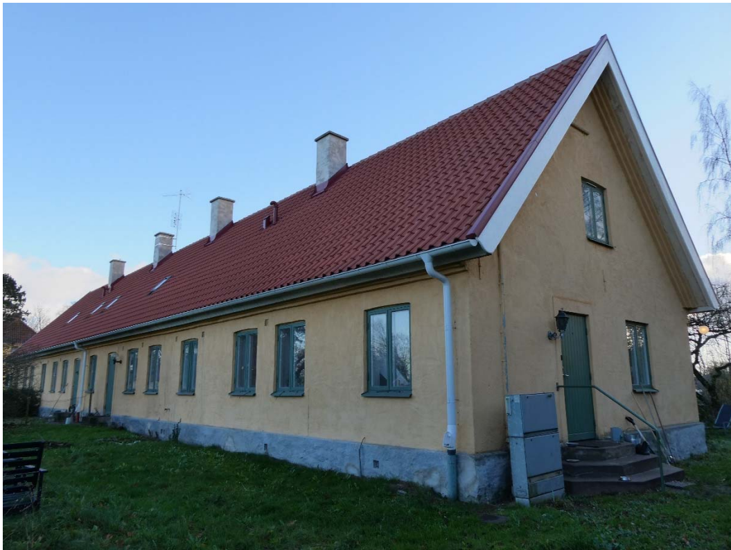
Efter åtgärder. Norra takfallet.
