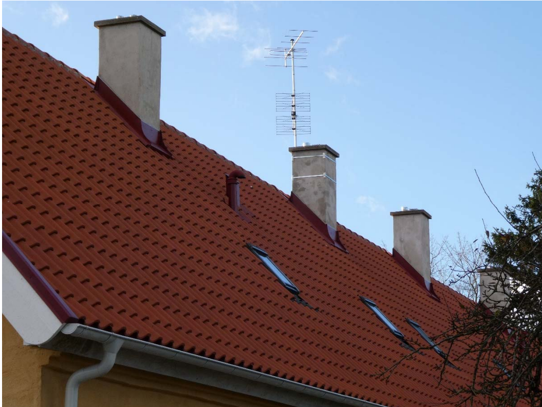
Efter åtgärder. Södra takfallet med skorstenar, nya plåtarbeten och takfönster.
