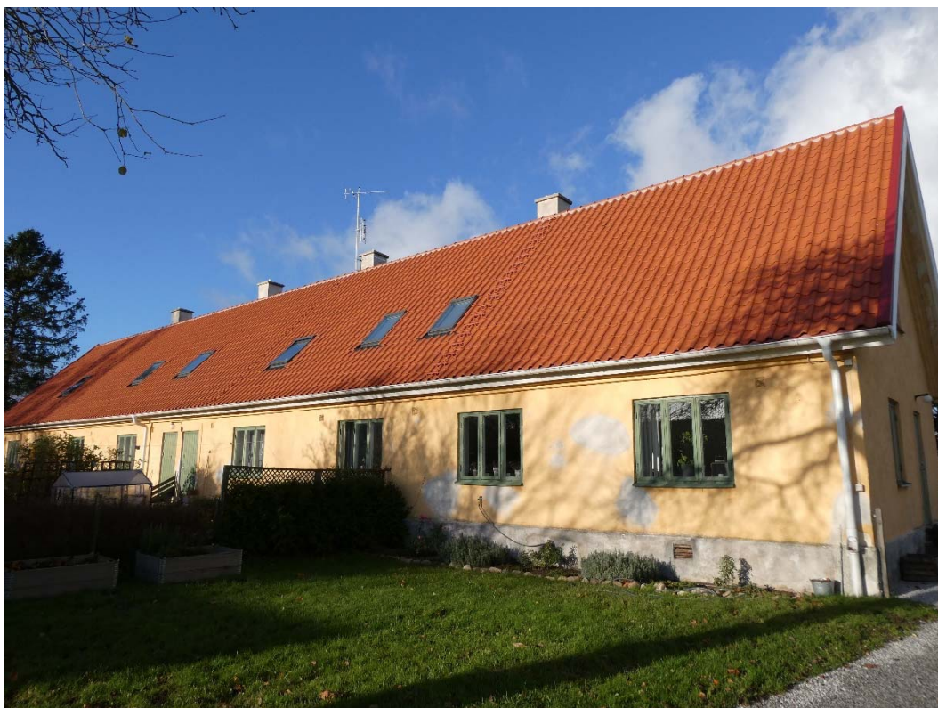
Efter åtgärder. Södra takfallet. Notera nya takstegar som smälter väl in i takets utseende.
