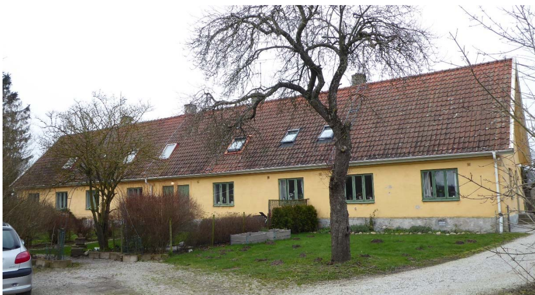
Före åtgärder södra fasaden.
