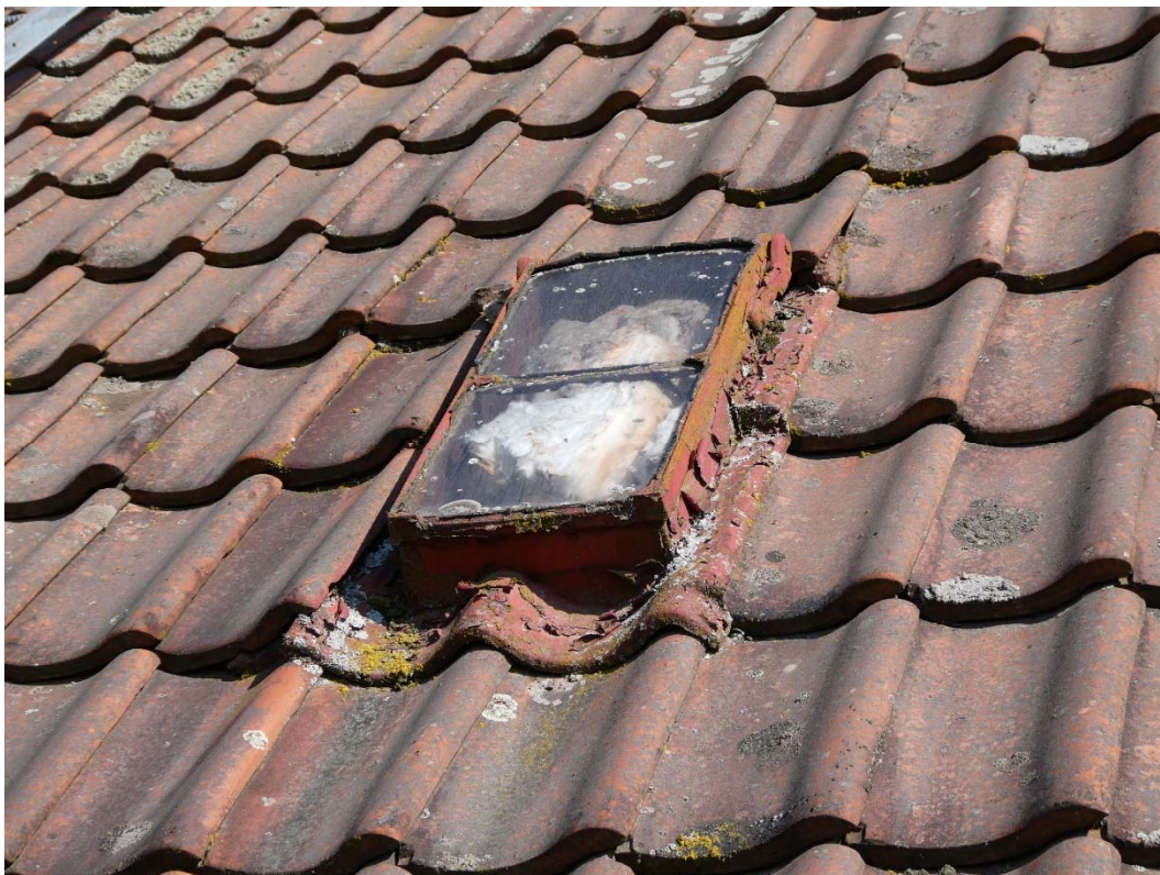
Före åtgärder, äldre takfönster och Weberödspannor.
