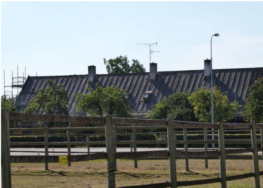
Norra takfallet med den gamla takpappen som bevarats under ny taktäckning.
