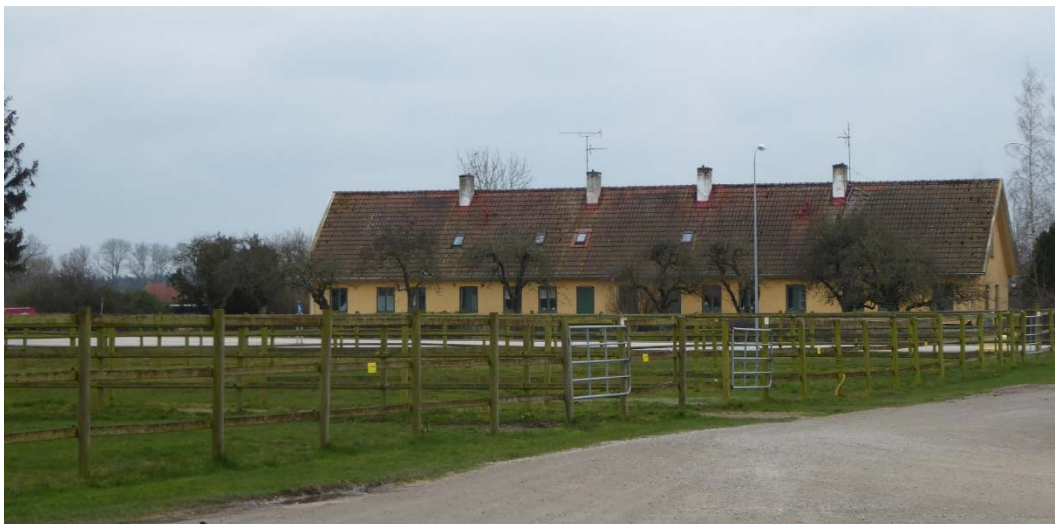
Före åtgärder norra fasaden.
