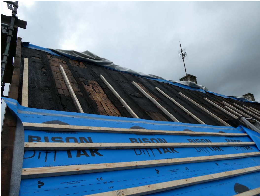
Under arbete. Södra takfallet.
