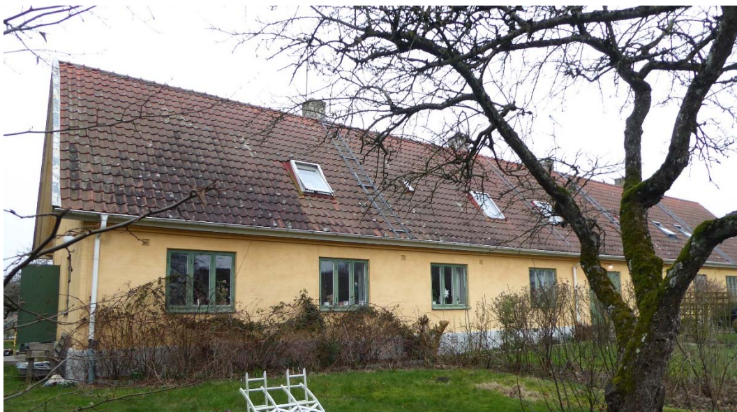
Före åtgärder södra fasaden.
