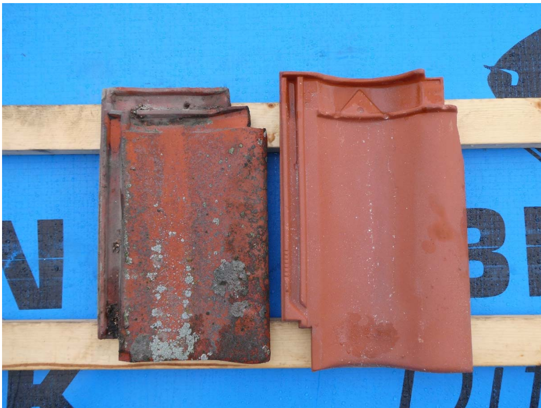
Jämförelse av befintliga takpannor och nya.
