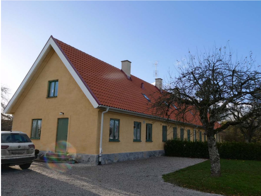
Efter åtgärder. Östra gaveln och norra takfallet.
