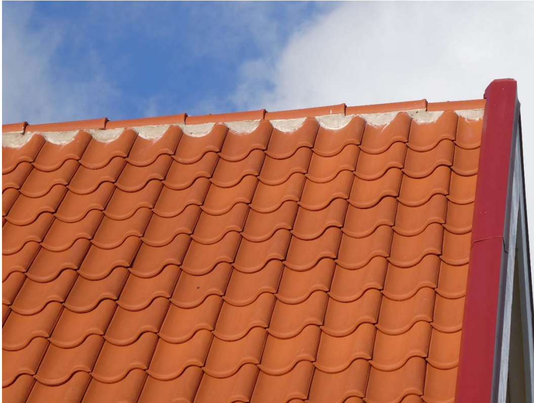
Efter åtgärder. Nya takpannor, muradnock och ny plåt.
