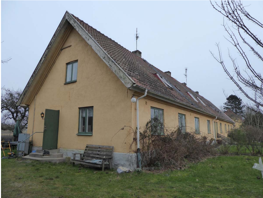
Före åtgärder västra gaveln och södra fasaden.
