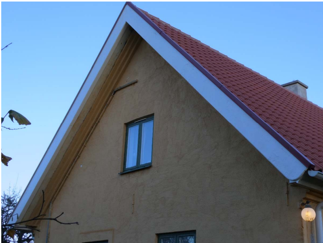
Efter åtgärder. Västra gaveln med äldre underhållna vindskivor.
