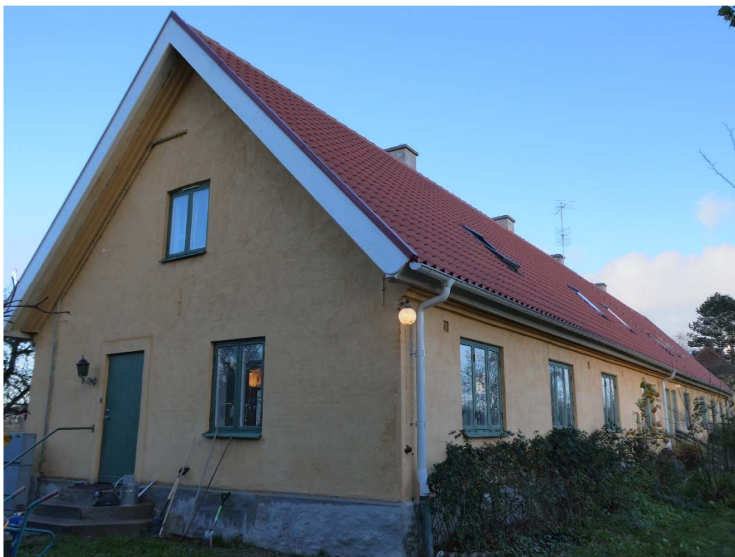
Efter åtgärder. Västra gaveln och södra takfallet.
