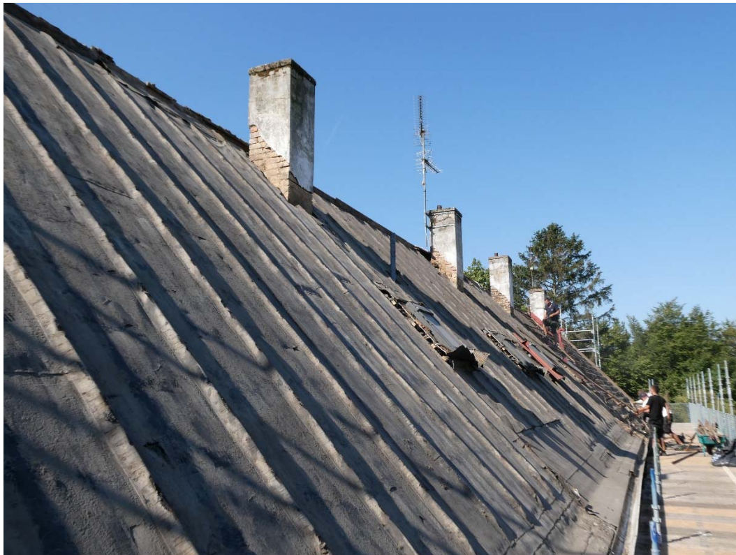
Norra takfallet med den äldre takpappen på trekantslist. Hela vårdar och listen täckt med papprensa, spikat med pappspik.
