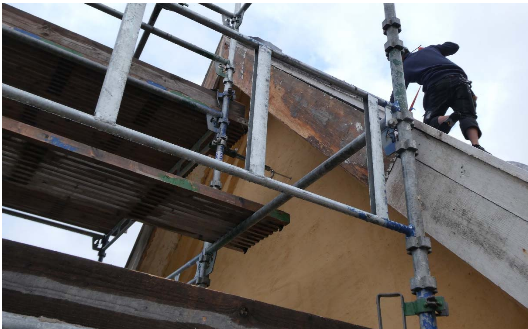
Den nordöstra vindskivan var i nedre halvan redan tidigare ersatt med två brädor ovanpå varandra. Den övre delen som syns på fotografiet var lika övriga vindskivor i ett stycke men var kraftigt rötskadad. Den övre delen har ersatts lika som nedre delen.
