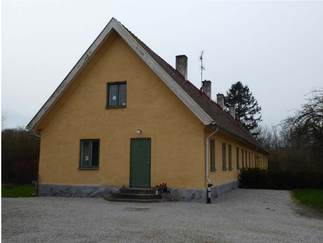
Före åtgärder östra gaveln och norra fasaden.
