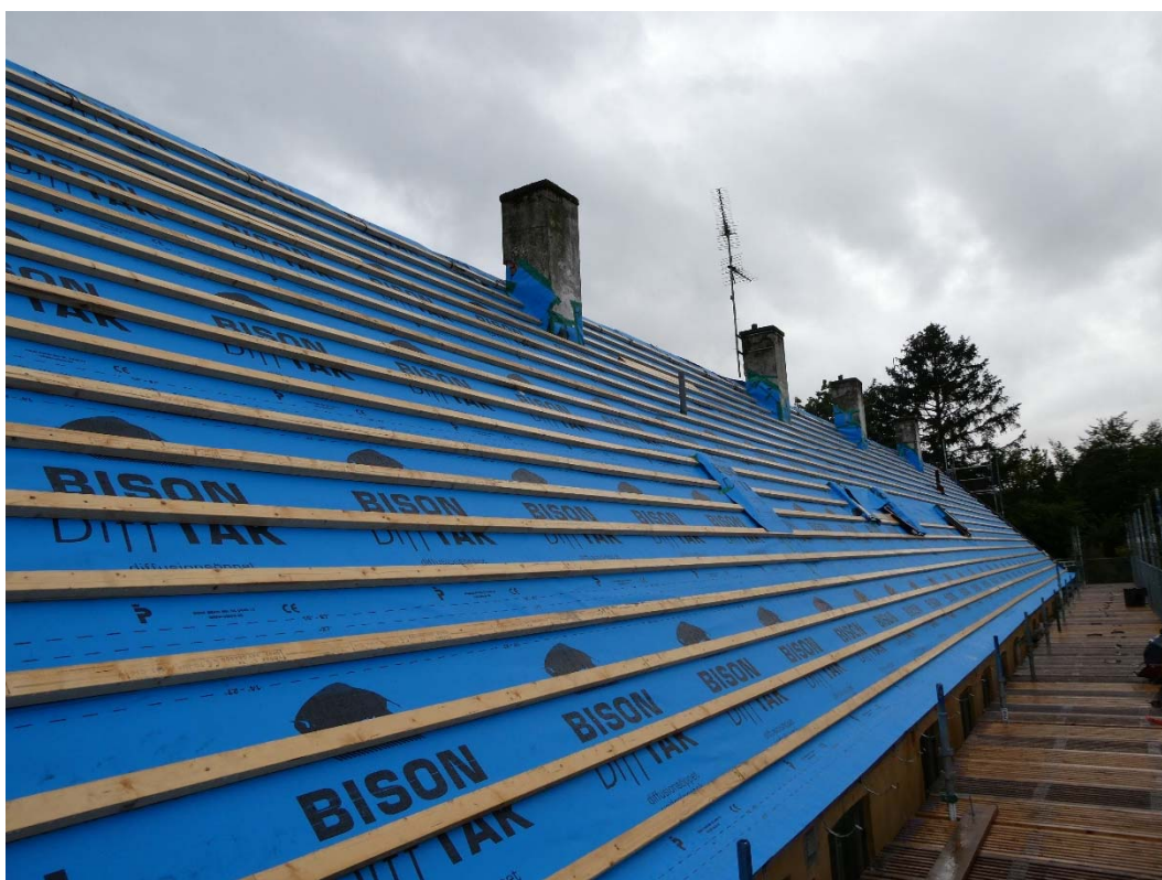
Under arbete. Norra takfallet.
