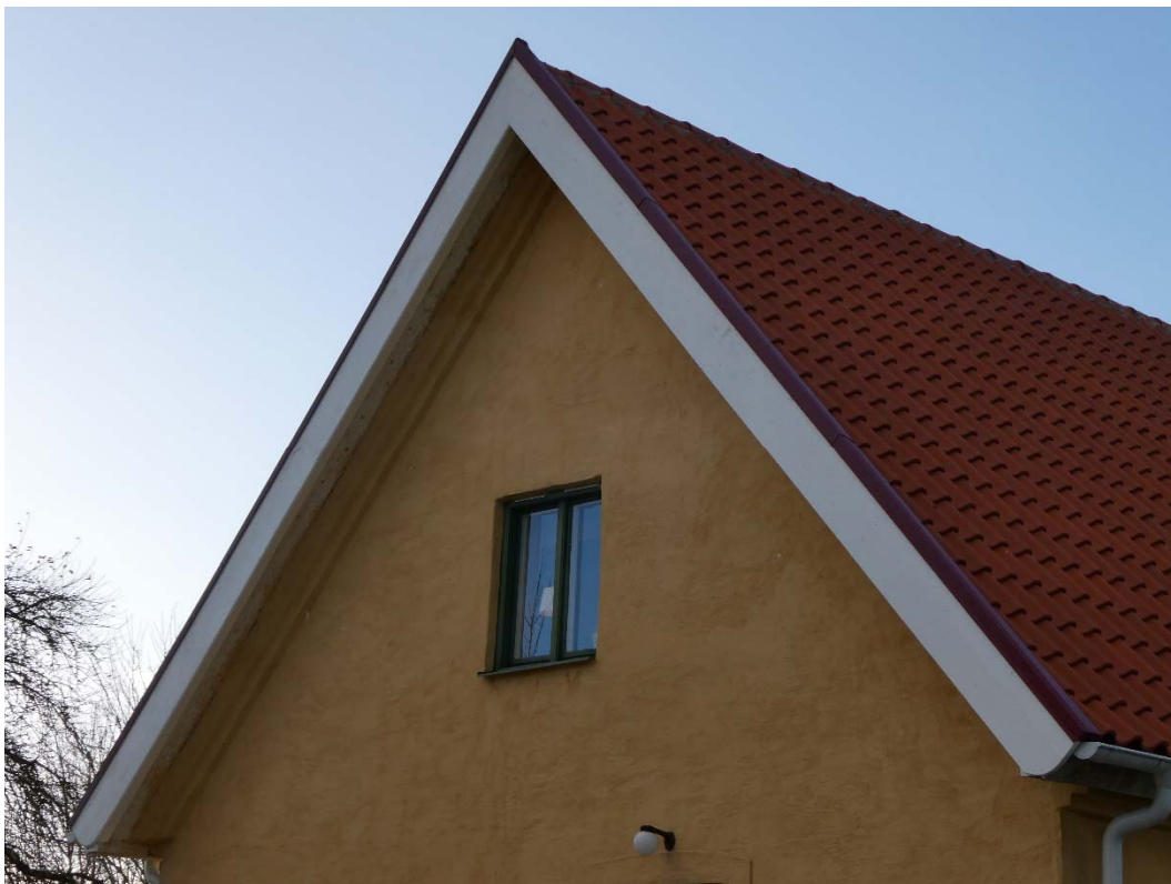
Efter åtgärder. Östra gaveln där den norra vindskivans övre halva ersatts (vindskivan till höger i bild).
