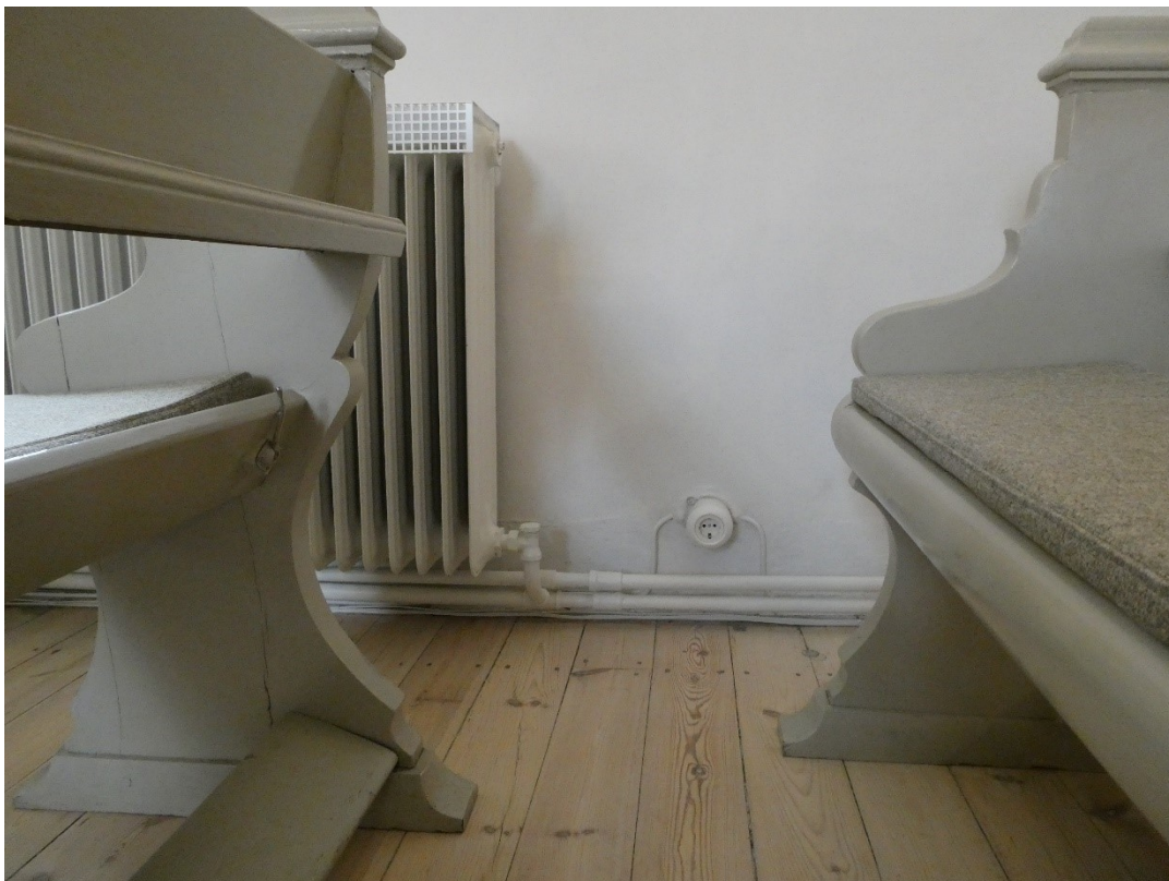
Efter åtgärder. Exempel på dammfilter på element, kabeldragning längs golv och ny eldosa.
