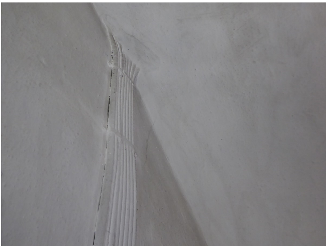
Före åtgärder, kabeldragning från orgelläktaren till vinden. Befintlig genomföring användes vid ny kabeldragning.
