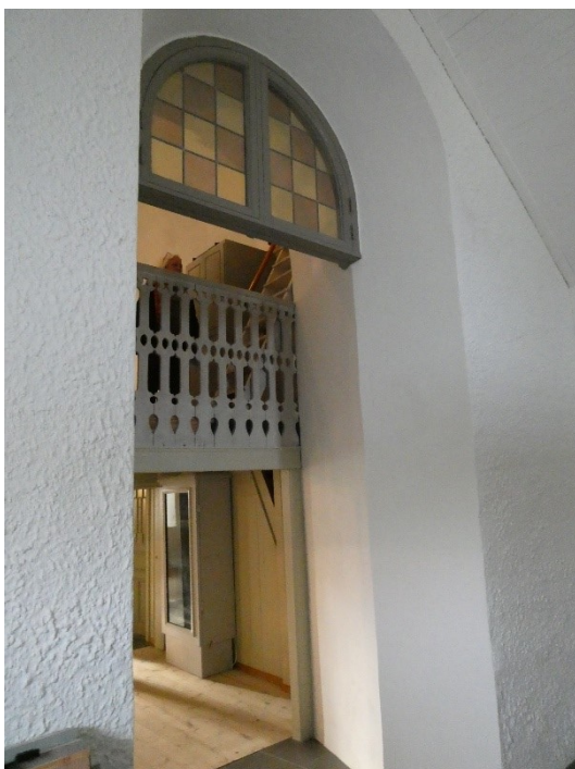
Efter åtgärder. Övre luftet av befintligt fönster i tornets norra mur lämnades kvar i den nya öppningen. Höger: Ytterdörr och dörr till pentry.
