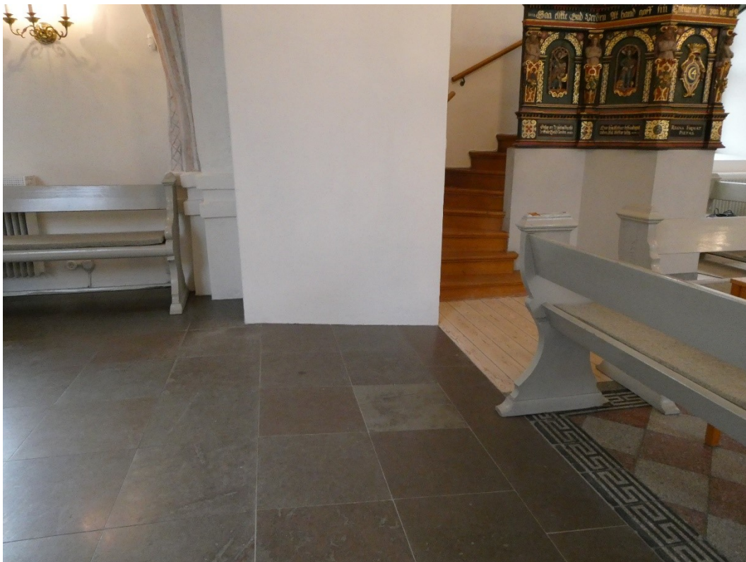
Efter åtgärder. Ramp mellan långhus och kor (bänkarna är provisoriskt placerade).
