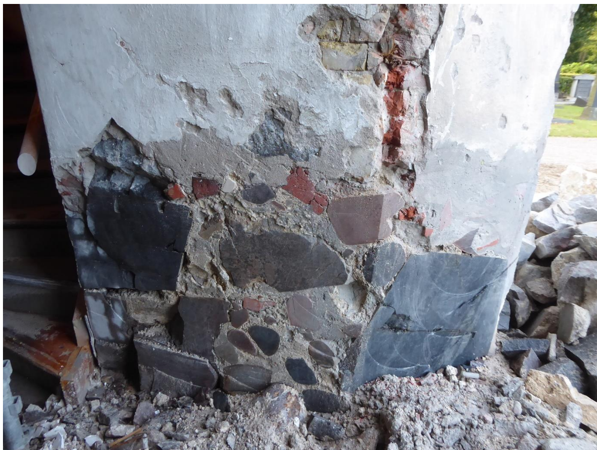
Figur 5. Vid håltagning 2019 ser man att murpartiet är uppbyggt av stora fältstenar och tegel där fönstret suttit.
