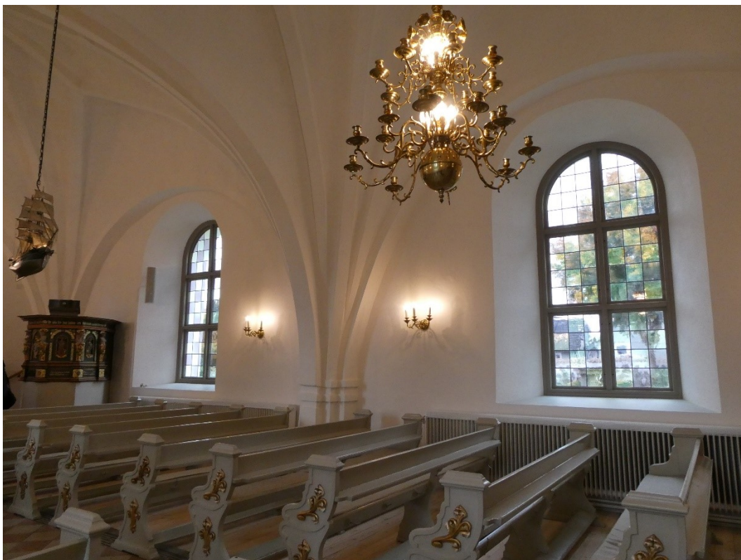
Efter åtgärder. Rengjorda valv och målade väggar och fönster.
