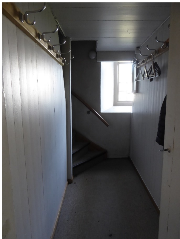
Före åtgärder. Vänster: Vindfånget, i golvet syns märke efter dörrens ursprungliga placering. Höger: Trappuppgång, trävägg till höger i bild revs och fönstret ändrades till dörröppning.
