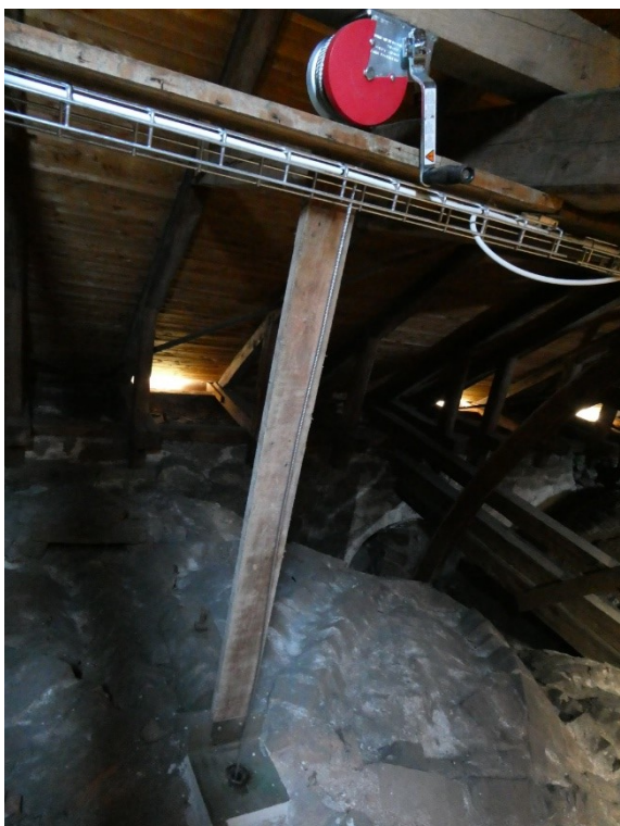
Efter åtgärder. Ny hissanordning till ljuskronor och kabeldragning i kabelstege.
