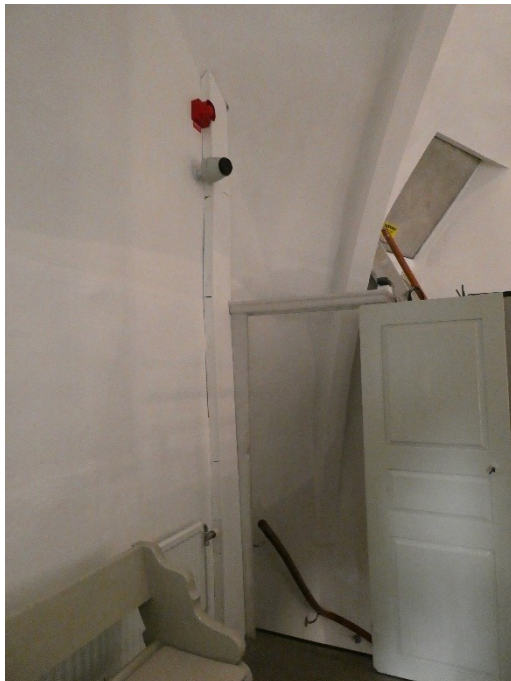
Efter åtgärder. Kabeldragning från orgelläktare till vind är dold i kanal av plast. Linjedetektor brandlarm på orgelläktare och invid predikstolen.
