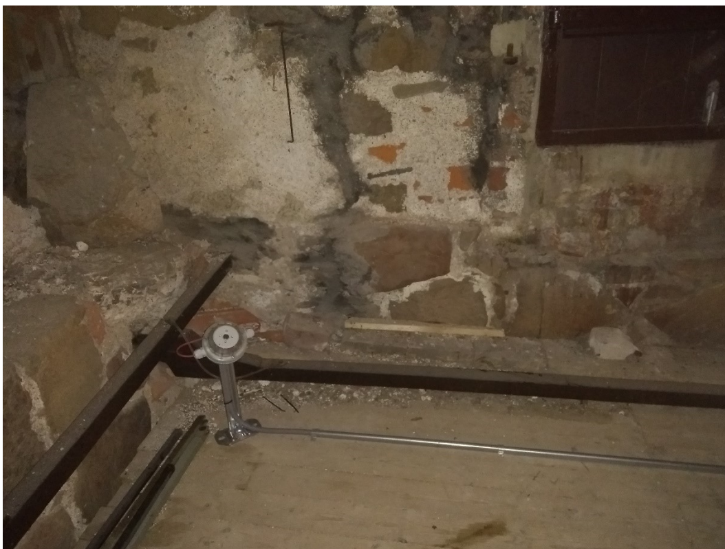
Efter åtgärder. Brandlarm i tornet.
