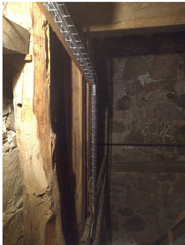
Efter åtgärder. Exempel på kabeldragning i tornet samt brandlarm.
