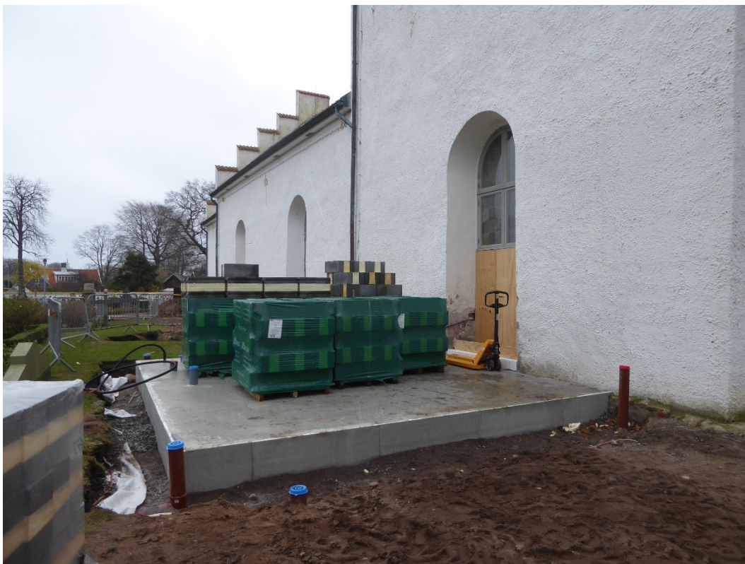
Gjuten platta för tillbyggnaden.
