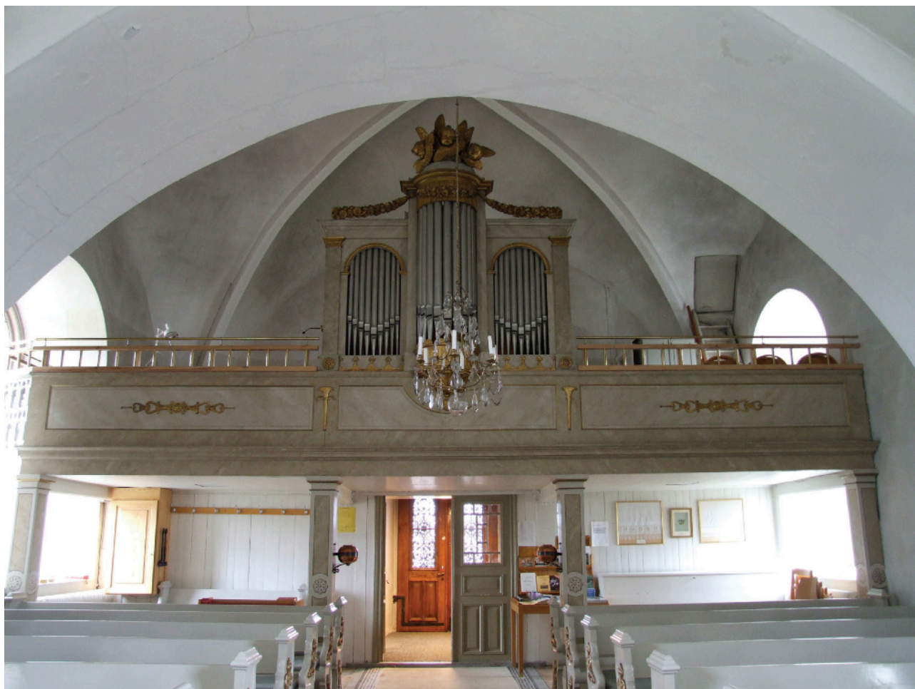
Bild i väster som visar den bortmonterade bräddväggen under orgelläktaren innan några arbeten påbörjats. De påträffade färgresterna har framkommit bakom bräddväggen till vänster.
