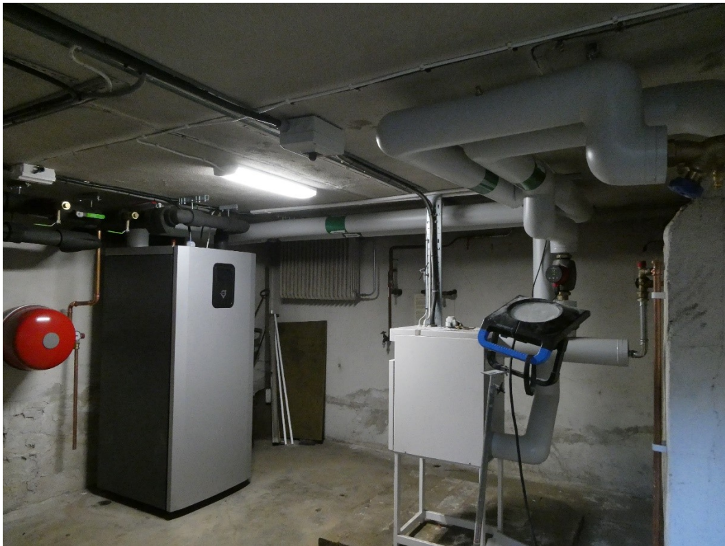
Efter åtgärder. Ny värmepump i källaren.
