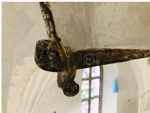
Skovelhjul i ribbkryss i långhuset. Stämpel HS på järn i valv i långhuset.
