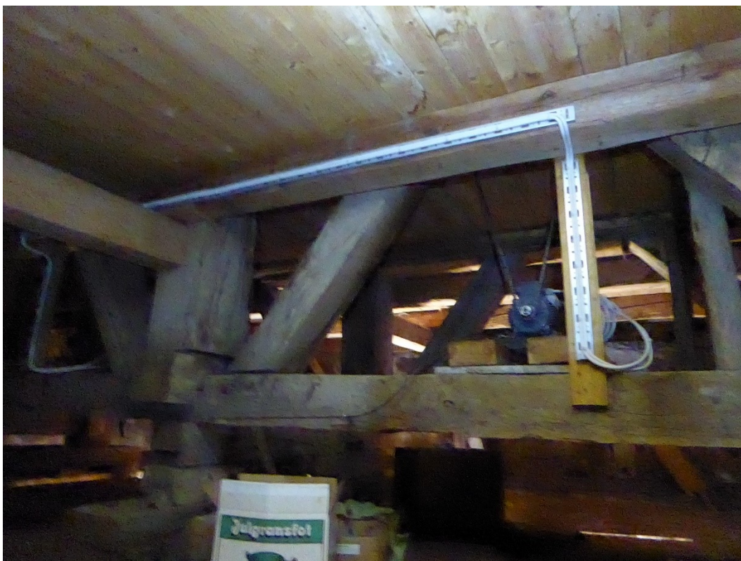
Före åtgärder, kabeldragning på vinden.
