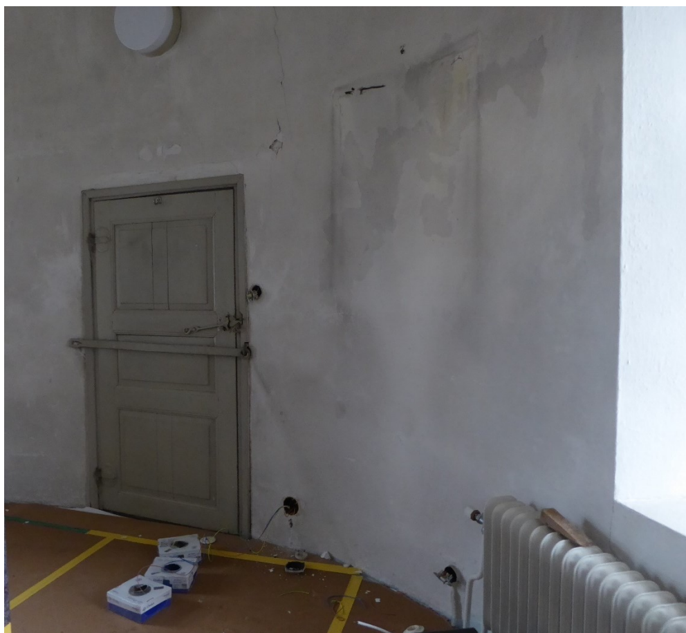
Före åtgärder, exempel på matning till lampetter.
