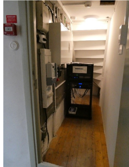
Efter åtgärder. Brandlarmcentral i tillbyggnaden, el-central i förråd under trappan till orgelläktaren.
