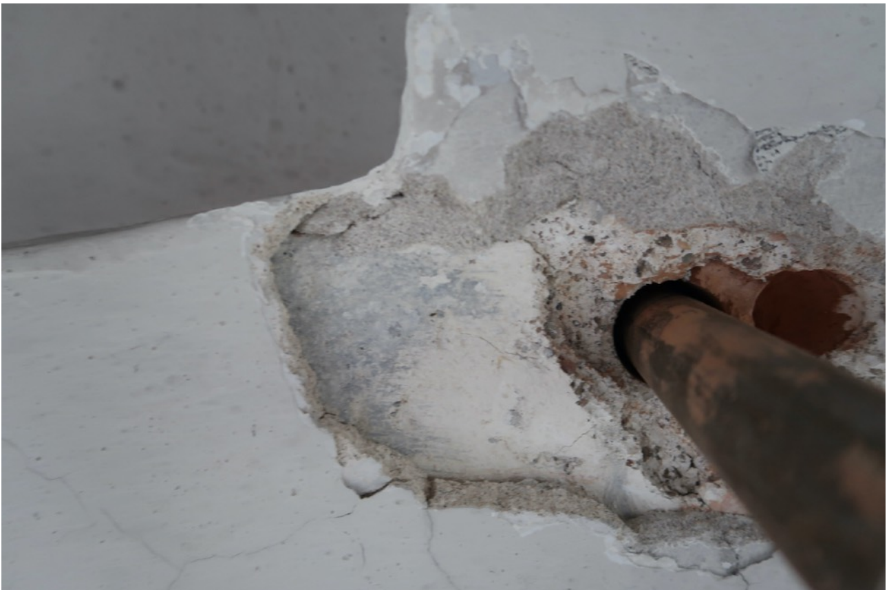
Ribbkrysset i andra valvtravén i väster. Genomförningen har bitvis skadat de underliggande puts- och kalkskikten. Rester av målning i grå/blått och rött.
