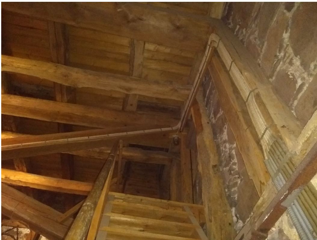
Före åtgärder. Kabeldragning på vinden, vid uppgången till vinden i tornet.
