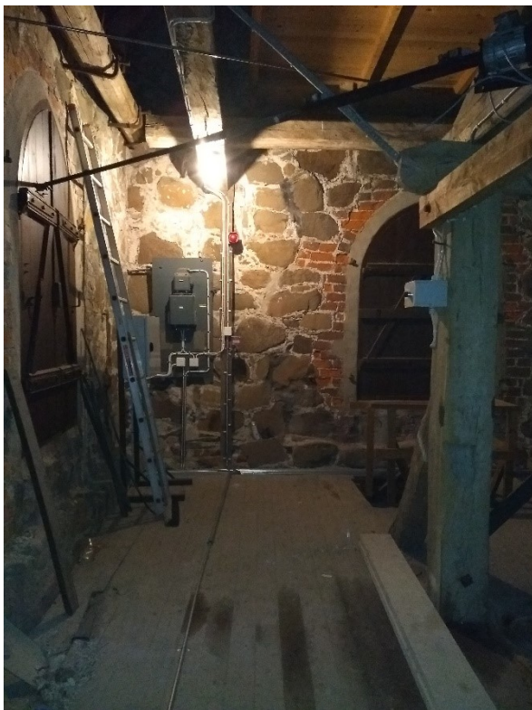
Efter åtgärder. Exempel på kabeldragning i tornet samt brandlarm.
