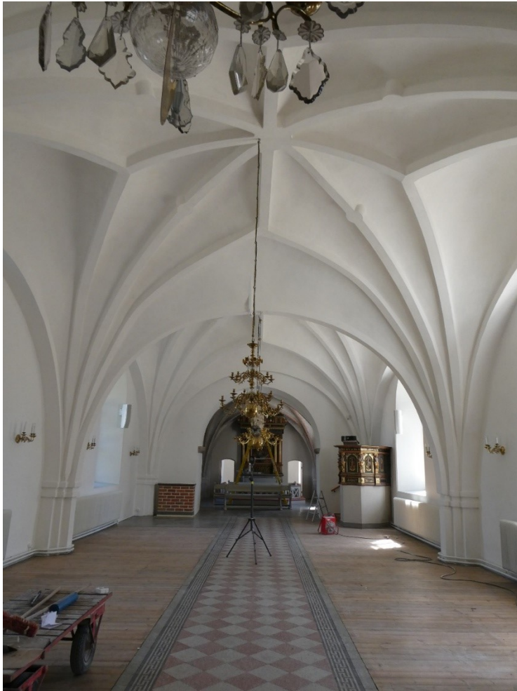
Under arbete. Återstår arbete med golv och återmontering av bänkar.
