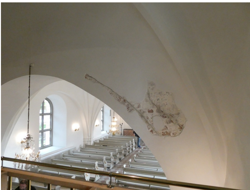
Efter åtgärder. Tegelyta som lämnades synlig vid valvet sett från orgelläktaren.
