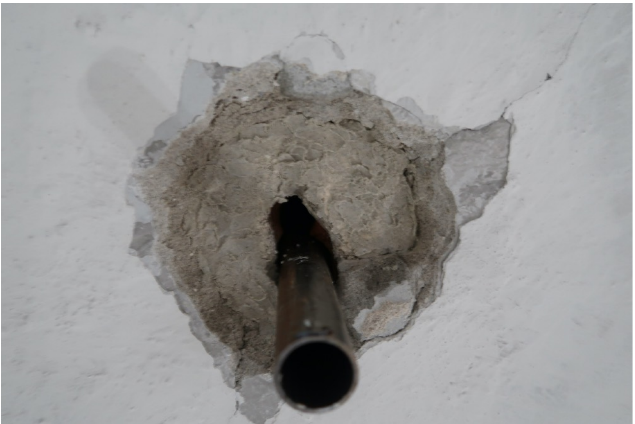
Lagning med rent kalkbruk.
