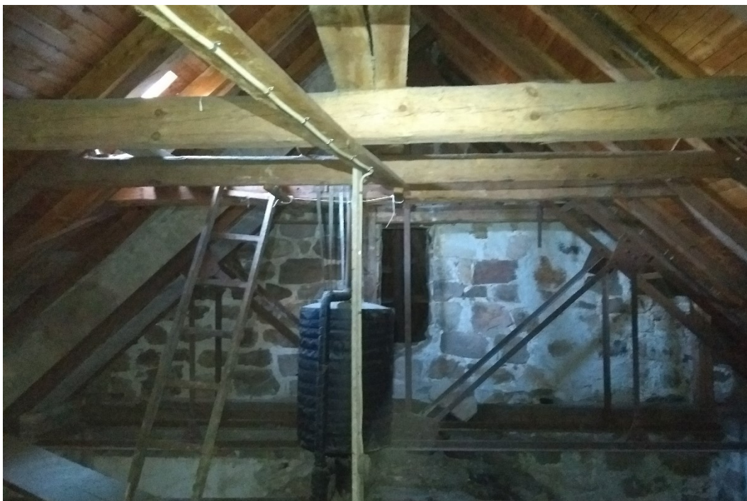
Före åtgärder. Kabeldragning på vinden, vid uppgången till vinden i tornet.
