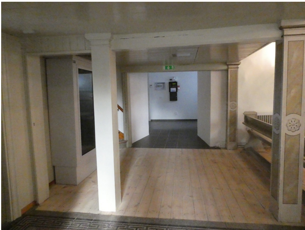
Efter åtgärder. Vy mot tillbyggnaden.
