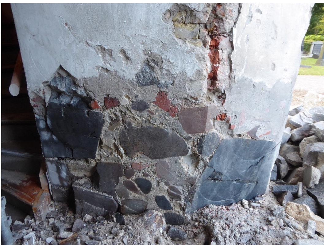
Västra sidan, håltagning för ny dörr.
