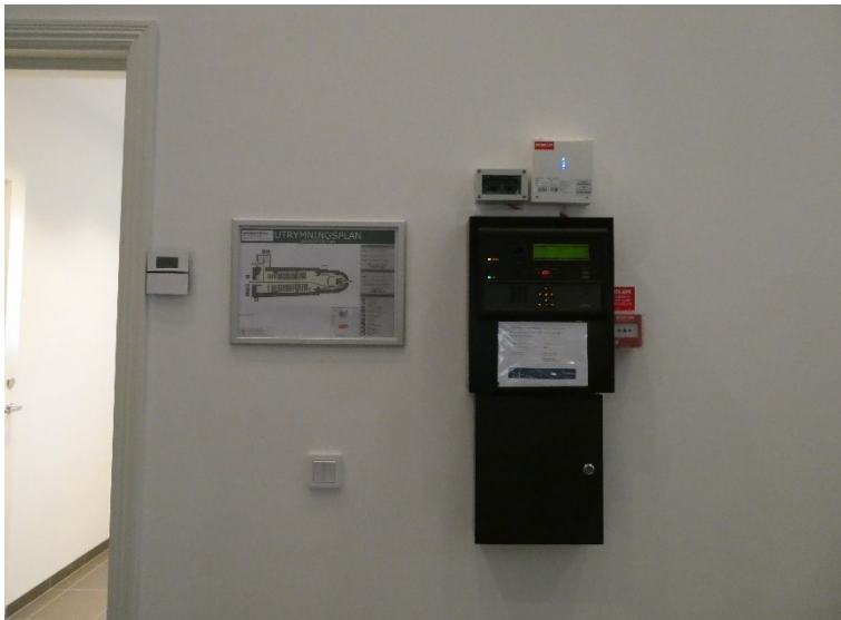
Efter åtgärder. Brandlarmcentral i tillbyggnaden, el-central i förråd under trappan till orgelläktaren.
