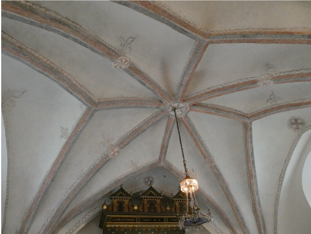
Efter åtgärder. Rökdetektor i koret, fäst längst upp i lampans upphängning.
