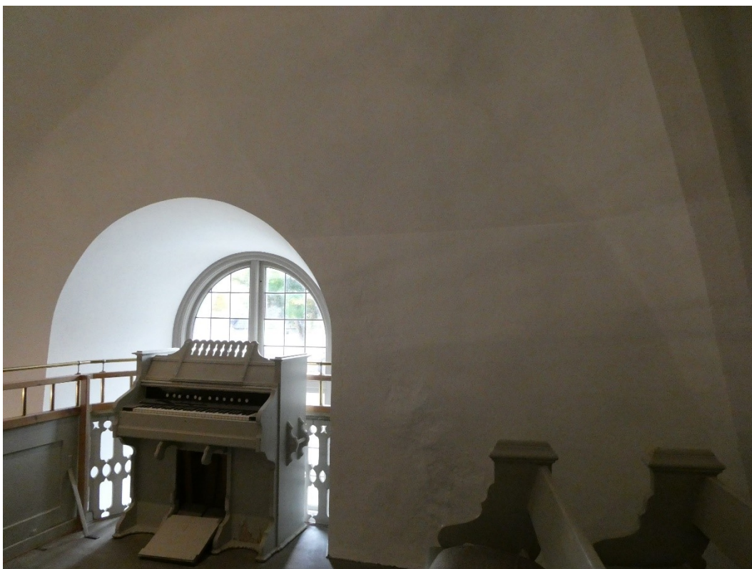
Efter åtgärder. Orgelläktarens södra vägg där det finns spår efter tidigare placering av vindstrappa.
