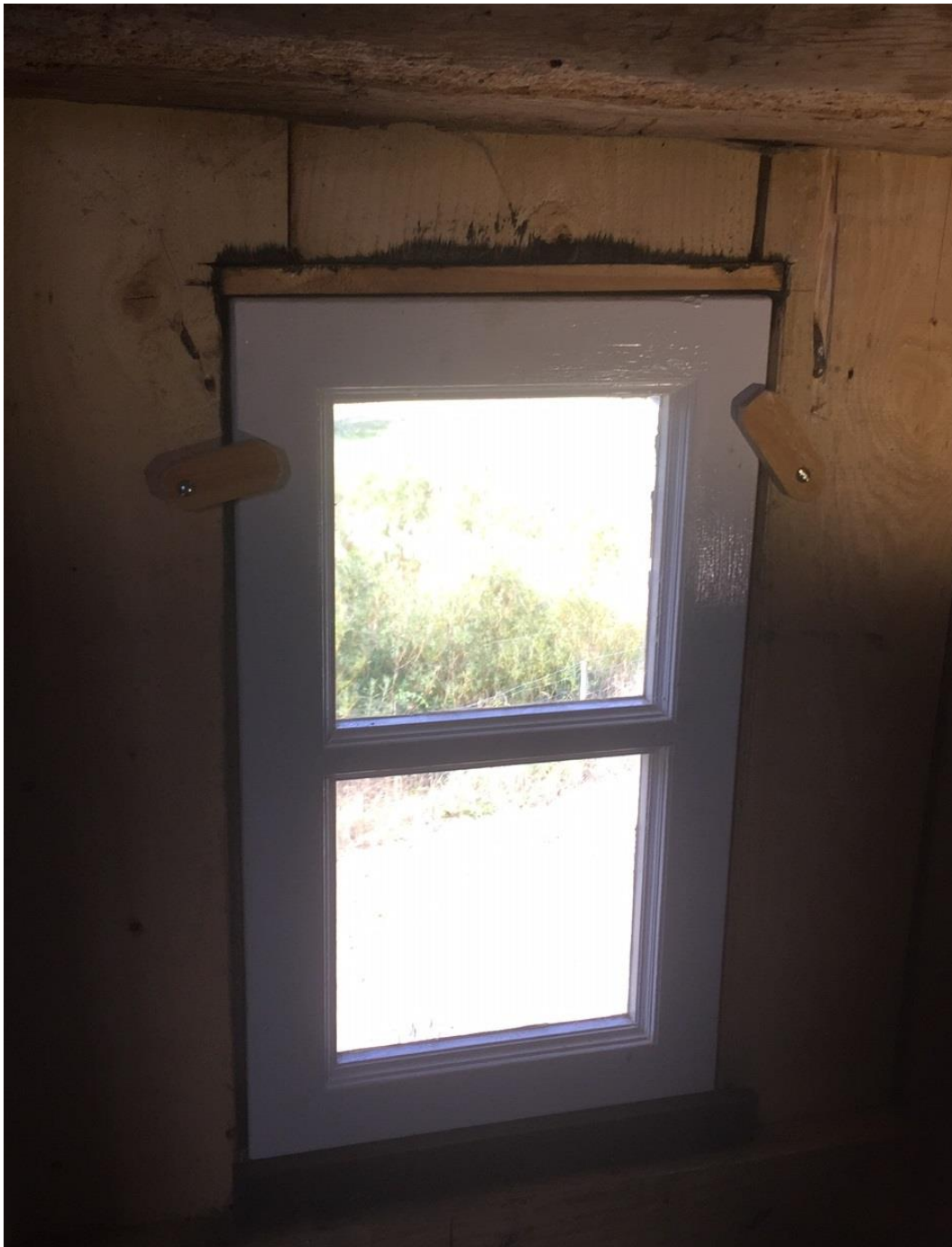
De nya fönstren fastsatta med invändiga trävred. En enkel avttningsbräda har monterats ovan fönsterbågarna för att förlänga livslängden på bågarna.
