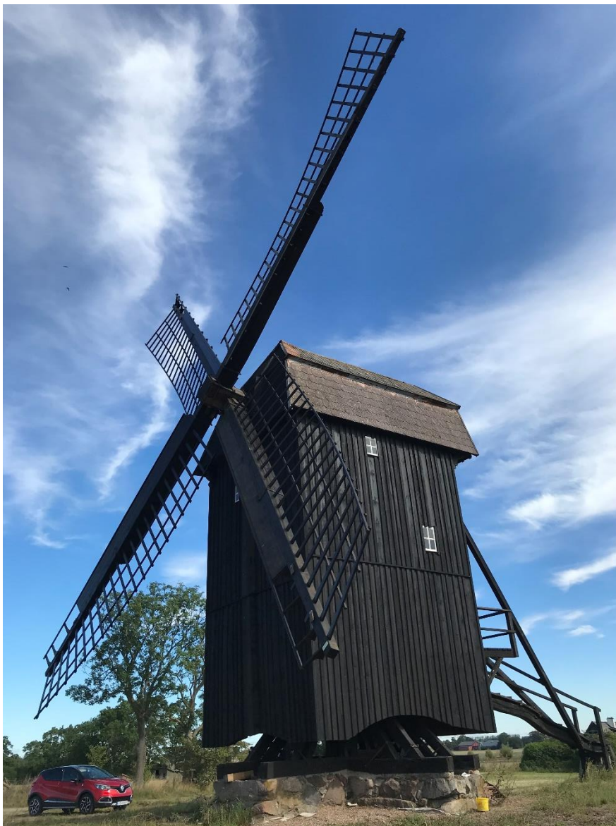
Foto av möllan med monterade vingar, dock utan stormbrädor vilka förvaras inne i möllan.
