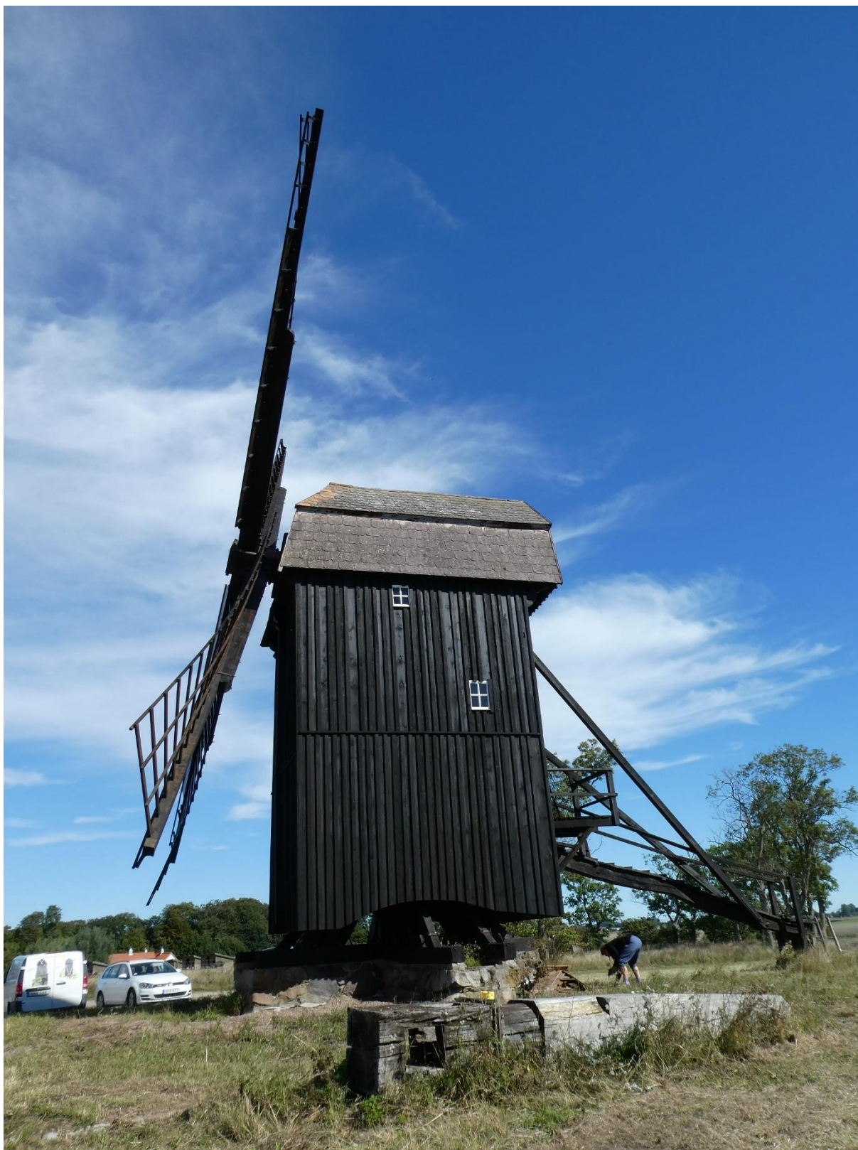
Foto efter montering av vingar och axel, den tidigare axeln från 1972 ligger i förgrunden.
