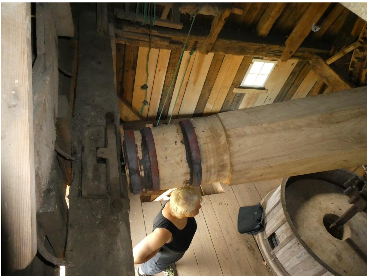
Foto av axeln med infästning i bjälken som kan skjutas i djupled om man i framtiden väljer att skifta till mindre stenar i möllan. Mindre stenar återknyter till ett mer ursprungligt utförande och ger mindre belastning på möllans konstruktion.
