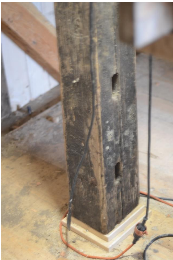
Foto på stämpan under kvarnstenarna som tidigare varit en vinge. Hålen till häckverken, utförda med borr och stämjärn, synliga till höger.
