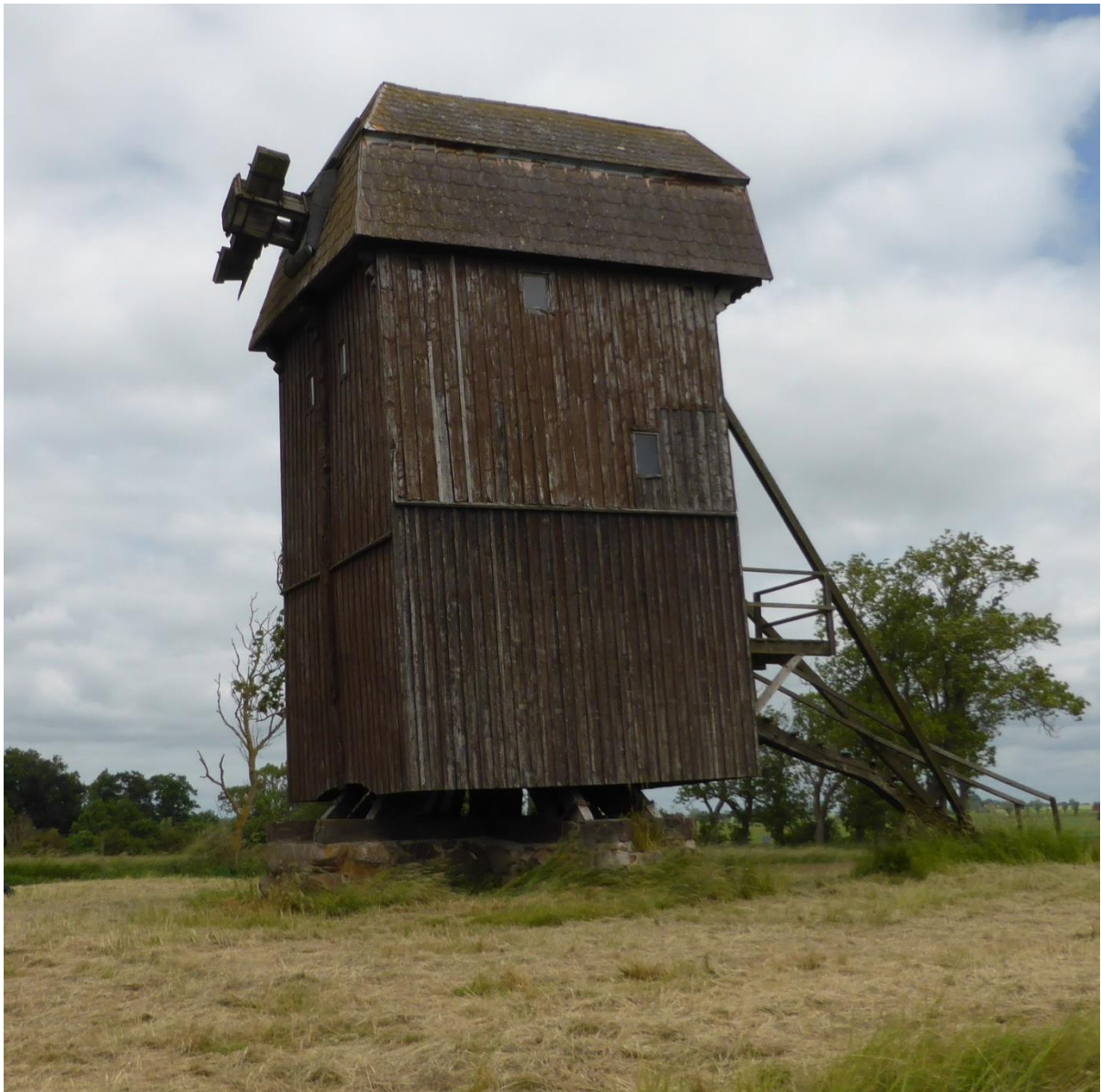
Foto på Håslövs mölla med den befintliga panelen, före renovering.
