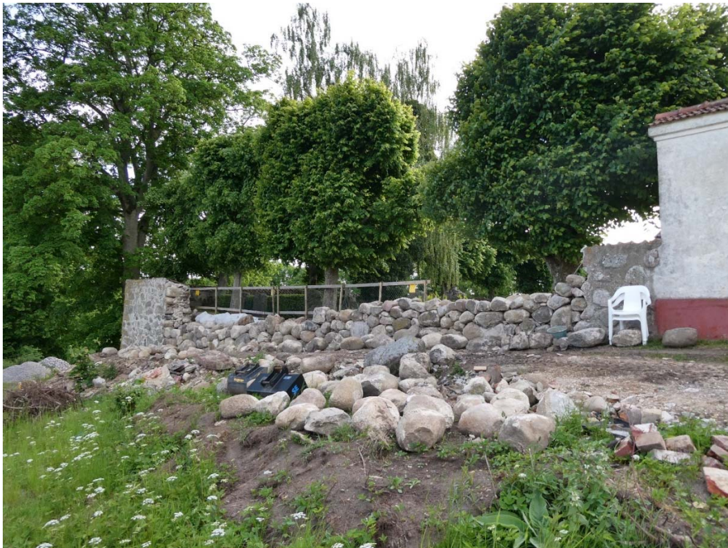
Under arbete, här skymtas markduk och dräneringsrör.
