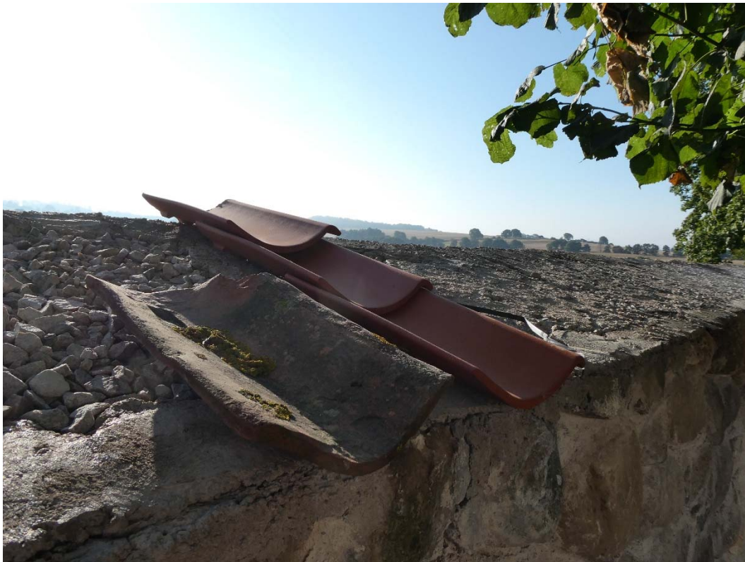
Under arbete. Krönet jämnas av med kross och ett bindande tunt påslag av betong. Jämförelse av befintliga tegelpannor och nya.
