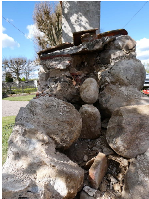
Före åtgärder. Vänster: vy mot söder. Höger: vy mot norr. De båda sidorna verkar inte varit identiskt murade.
