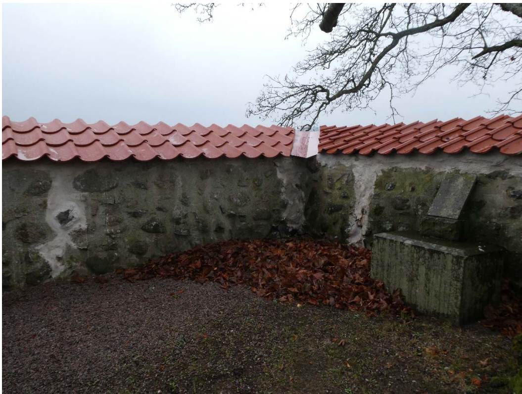
Efter åtgärder. Vissa lagningar av sprickor, nya täckpannor och plåt i rännan i hörnet.
