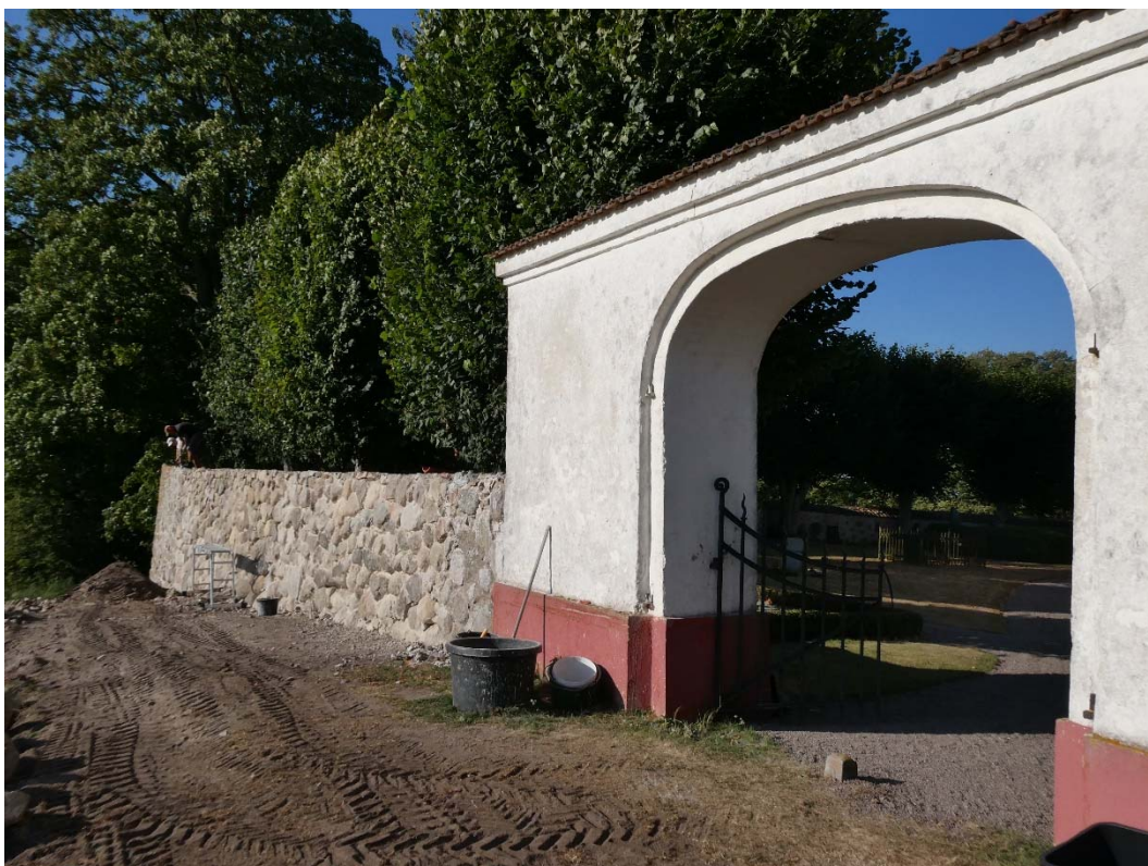
Under arbete. Krönet jämnas av med kross och ett bindande tunt påslag av betong. Jämförelse av befintliga tegelpannor och nya.
