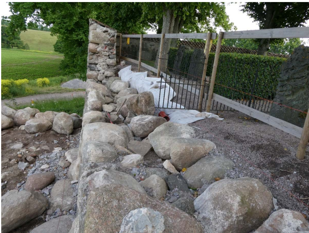
Under arbete. Längst ner lades större stenar. På bilden ses även bindande sten, skolsten samt kross mitt i muren.
