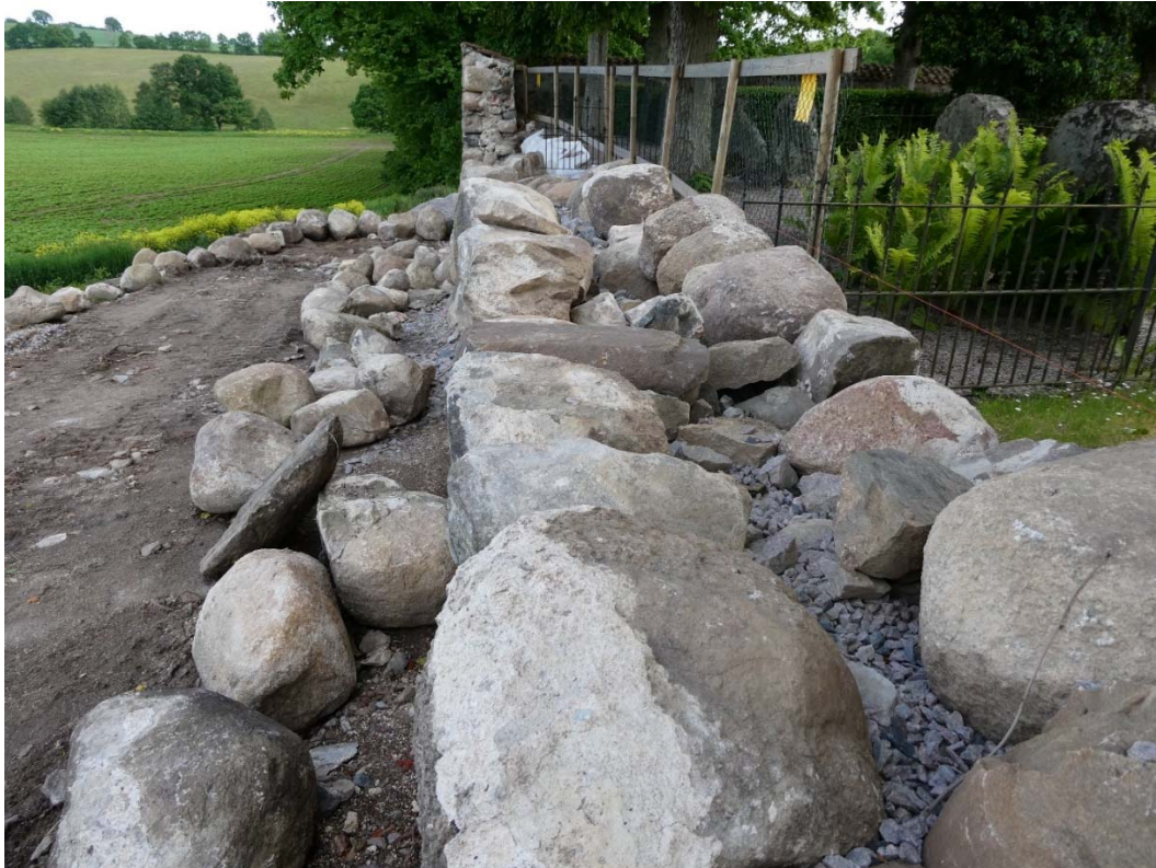
Under arbete. Längst ner lades större stenar. På bilden ses även bindande sten, skolsten samt kross mitt i muren.
