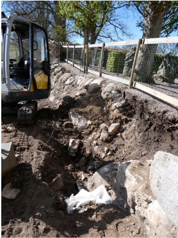
Under arbete, här skymtas markduk och dräneringsrör.
