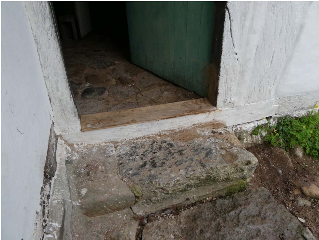
Efter åtgärder vid östra dörren. Lagning med lera i stolpens nedre del, till höger om dörren.
