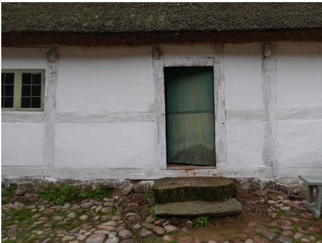
Efter åtgärder. Nytt fotträ och kalkning vid mittersta dörren.
