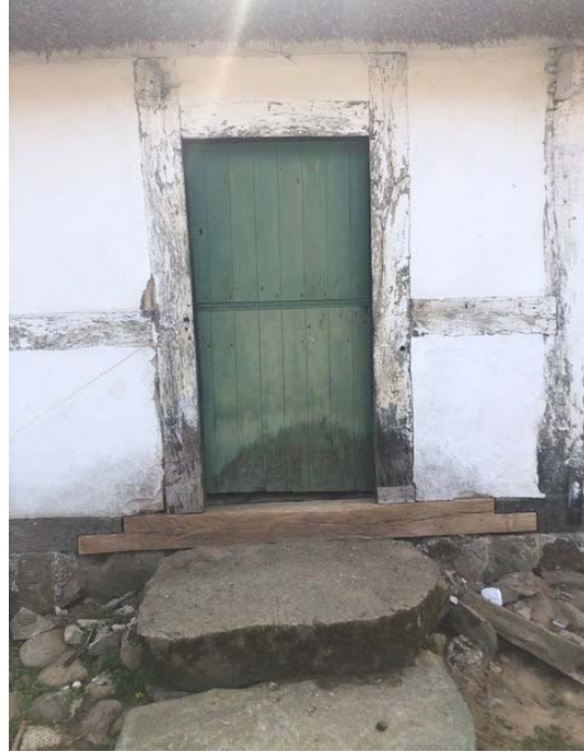
Vid mittersta dörren under arbete. Vänster: Befintligt fotträ är bortmonterat. Höger: Nytt fotträ är monterat.
