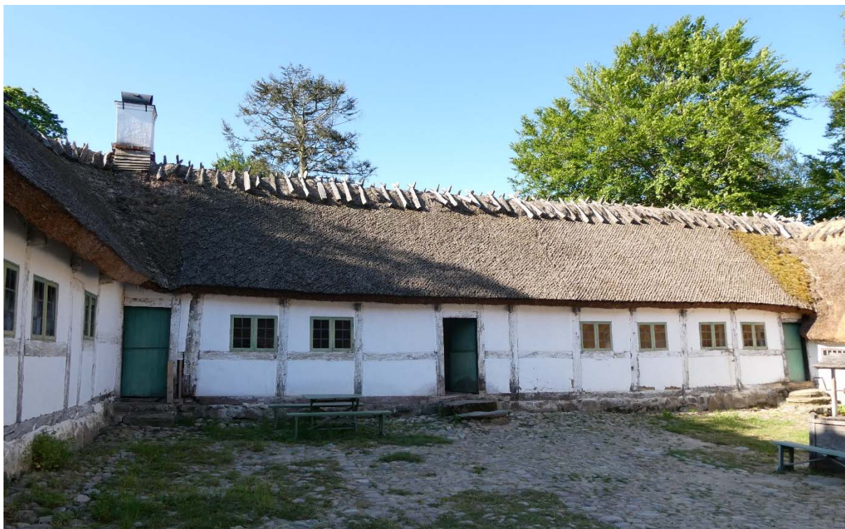
Före åtgärder ovan, efter åtgärder nedan. Södra längans norra fasad.
