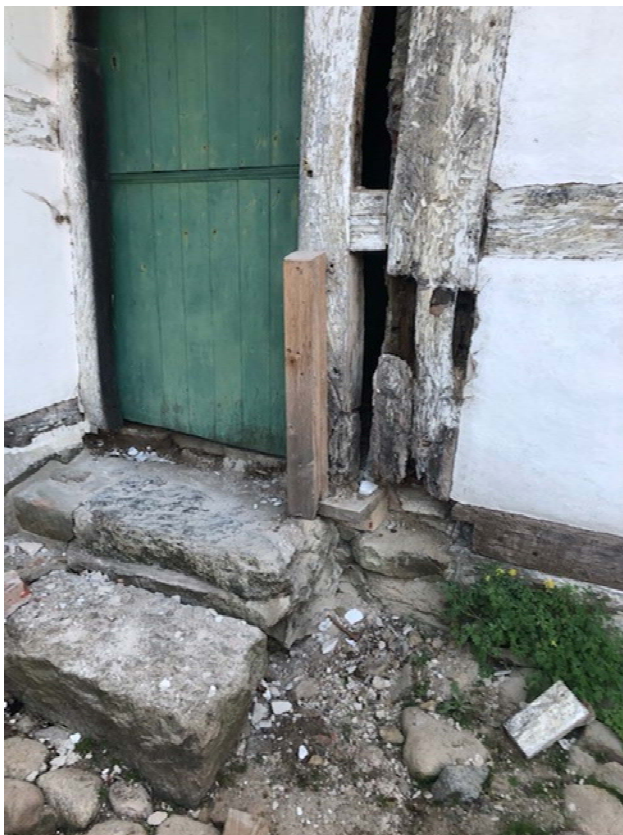
Vid östra dörren. Under arbete, under korsvirkesstolpen och i övre fack fanns sedan tidigare lagning/uppstämpling med rött maskinslaget tegel.
