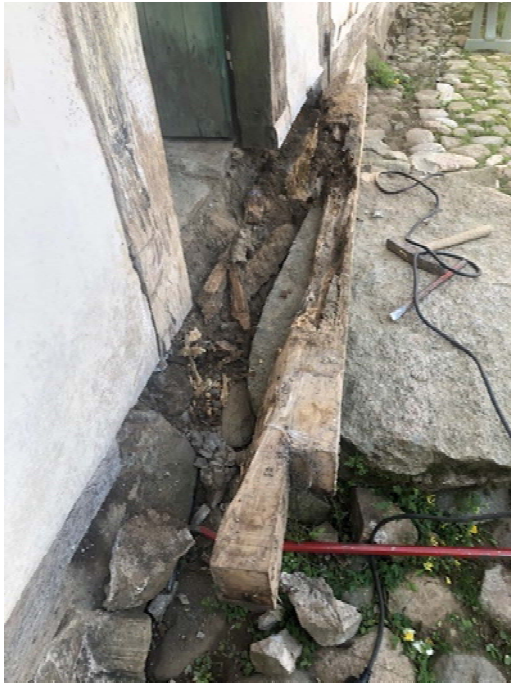
Vid mittersta dörren under arbete. Vänster: Befintligt fotträ är bortmonterat. Höger: Nytt fotträ är monterat.
