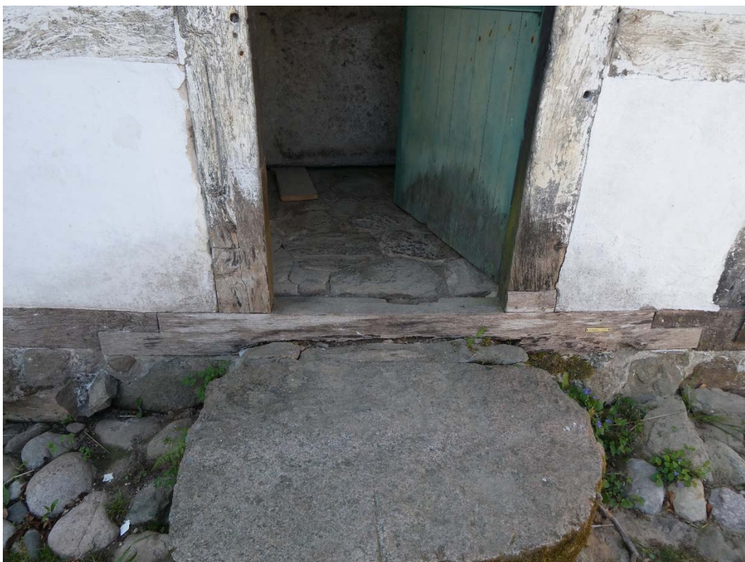
Efter åtgärder vid östra dörren. Lagning med lera i stolpens nedre del, till höger om dörren.
