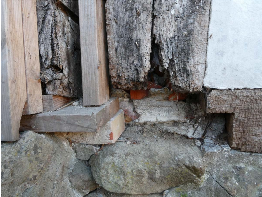
Vid östra dörren. Under arbete, under korsvirkesstolpen och i övre fack fanns sedan tidigare lagning/uppstämpling med rött maskinslaget tegel.
