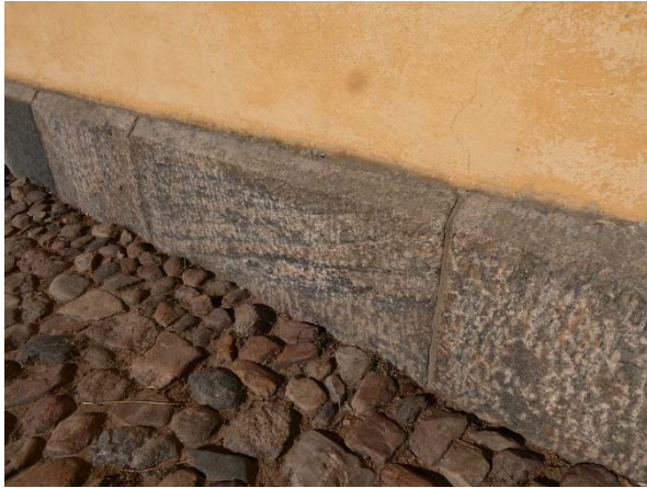
Före åtgärder. Fogad sockel. Stenen spjälkar paritellt.
