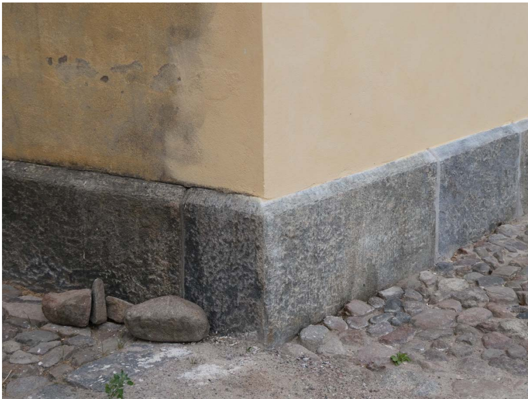
Efter åtgärder. Omputsad fasad, rengjord och omfogad sockel till höger i bild. Fasaden till vänster i bild har inte ingått i arbetet.
