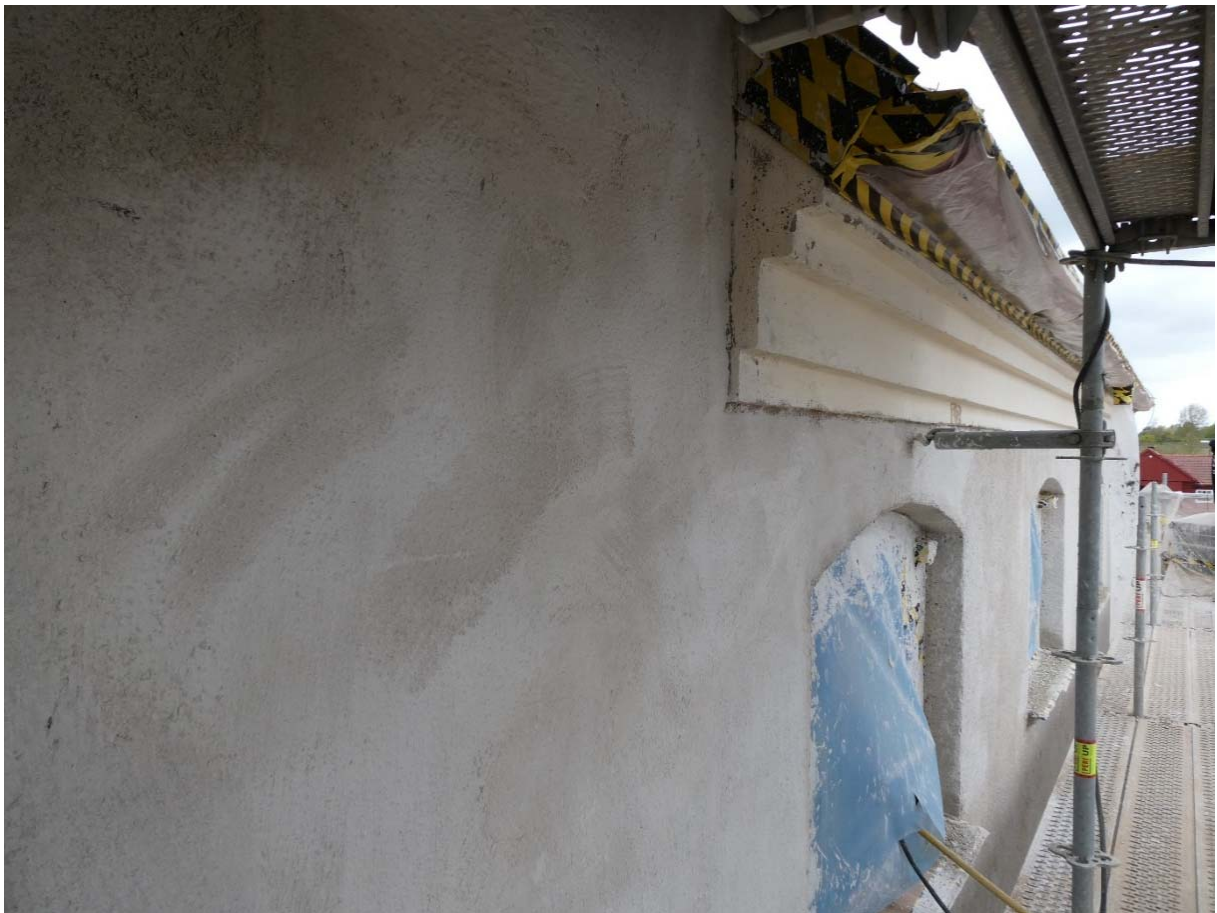
Under arbete. Grundputsning fasad och lagning takfotsgesims pågår.
