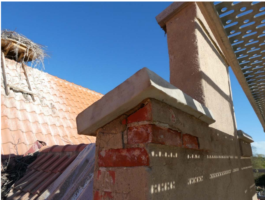
Före åtgärder. Fogad sockel. Stenen spjälkar paritellt.
