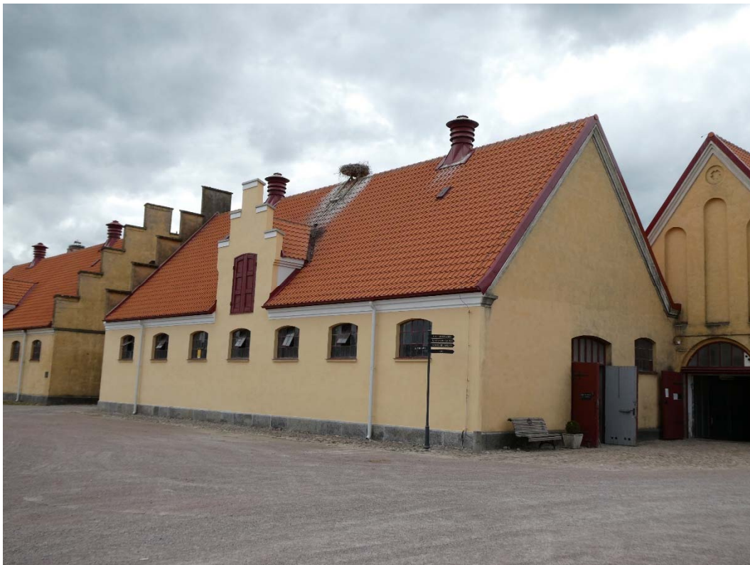
Efter åtgärder, östra fasaden.
