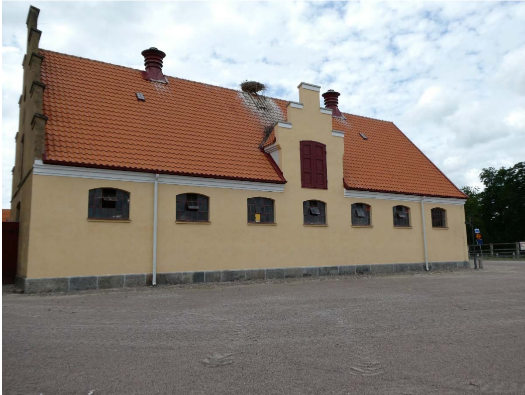
Efter åtgärder, östra fasaden.
