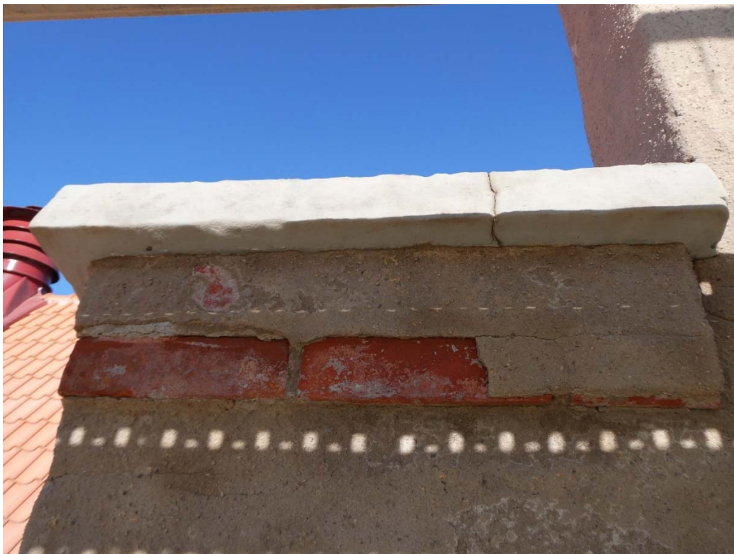
Under arbete med frontespisen. Den södra täckplattan näst längst upp var sprucken och har lagats. Täckplattan längst upp är gjuten i betong, övriga är av sten.
