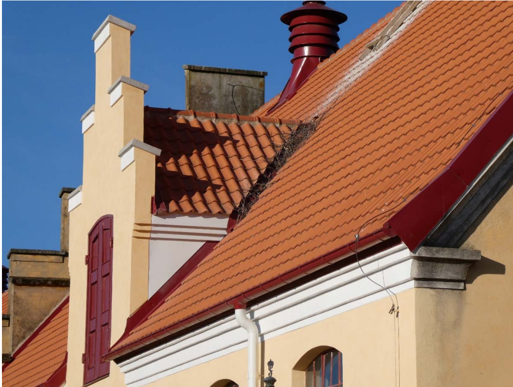
Efter åtgärder. Frontespisen och takfotsgesims (gaveln till höger i bild har inte ingått i arbetet).
