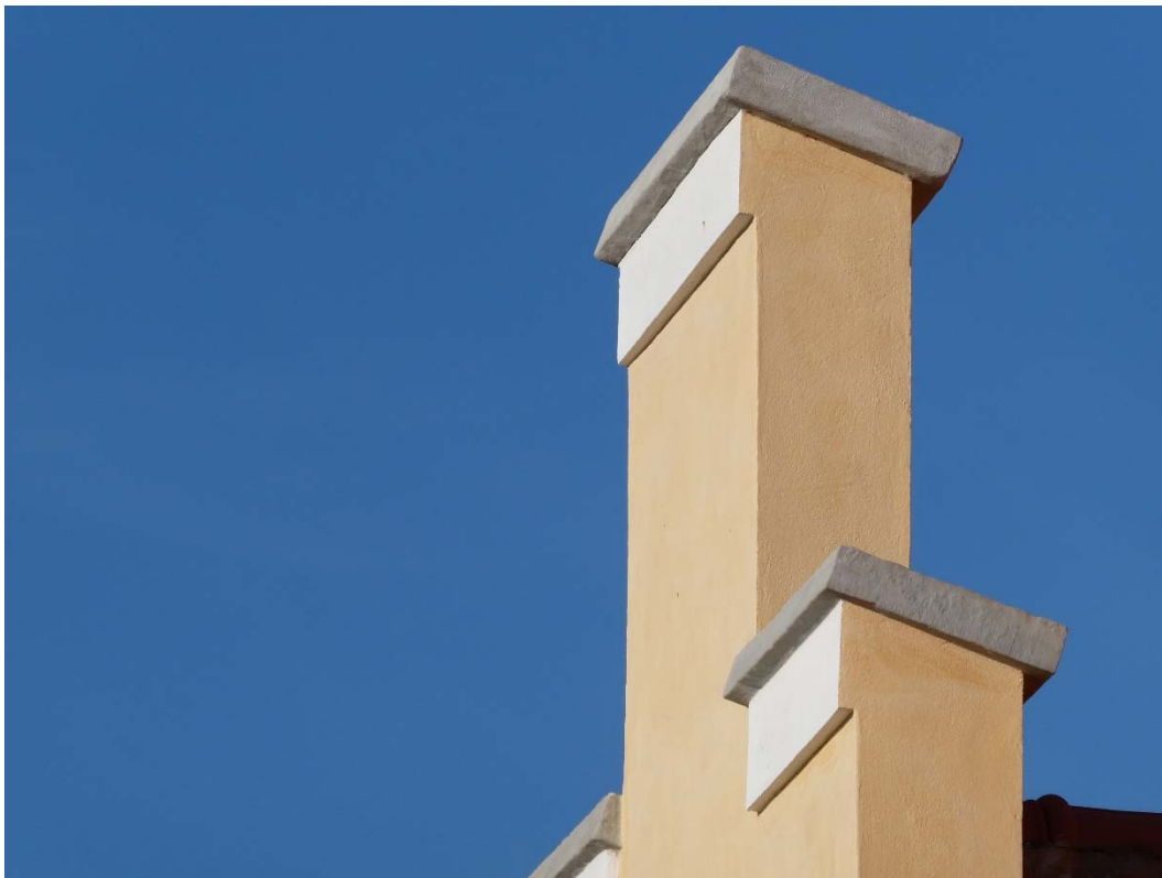
Efter åtgärder. Krönplattorna på frontespisen är rengjorda och lagade, vitmålat på listen under plattorna.
