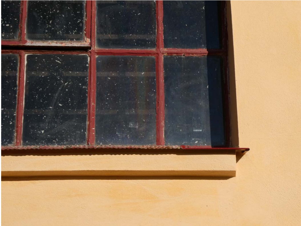
Efter åtgärder. Fönstret mitt på fasaden hade skada fönsterbleck som lagats med plåt.
