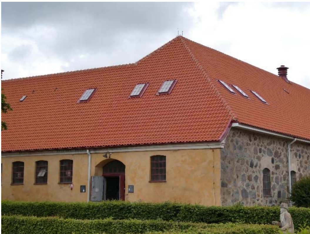
Efter åtgärder. Elevstallets västra takfall och möte med Stora hingststallet. .
