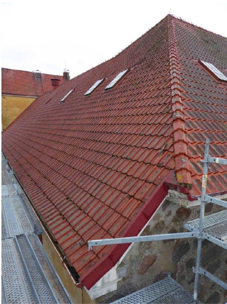
Före åtgärder, västra takfallet möte mot Stora hingststallet, på bilden syns även takfönster före åtgärder.
