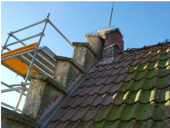
Före och efter åtgärder, skorsten och anslutning mot trappgavel (puts måls i samband med kommande fasadarbeten).
