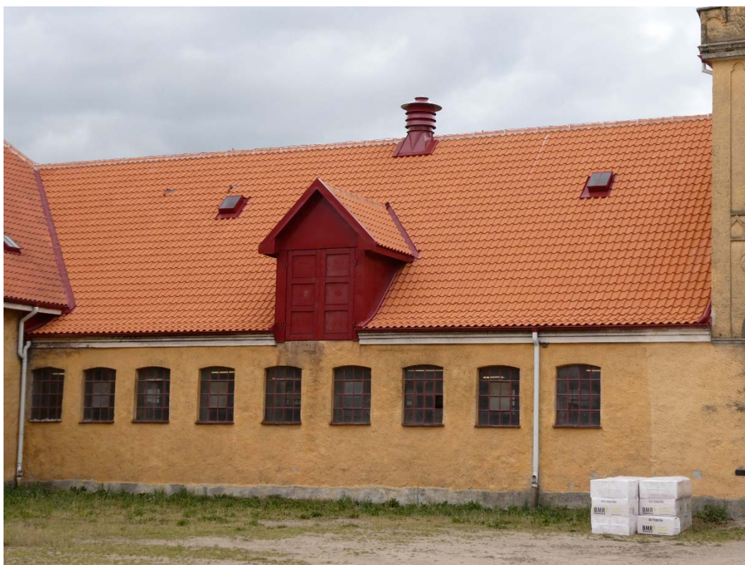
Efter åtgärder. Elevstallet östra takfallet.
