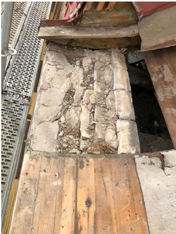
Vänster: takfot invid takkupan lagades. Höger: takfot mot brandtornets fasad lagades.
