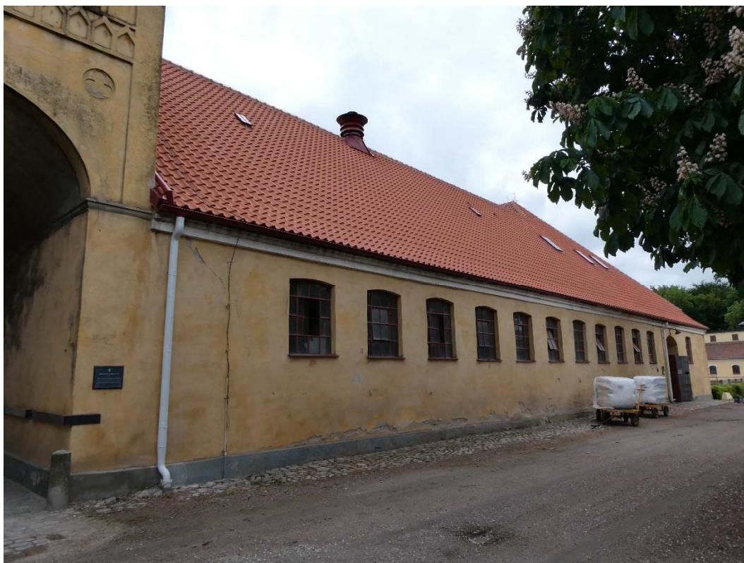
Efter åtgärder. Elevstallet västra takfallet.
