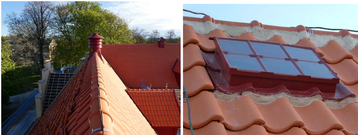
Vänster: Murning avnocken pågåår, Elevstallet. Höger: Efter åtgärder, muradnock och fönster på Brandtornet.
