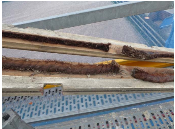
Vänster: Under arbete med att ta bort den gamla hänggrännen. Höger: Borttagen råspont, under nedersta råsponten fanns ett längsgående rep.
