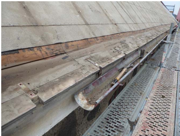
Vänster: Under arbete med att ta bort den gamla hänggrännen. Höger: Borttagen råspont, under nedersta råsponten fanns ett längsgående rep.
