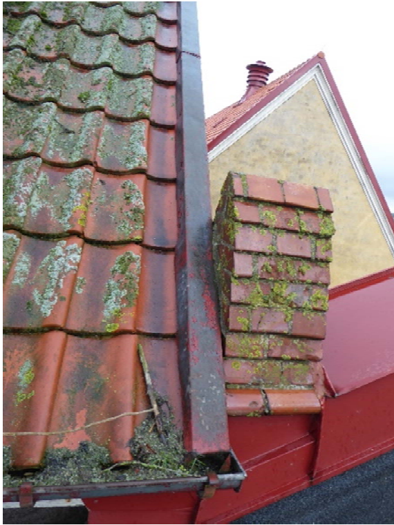
Före och efter åtgärder, vindskiva av plåt mot öster.
