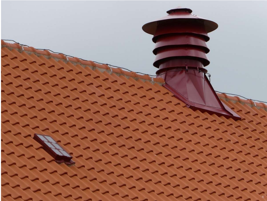
Efter åtgärder, exempel på takfönster, muradnock och ny ventilationshuv.
