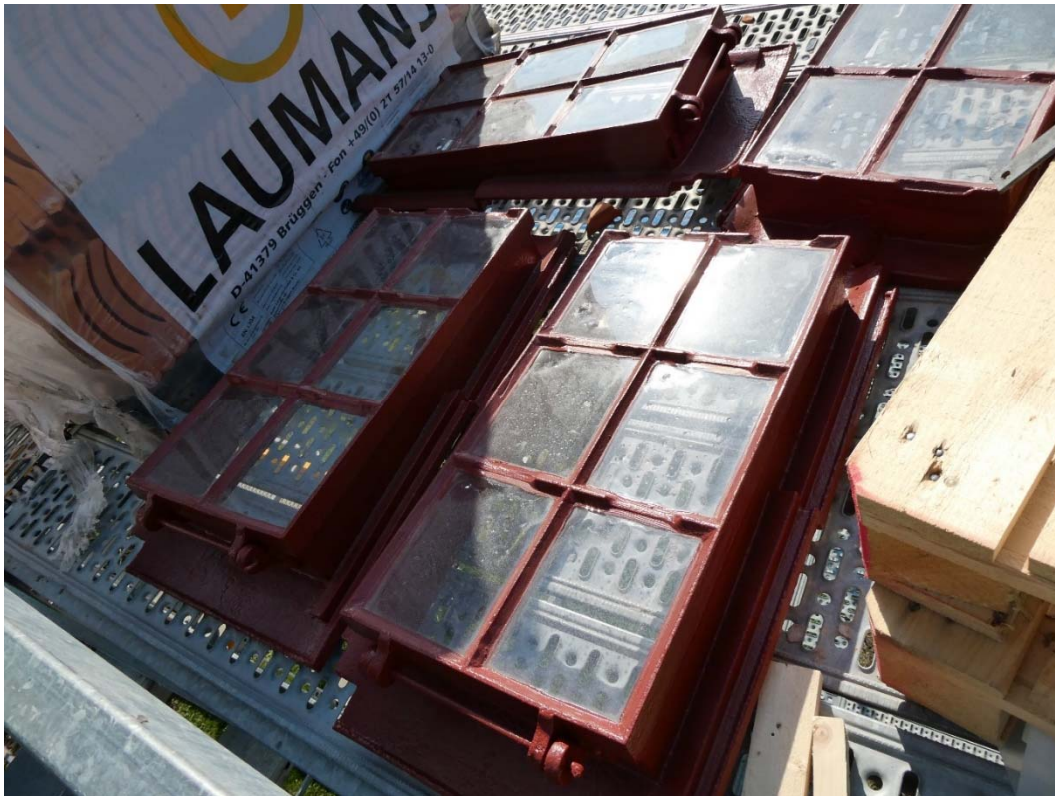
Takfönster under arbete, färdiga att återmonteras.
