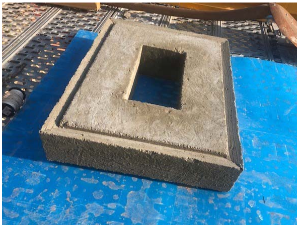
Ny gjuten skorstenskrona, bilden visar undersidan.
