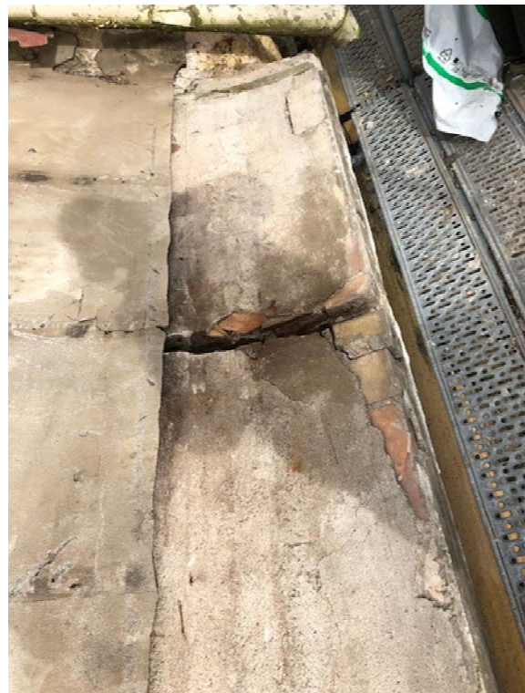
Vänster: takfot invid takkupan lagades. Höger: takfot mot brandtornets fasad lagades.
