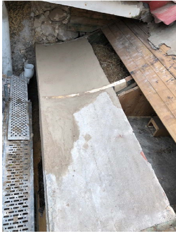
Vänster: Östra takfallet takfot, delen längst mot söder muras om. Höger: lagning av takfotstass med nytt virke samt ny pågjutning.
