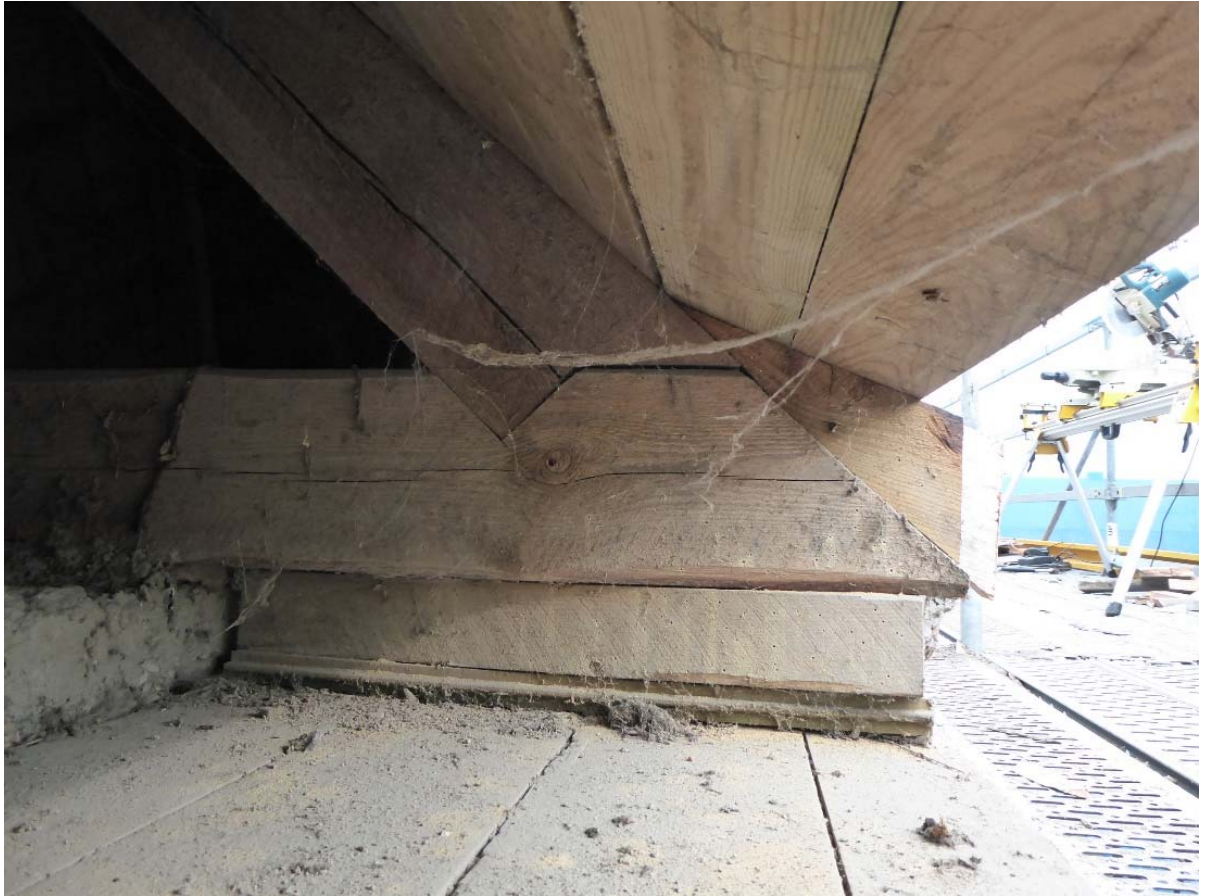
Under arbete. Takstolens konstruktion behölls men förstärktes med ytterligare en träkil.
