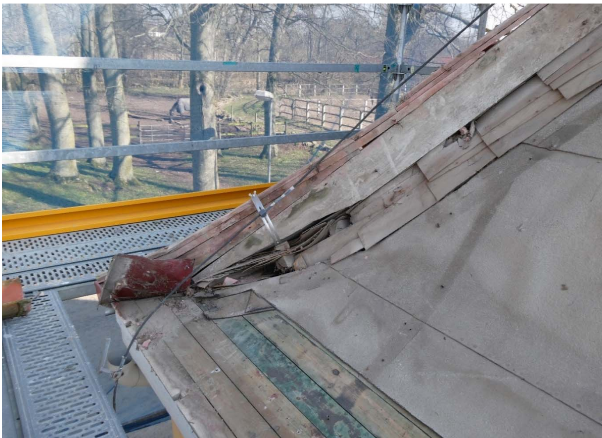
Under arbete. Vänster: Virket i gott skick på kupan. Höger: Anslutning mot trappgaveln på västra takfallet.
