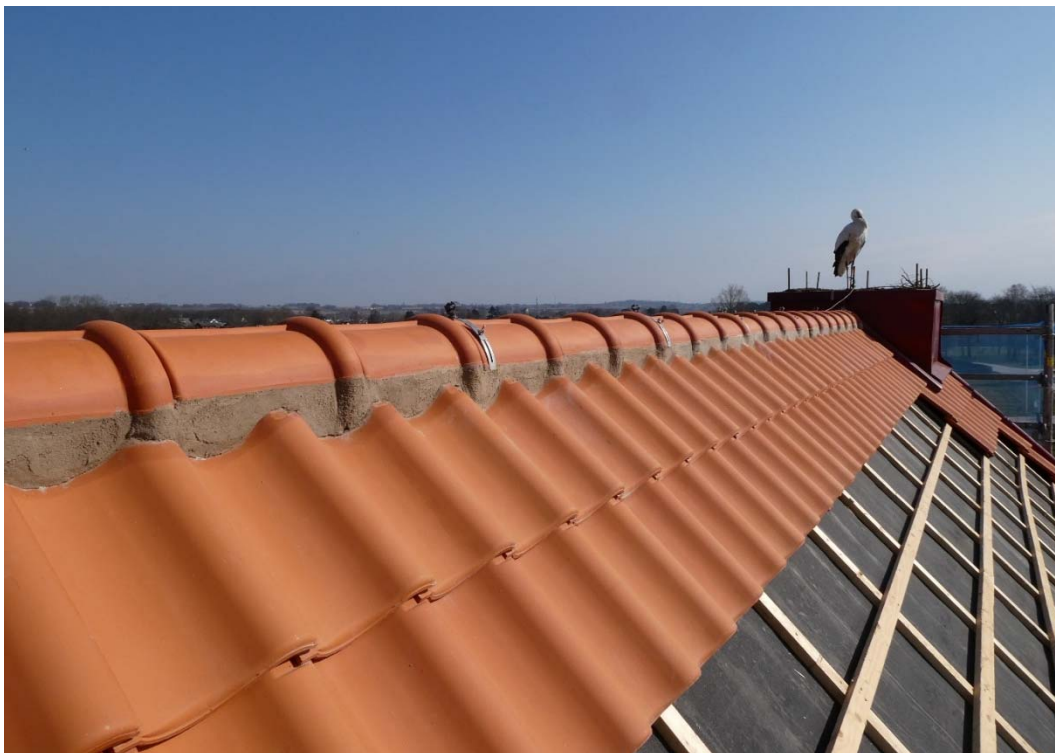
Nocken muras på Stora hingststallet.
