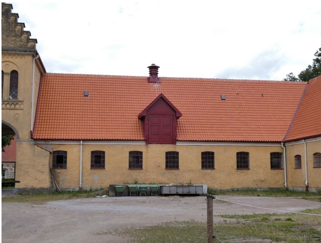
Efter åtgärder. Östra takfallet.
