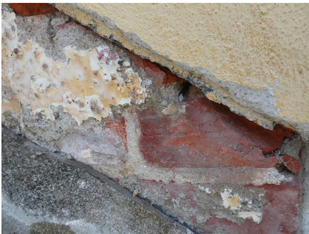
Brandtornets nordvästra fasad. Spår av underliggande gulmålad spritputs samt ritsad tegelfog.
