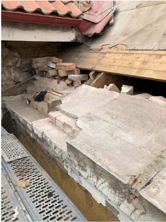
Vänster: Östra takfallet takfot, delen längst mot söder muras om. Höger: lagning av takfotstass med nytt virke samt ny pågjutning.
