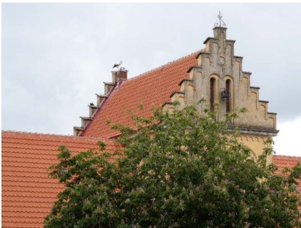
Efter åtgärder, Brandtornet sett från öster och väster. Räcket kring takfönstret har tagits bort.
