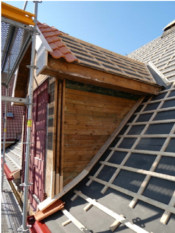
Skadat virke har ersatts i nedre delen av kupans båda sidor, ny vindskiva.
