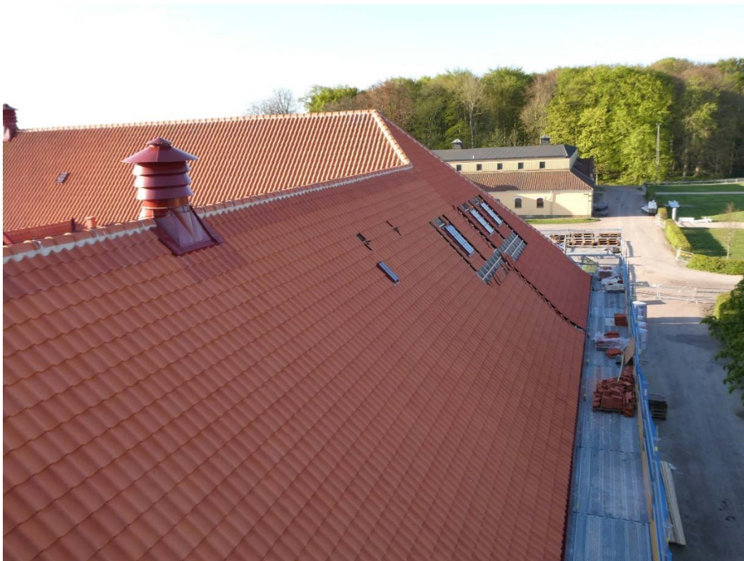
Muradenockar, ny ventilationshuv, återmonterade takfönster och järnöglor.
