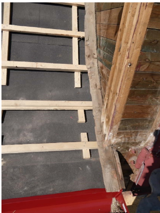
Under arbete. Vänster: Virket i gott skick på kupan. Höger: Anslutning mot trappgaveln på västra takfallet.
