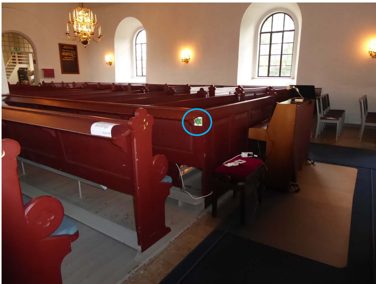
Under åtgärder: äldre givare på bänkradens rygg i södra korsarmen under nedmontering.
