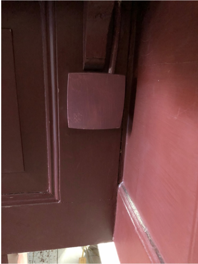
Efter åtgärder, målad ny givare och kabel.
