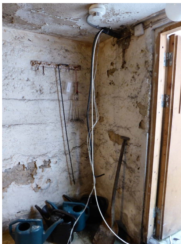
Under åtgärd. Elskåp i förråd. Från elskåpet drogs kabel i rör ner till källaren.
