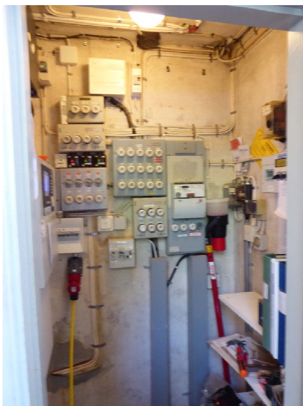
Under åtgärd. Elskåp i förråd. Från elskåpet drogs kabel i rör ner till källaren.
