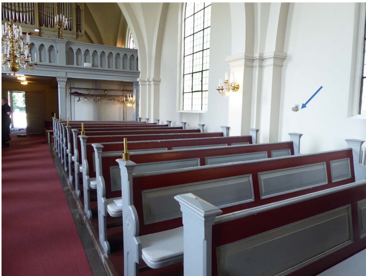
Under åtgärder. Äldre termostater på väggen nedmonterad
