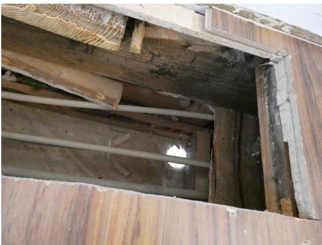
Dokumentation under arbetet. Exempel på håltagningar i golv med fyllning och brädgolv under nuvarande golvsikt.
