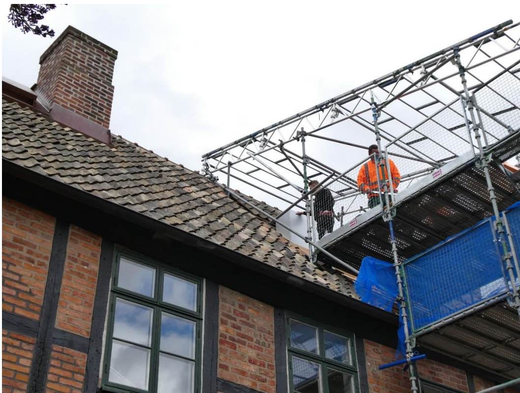
Under arbete. Takhuven monteras.
