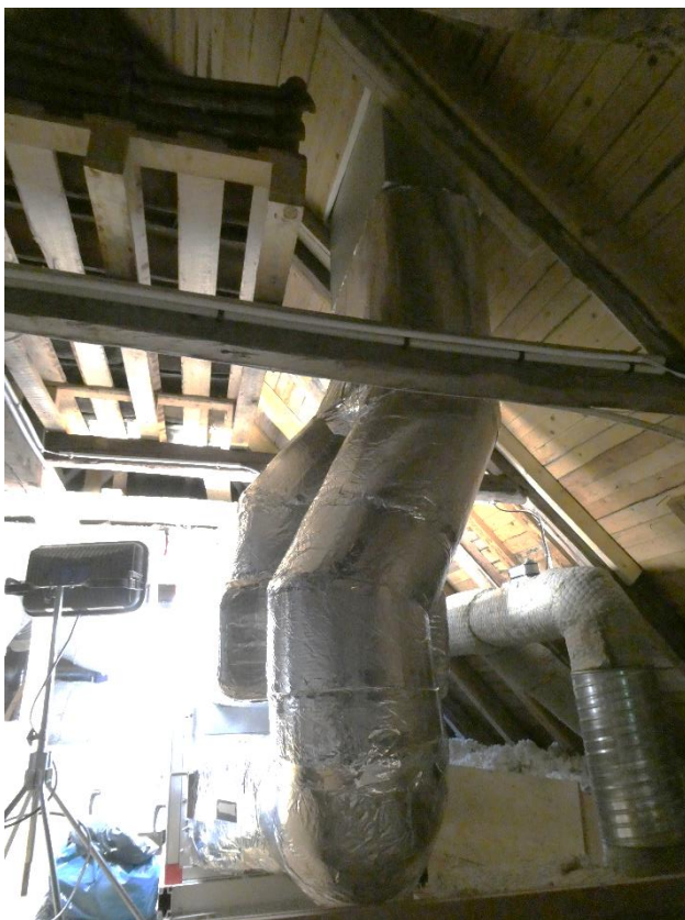
Efter åtgärder. Nytt aggregat på vinden installerat mellan takstolar.
