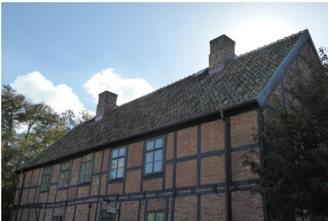
Före åtgärder. Det norra aktuella takfallet.
