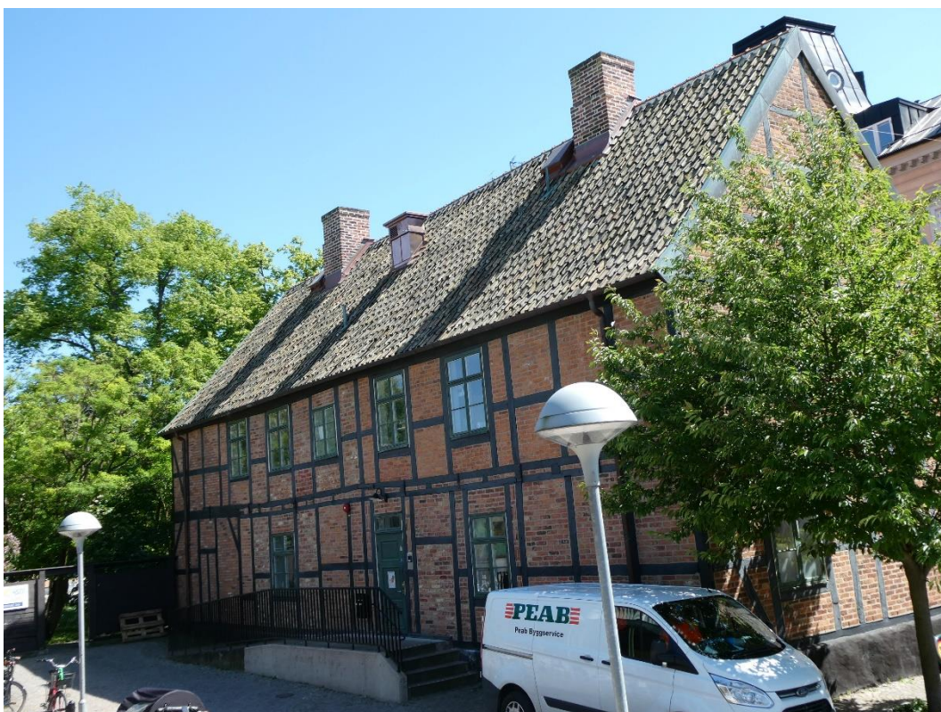
Efter åtgärder, norra takfallet med ny huv mellan skorstenarna.
