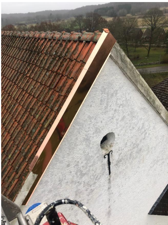
Under arbete med montering av kopparplåt på vindskivorna.
