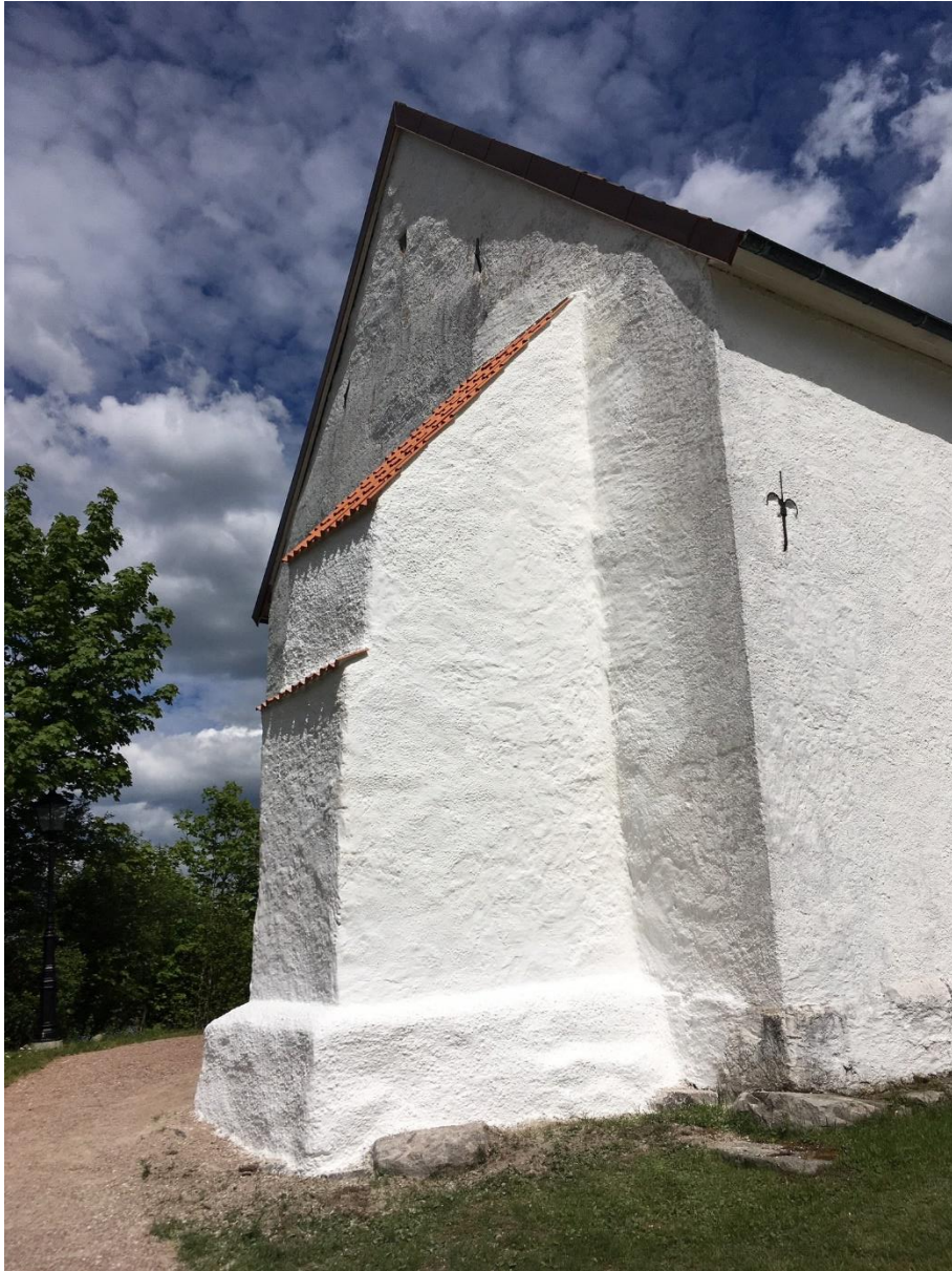
Efter åtgärder. Strävpelare och kopparklädda vindskivor.
