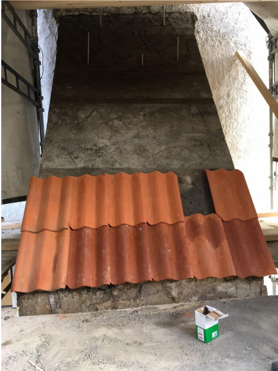
Takpannorna läggs. Dubbelvingade pannor ger likadant avslut på båda ytterkanterna (till höger och till vänster).
