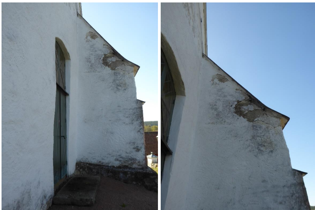
Före åtgärder. Strävpelarens norra sida.
