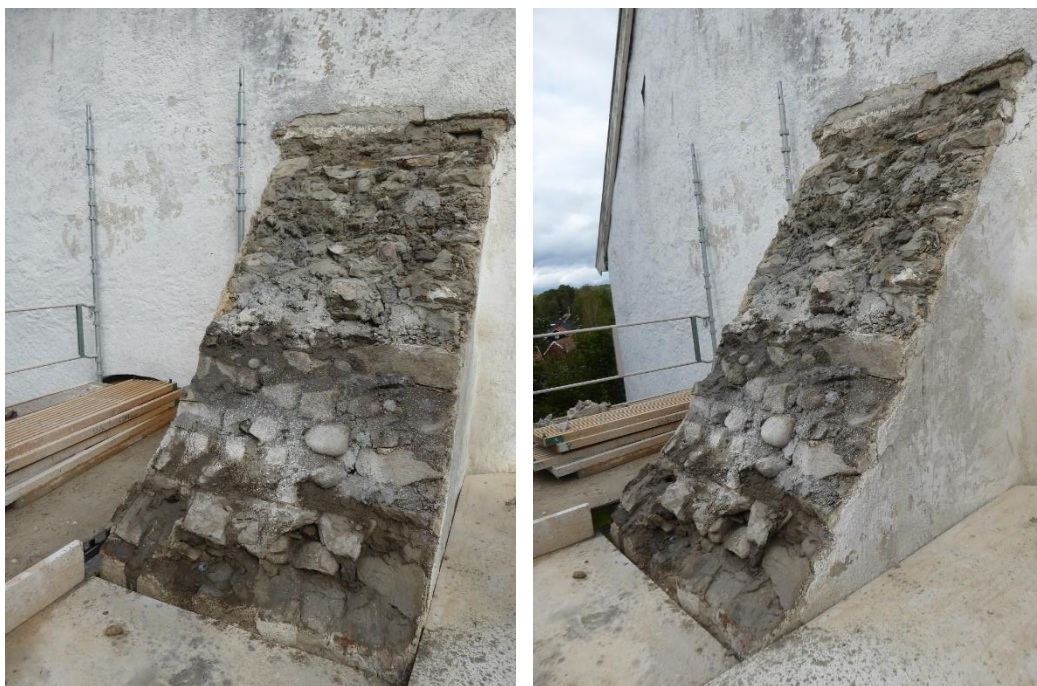
Under arbete. Betongplattan har tagits bort och befintliga stenar säkras.
