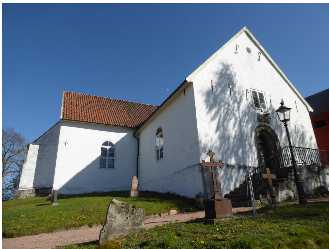
Före åtgärder. Kyrkan sedd från söder.
