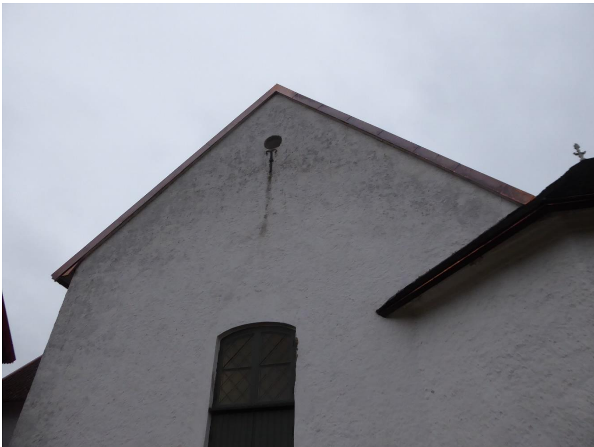
Under arbete med montering av kopparplåt på vindskivorna.
