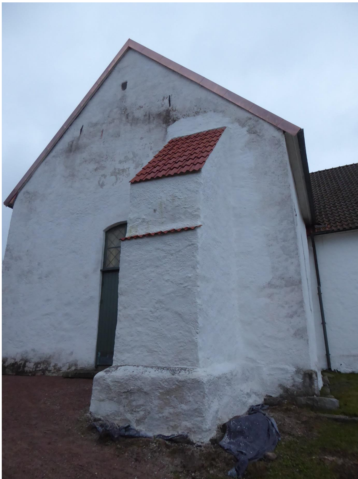
Efter åtgärder där kopparplåt är monterad på vindskivor, västra gaveln. Strävpelaren är under arbete.
