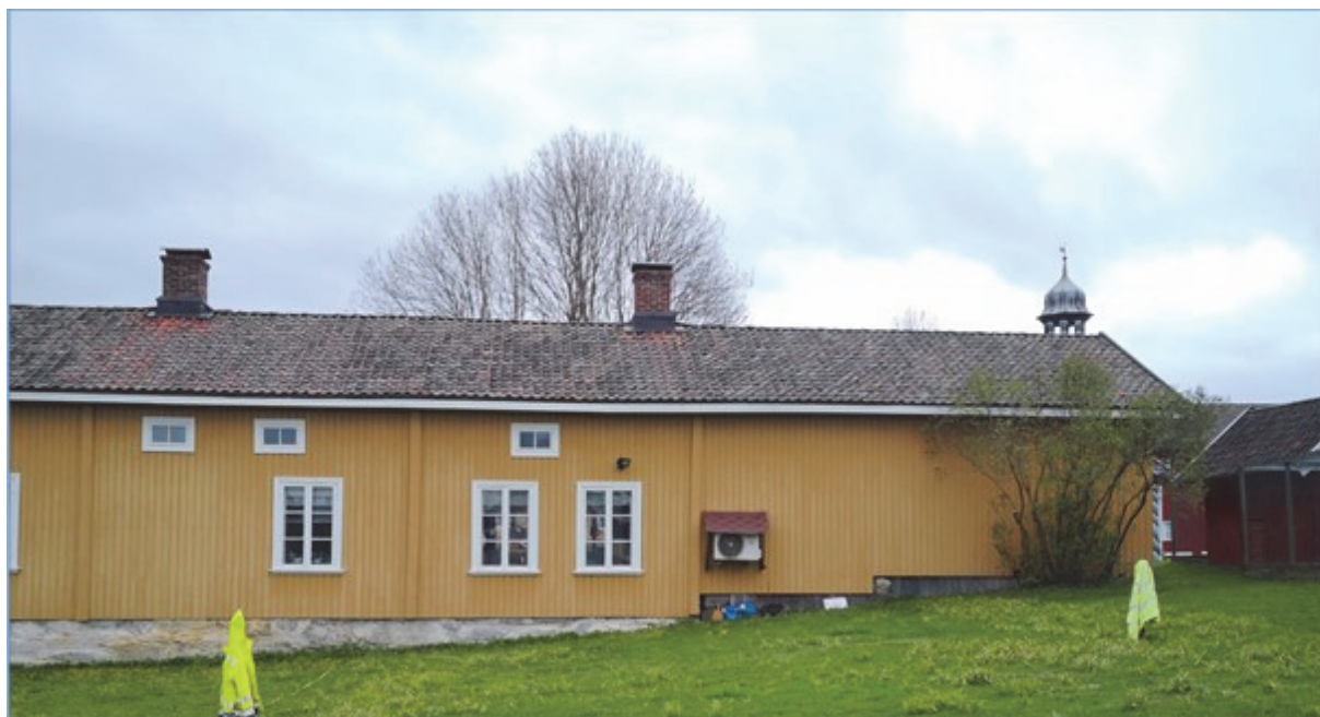
Figur 10. Undersökningsområdet före schaktning där man i fasaden kan se byggnadens anpassning till terrängförhöjningen. Fotografi taget ifrån söder 2024.
