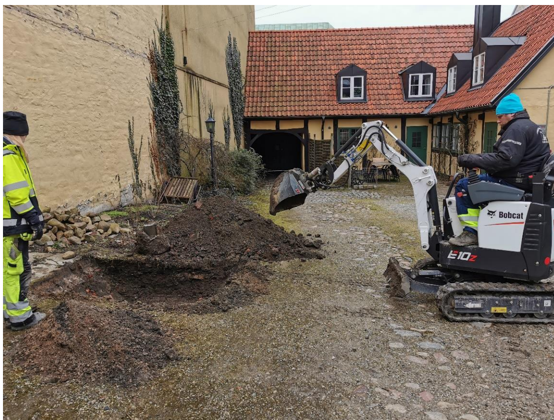
Figur 19. Schakt 3 sett från öster. Linnea Lidh övervakar schaktning.
