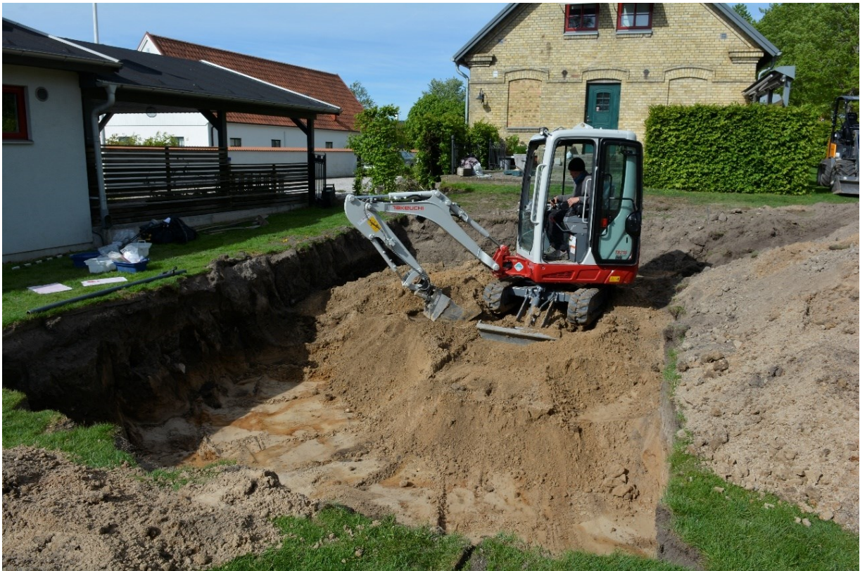
Figur 5. Översikt av undersökningsschaktet. Stora massor fick påföras i schaktet, för att maskinen skulle ha rätt räckvidd att schakta det sista i morän. Fotografiet taget från nordöst.
