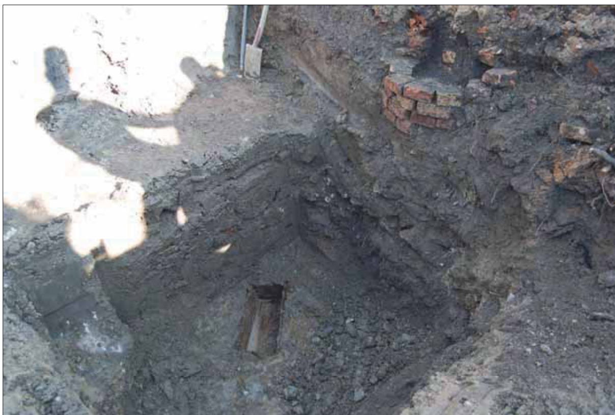
Figur 53. Brunn (K1112) med bottenkista i trä (K530) i schakt 1. Brunnens nedgrävning var rund, men delundersöktes med maskin. I schaktväggen sticker tegelkonstruktion K521 fram. Fotografiet taget från sydväst.
