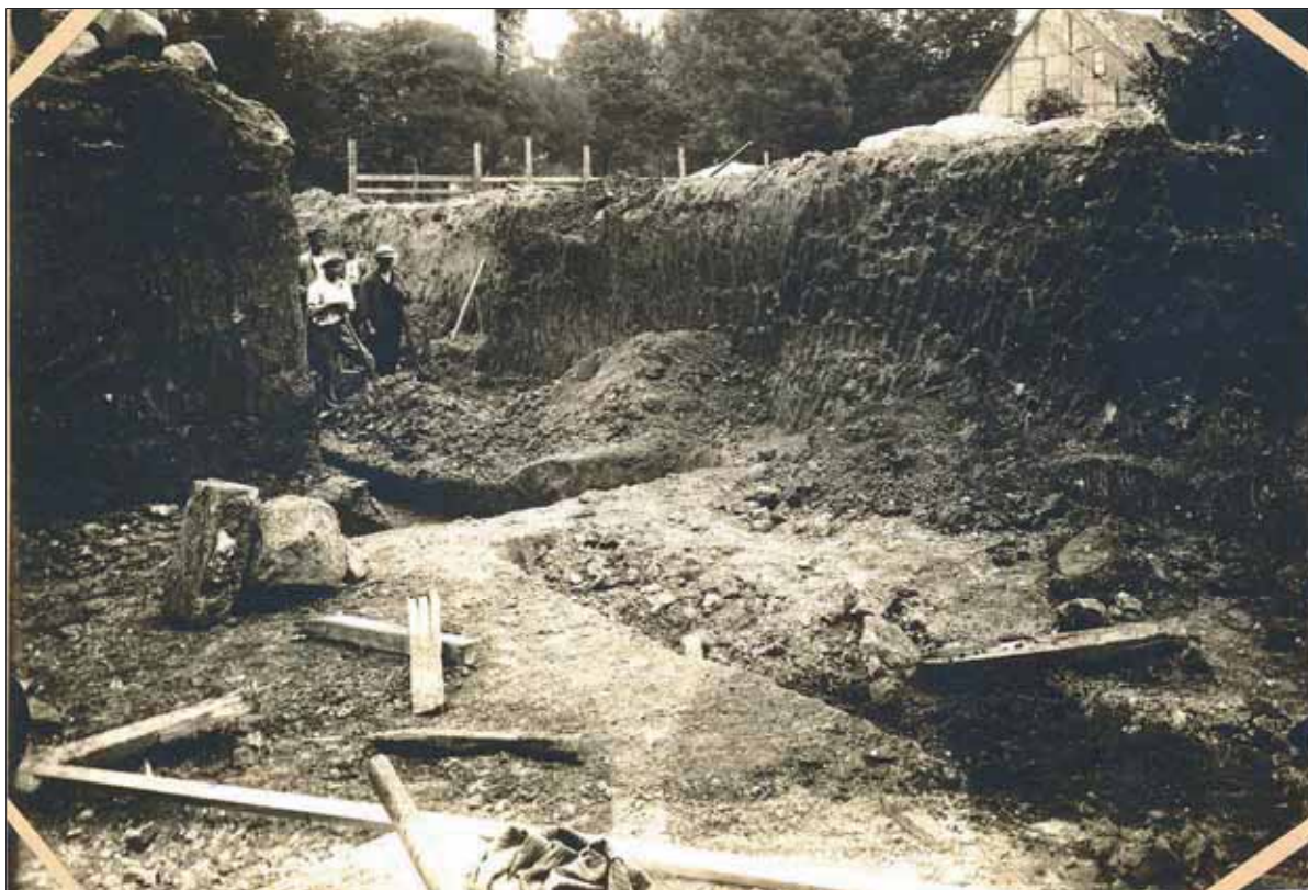
Figur 57. Fotografi från tidigt 1900-tal, då omfattande markarbeten gjordes inför uppförandet av nya lasaretsbyggnader i norra delen av kv Paradis 51. På den här tiden fanns inga grävmaskiner, utan det var handkraft och spade som användes, vilket syns tydligt på schaktväggen. Kulturens LA-arkiv.
