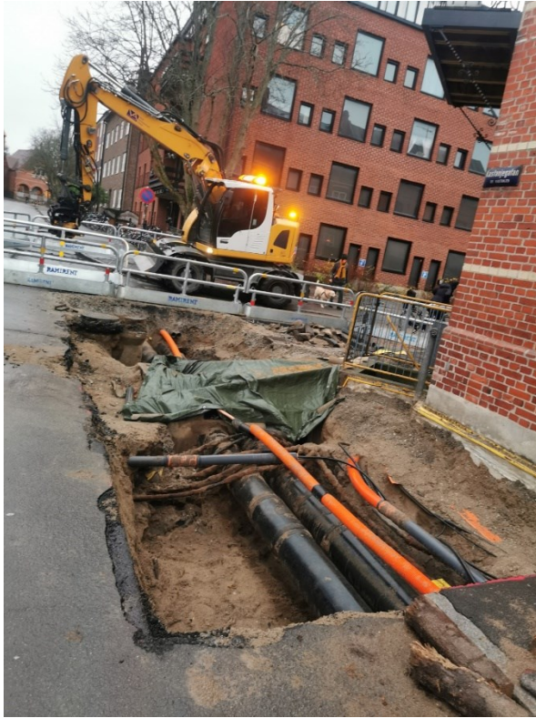
Figur 7. Schakt upptaget i Kastanjegatan, i höjd med fastigheten Kastanjen 1. Fotografiet taget från sydväst.
