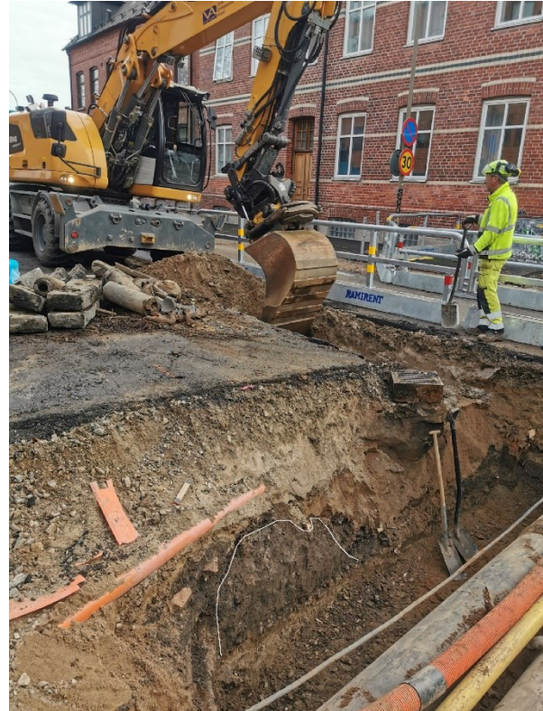
Figur 8. Schakt upptaget i Kastanjegatan, i höjd med fastigheten Gylleholm 14. Under bärlager och gul sand påträffades intakt odlingslager (vitmarkerad linje). Fotografiet taget från nordväst.
