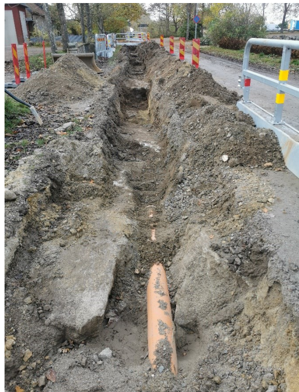
Figur 4. Den öst-västliga delen av schaktet, från öster. Notera berggrunden som utgör schaktbotten.
