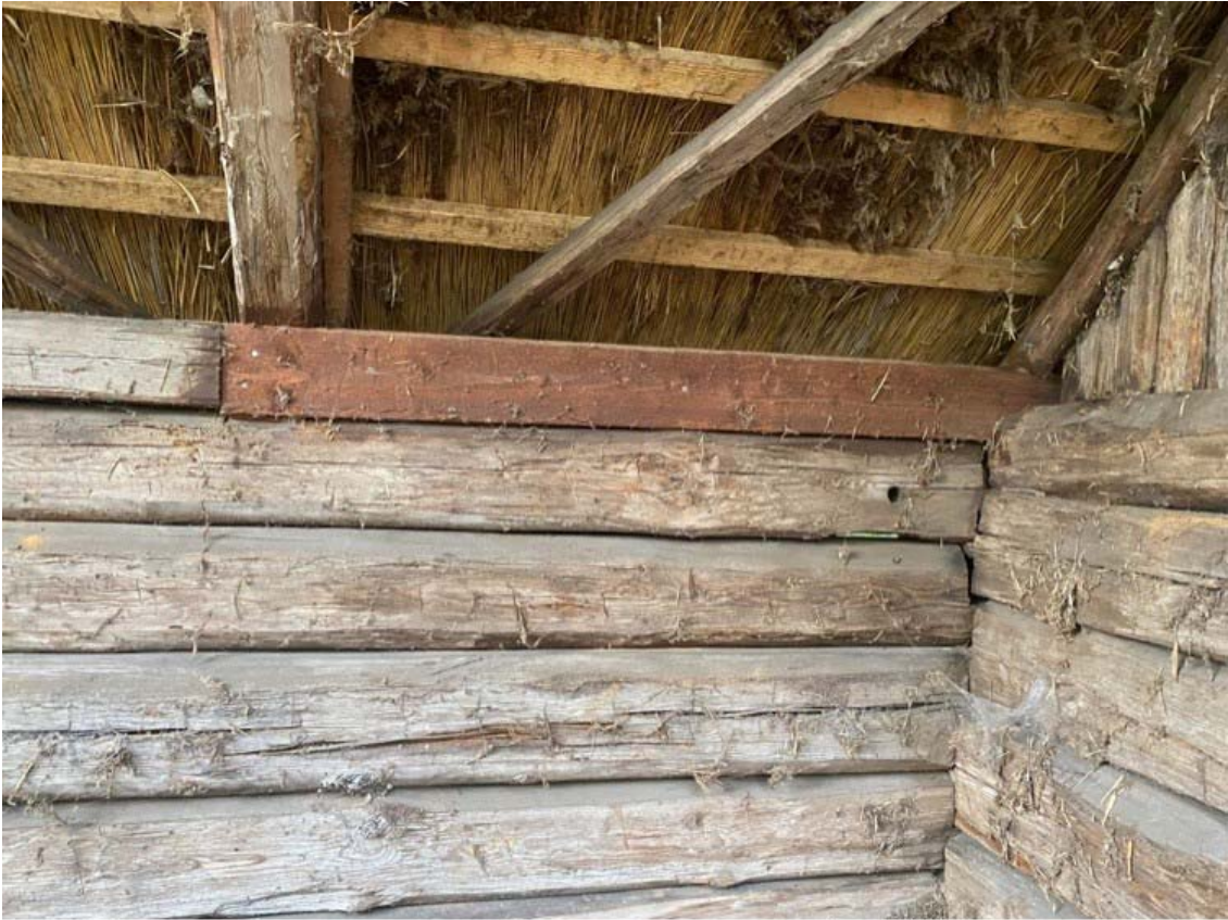
Lagning i lejden på östra fasaden.
