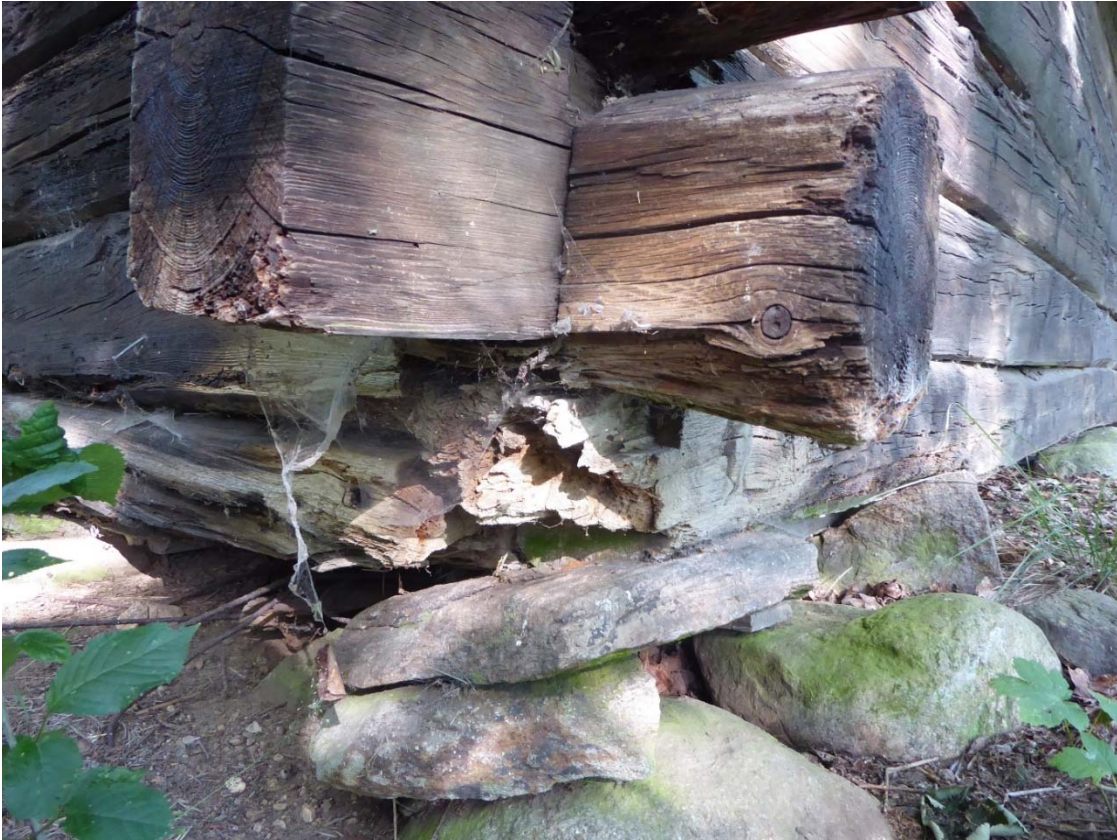
Rötskadad knut i det sydöstra hörnet.
