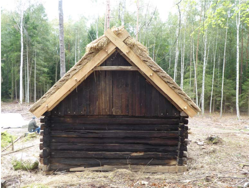
Östra fasaden med brädor i gavelröset fästa med tränaglar och spik.
