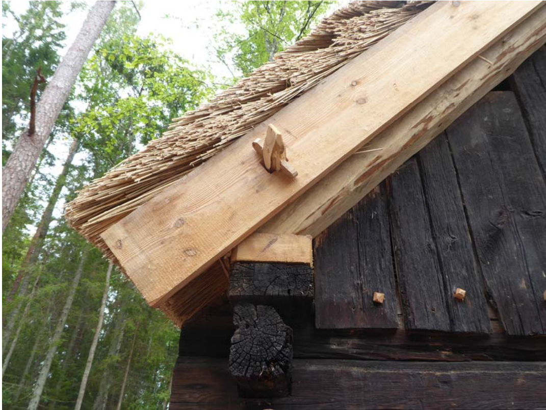
Detalj av hur lækten går igenom vindskivan och är fäst med en kil. Övre delen av lejden är skarvad.
