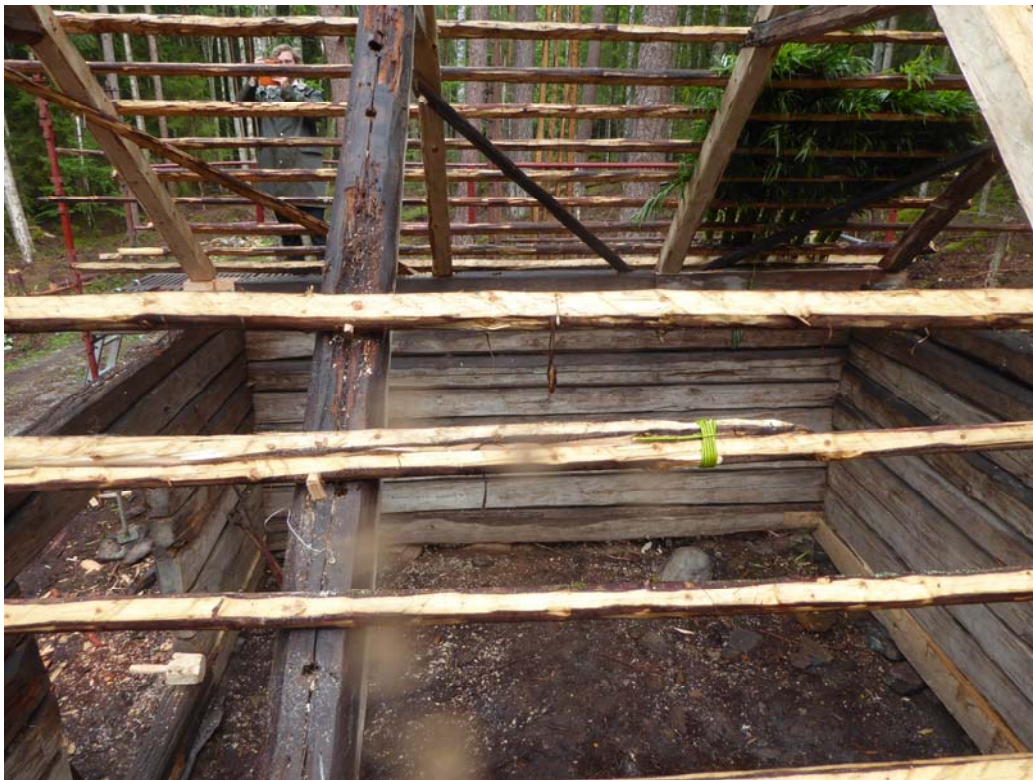
Läkten är fäst med dubb i sparrarna och sammanbunden med pilevidjor där den behövt skarvas.
