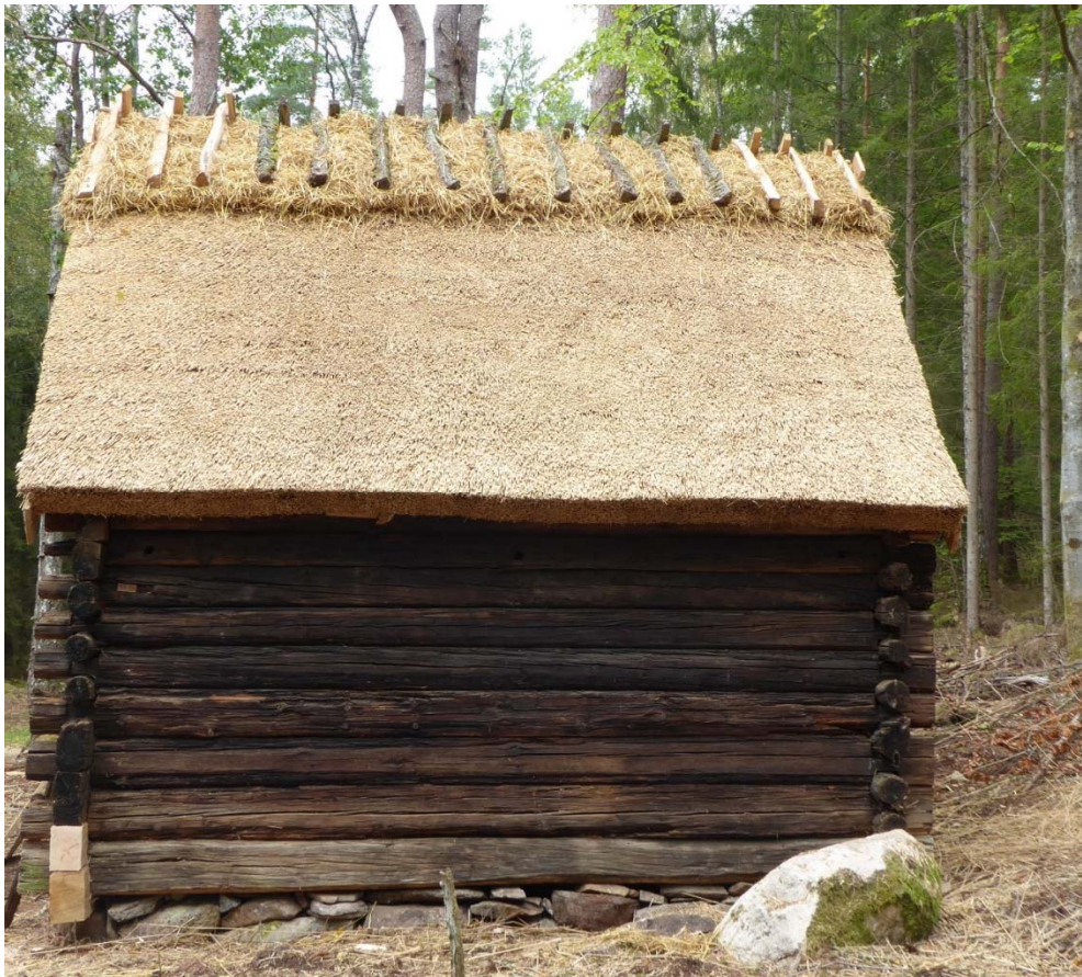
Östra fasaden med brädor i gavelröset fästa med tränaglar och spik.
