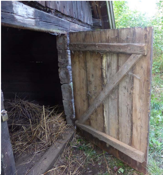
Ängsladan i Broby hembygdspark. Brädor med dubbhål i gavelröstet. Brädan till vänster om dörröppningen är en rest efter en äldre stängningsanordning. Mot väster och söder.
