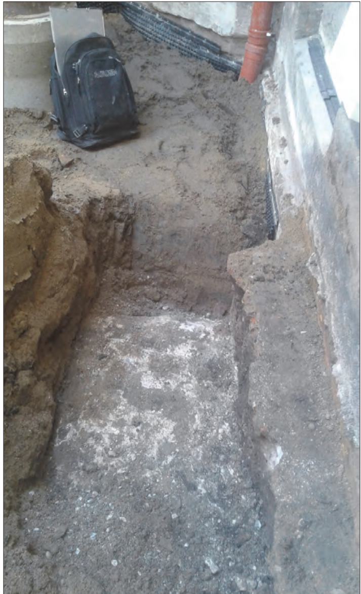
Figur 10. I norra delen av undersökningsområdet framkom en bevarad del av Sankt Mårtens kyrkomur, som uppenbarligen kvarstår under dagens uppförda fastighet.
