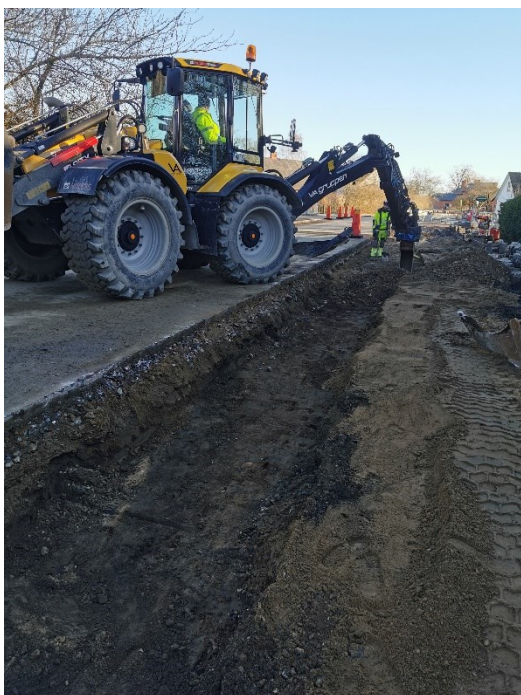
Figur 3. T.v. Schaktning för gång- och cykelväg längs med Lundavägen. Merparten av schaktningsarbetet utfördes på ett djup av 0,55 m. Fotografi taget mot öst. Figur 4. T.h. Schaktning längs den nordöstra sidan av samma väg. Här uppmättes schaktdjup på omkring 0,40 m. Fotografi taget mot väst.
