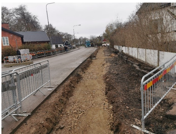
Figur 3. T.v. Schaktning för gång- och cykelväg längs med Lundavägen. Merparten av schaktningsarbetet utfördes på ett djup av 0,55 m. Fotografi taget mot öst. Figur 4. T.h. Schaktning längs den nordöstra sidan av samma väg. Här uppmättes schaktdjup på omkring 0,40 m. Fotografi taget mot väst.
