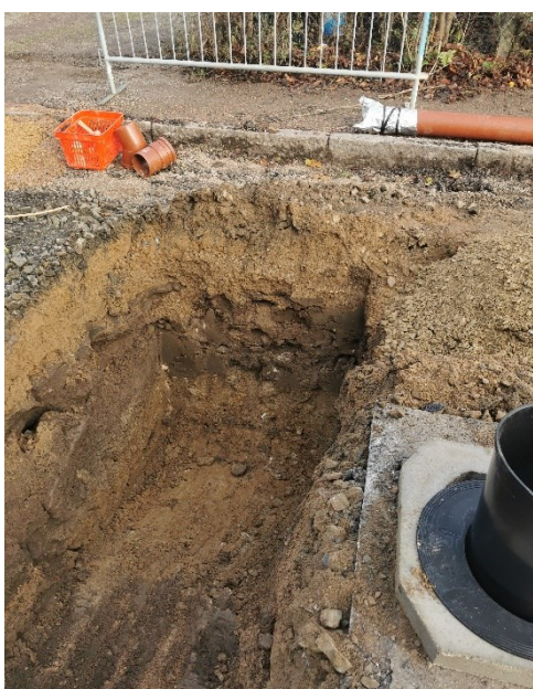
Figur 5. Djupschakt för flytt av dagvattenbrunn. Berörda lager bestod av fyllning i ledningsschakt och bärlager. Se sektion 5. Fotografi taget mot norr.
