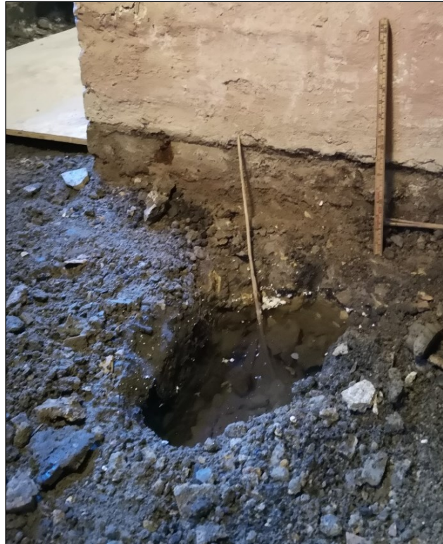
Figur 5. Provgrop inne i källaren i fastigheten belägen i norr
