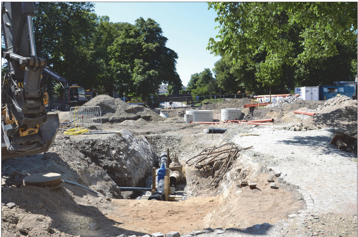
Figur 19. Markingreppet i den centrala delen av Bantorget blev omfattande och flera medeltida nedgrävningar och konstruktioner blev berörda. Vy från öster mot väster och Trollebergsviadukten. De två nya brunnarna syns centralt i bilden och placerades där en husgrund och ett dike framkom.
