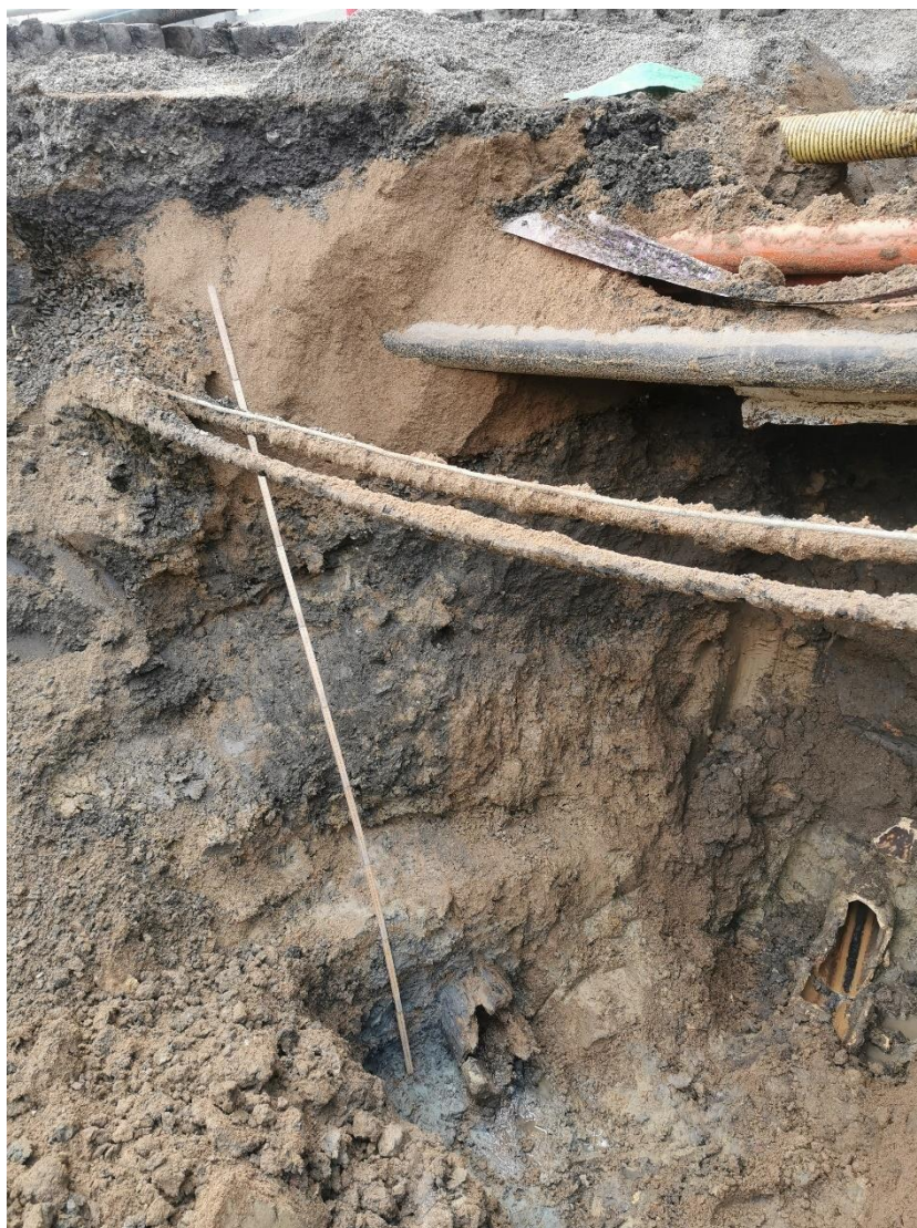
Figur 15. Vattenledningsrör i trä påträffat utanför fastigheten Gråbröder 3.
