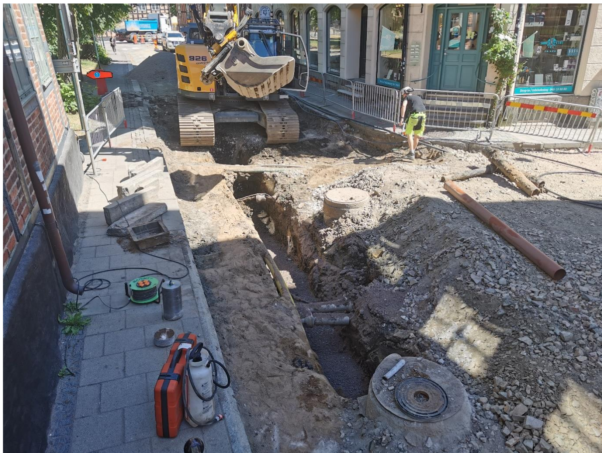
Figur 11. Schaktning utanför Ekska huset. Fotografiet taget ifrån väster.
