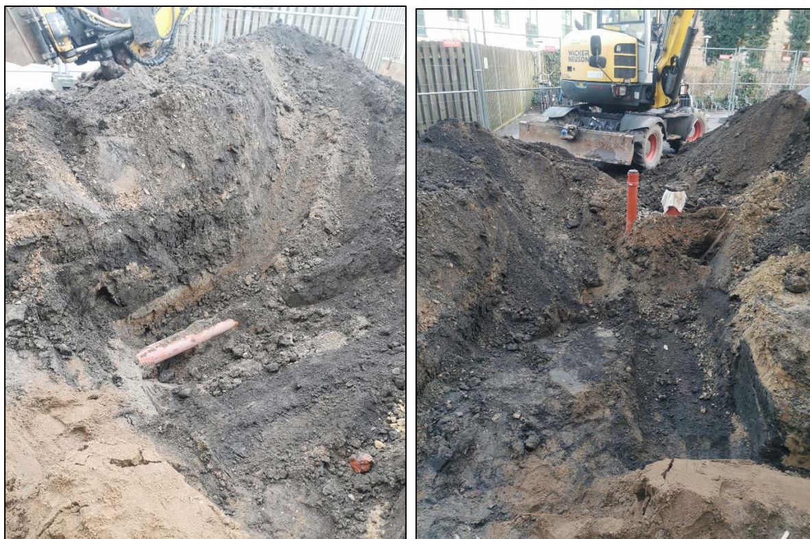
Figur 8. Schaktning för miljöhuset. Till vänster, PVC röret som anlades under 2021 års markarbete. Till höger, delar av odlingslagret framschaktat.
