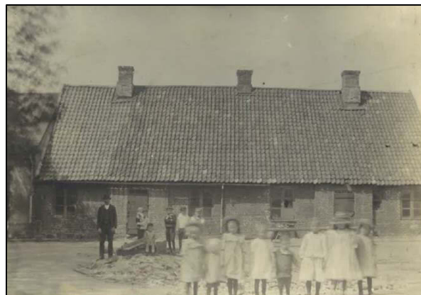
Figur 3. Lunds gamla fattigvårdsinrättning beläget på den västra delen av fastigheten. Foto taget år 1910.
