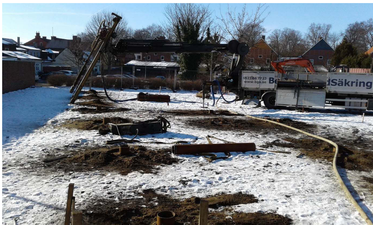
Figur 3. Översikt på undersökningsytan fotograferat från nordöst. Vid slutet av en rad borrhål med foderrör står bormaskinen.
