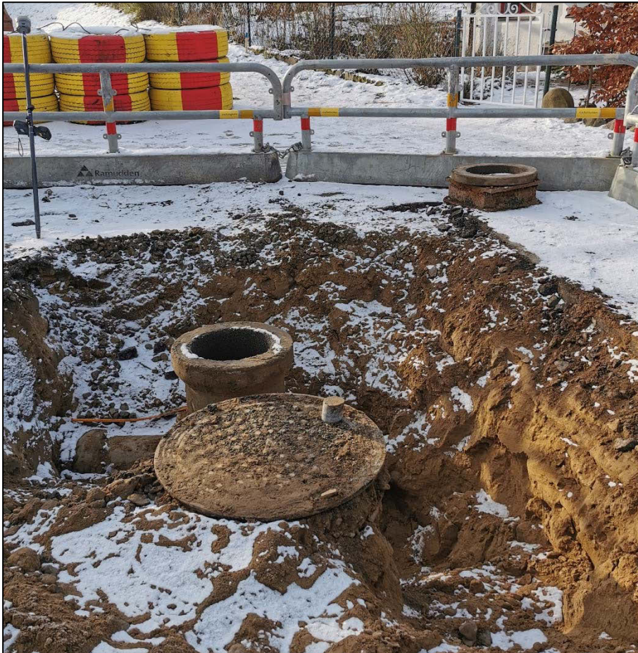
Figur 5. Schakt 1 med de två brunnarna omgivna av fyllnadsmassor av sand. Fotot taget från norr.
