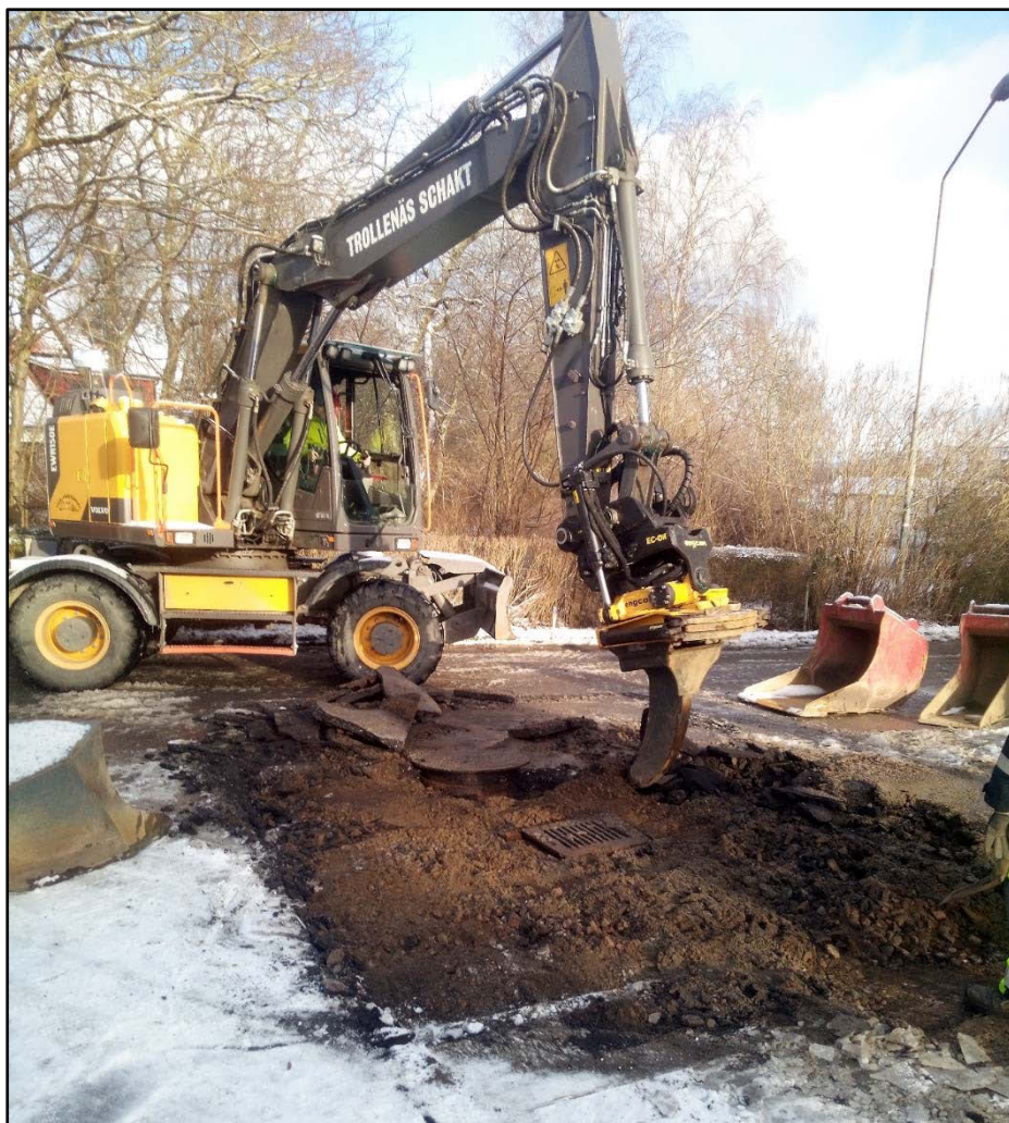
Figur 7. Borttagning av asfalt och bärlager i Byvägen. Fotot taget från söder.
