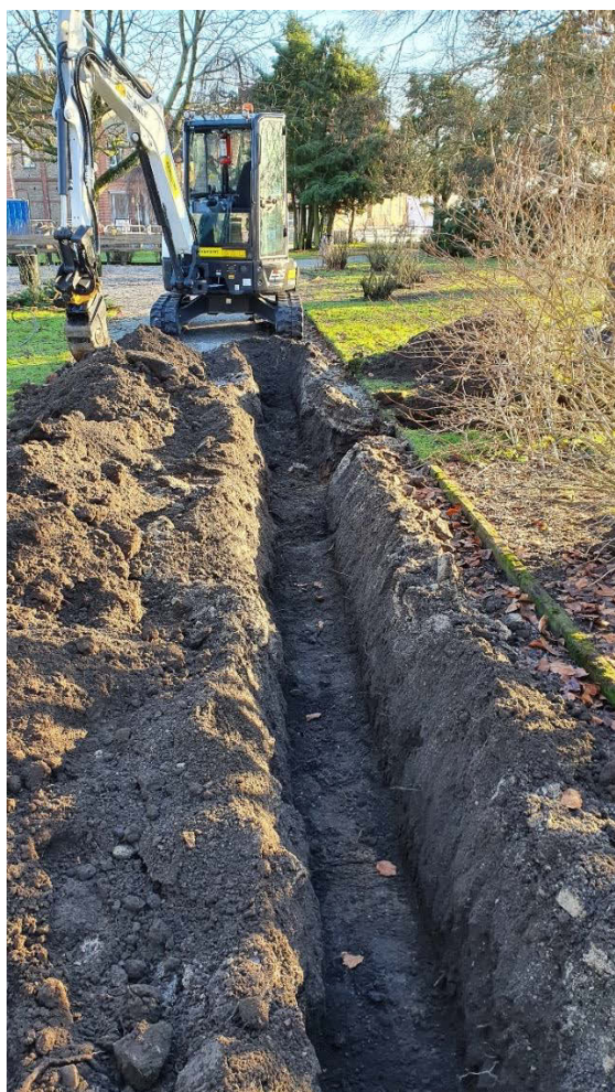
Figur 12. Schakt för belysningskabel i norra delen av parken. Fotografiet taget från norr.
