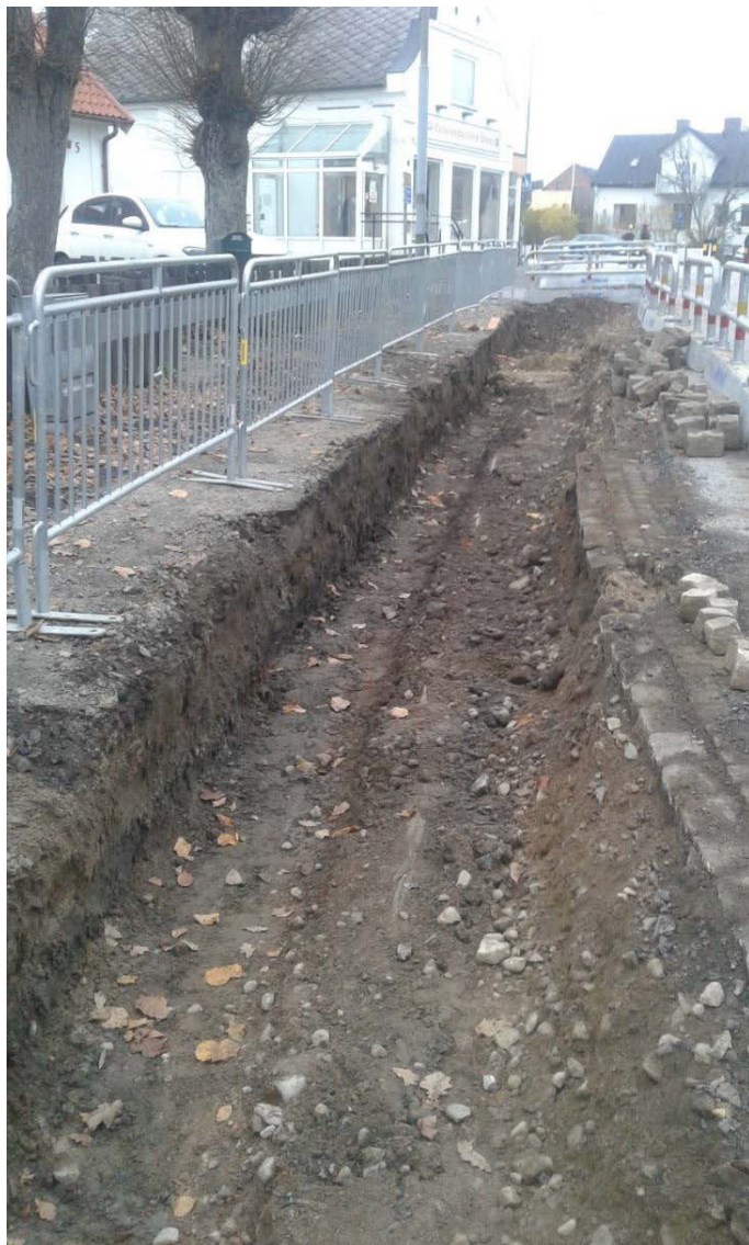
Figur 3. Schakt i trottoaren längst Lundavägens västra sida, fotografiet taget från söder.
