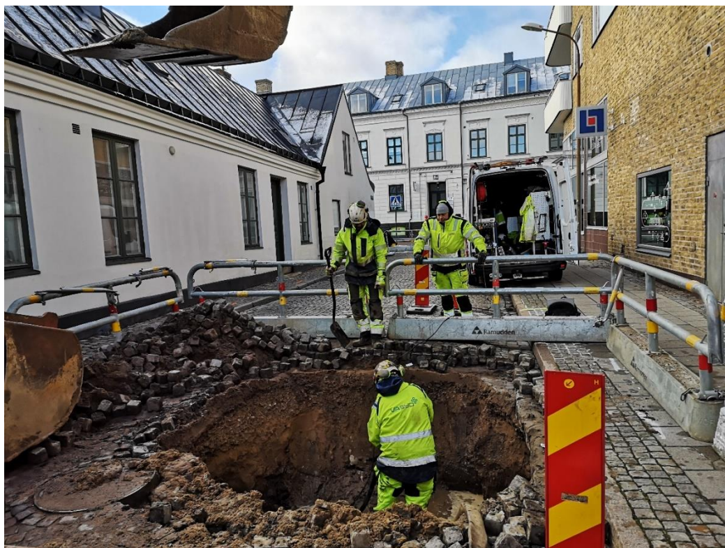
Figur 13. Schaktet på Lilla Tvärgatan där en trolig husgrund påträffades längst till vänster i schaktet. Fotografiet taget från öster.
