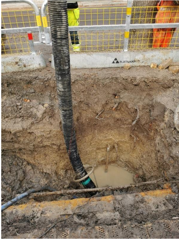
Figur 16. Översiktsfoto av schaktet vid Södra Esplanaden 24. Fotografiet taget från söder.
