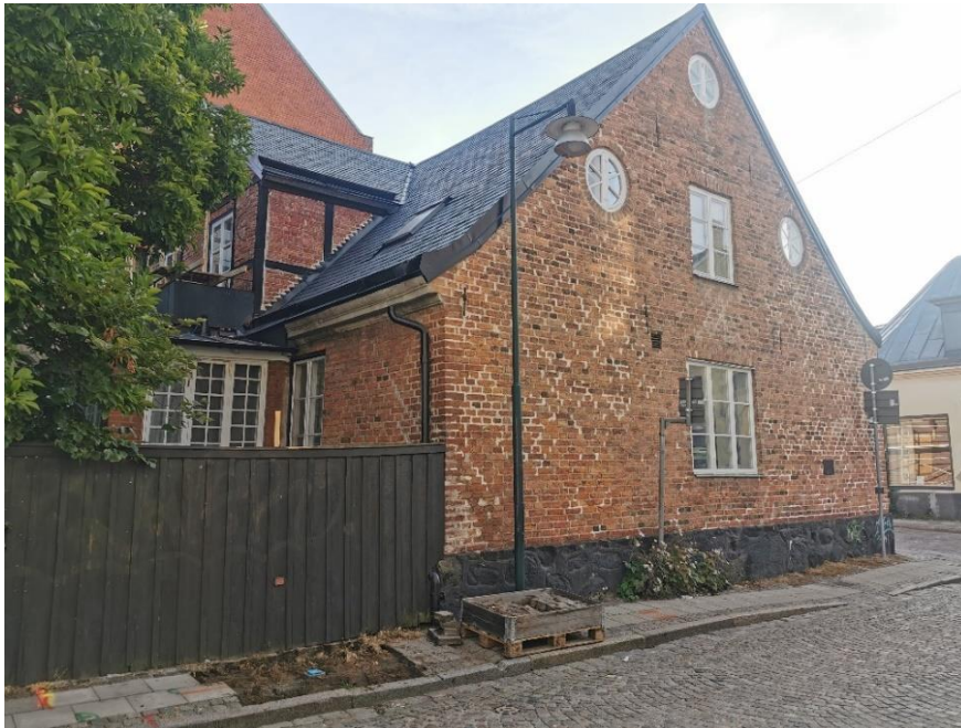
Figur 17. Översiktsbild innan schaktning i gatan, kv Myntet i bakgrunden. Fotografiet taget från sydväst.
