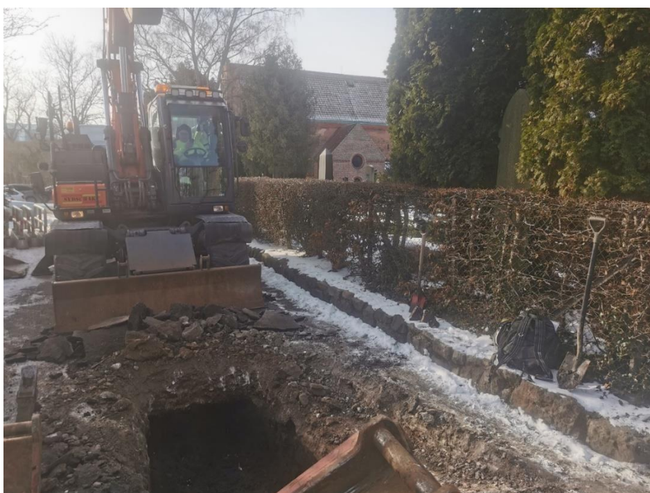
Figur 21. Schaktets placering nordöst om Klosterkyrkan. Foto taget från nordöst.
