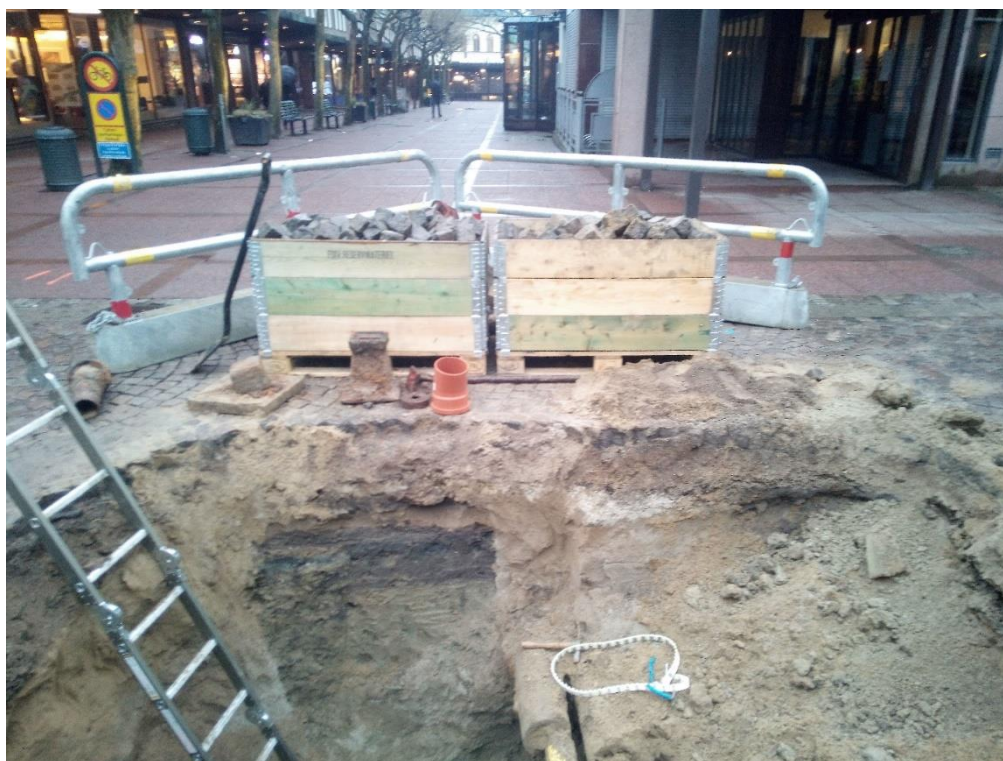
Figur 3. Översiktsfoto av schaktets västra del. Utjämningslager och nedgrävning är synliga i sydvästra schaktkanten. Fotografiet taget från öster.
