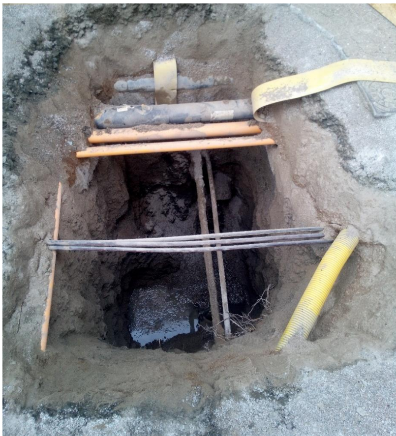
Figur 7. Schakt upptaget i Mårtenstorget norra del. Fotografiet taget från norr.
