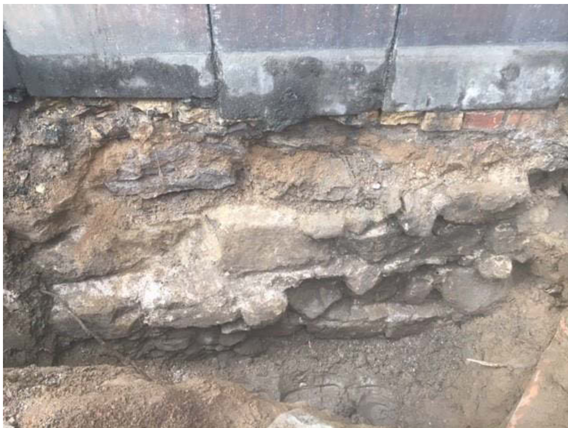
Figur 6. Västra sektionen med domkyrkans grundmur synlig, fotografi taget från öst.
