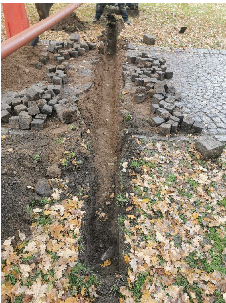
Figur 8: Översiktsfoto av schakt 2, foto sedd från öster.
