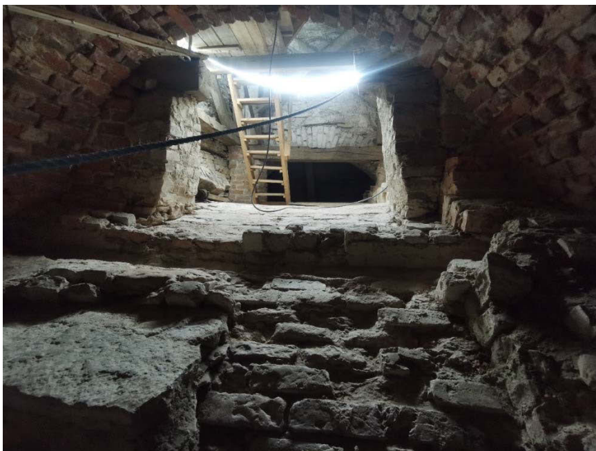
Figur 6. I kyrkans västra ände dokumenterades ett tunnvalv som tillhör kyrkans tidigare fasad. Direkt på tunnvalvet har därefter kyrktornet byggts. Trappan på bild leder upp till klocktornet.
