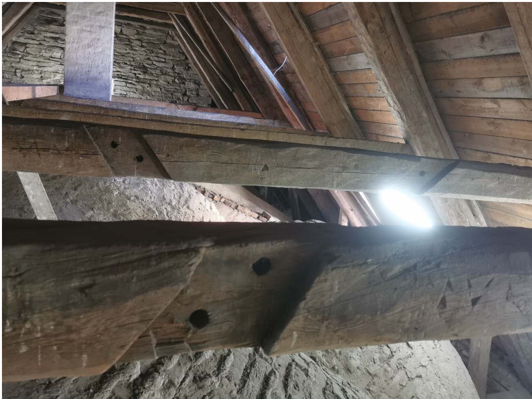
Figur 8. På vinden påträffades spår av återanvänt timmer så som dessa hanaband. I hanabanden finns tydliga fogar uthuggna för stödben. På det bakre hanabandet sitter vinklarna för stödbenen fel, vilket tyder på att bjälken som utgör hanabandet återanvänts och monterats upp och ner. På hanabanden finns markeringar i form av små trianglar som visat hantverkarna vilka bjälkar som hör ihop.
