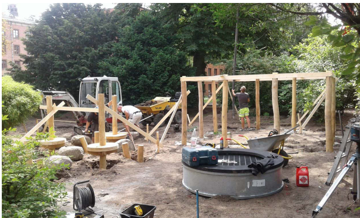
Figur 7. Översikt av pågående arbete med klätterställningen, foto sedd från norr.
