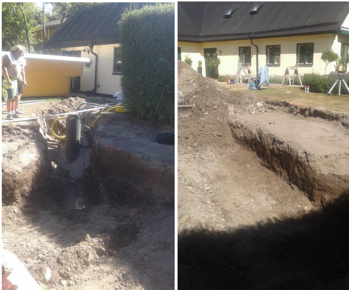
Figur 3. Väster, poolschakt och brunn från norr. Höger, Poolschakt från söder.
