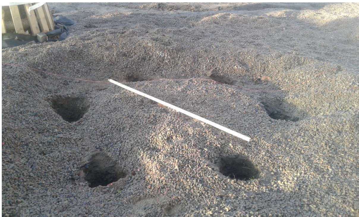
Figur 15. Hål för fundament till lekpaviljong, sett från norr.
