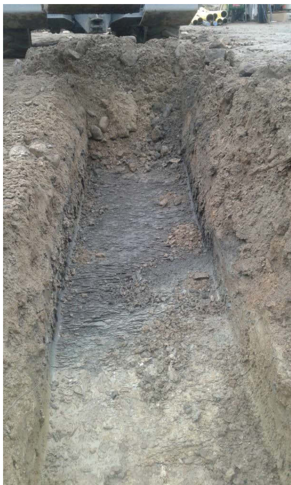
Figur 10. Vallgraven schaktas fram, där gravens södra kant tydligt syns mot den gula moränleran. Sett från söder.
