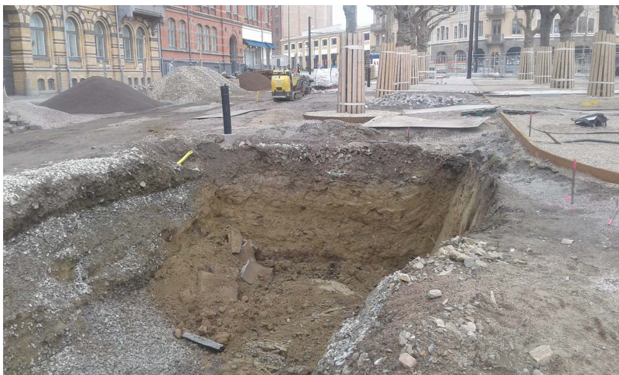
Figur 14. Schaktet för sopbehållarna. Sett från väster.
