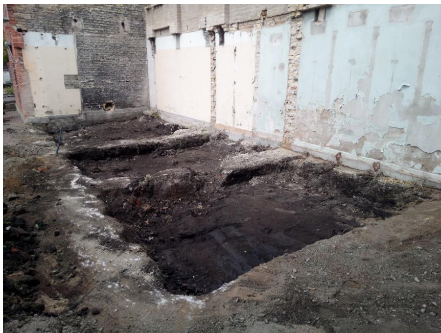
Figur 22. Rivningen av byggnaden i norr (schakt 200) kom endast att beröra moderna raseringsmaterial och toppen av äldre mark-/odlingslager. Foto från sydväst.
