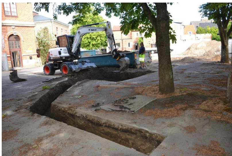
Figur 17. Schaktning pågår för elanslutning och grundläggning av paviljongen. Foto från sydost.
