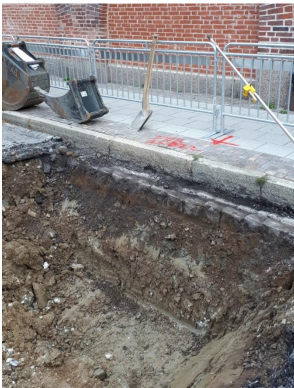
Figur 6. Fotografi taget från sydöst vid schaktning för brunn.
