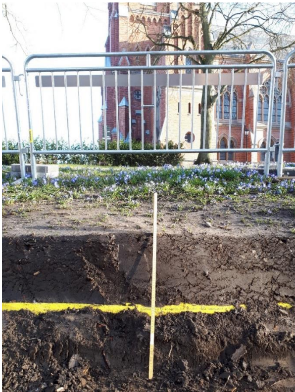
Figur 8. Fotografi taget från söder av partiet som schaktades upp mot Allhelgonakyrkan.
