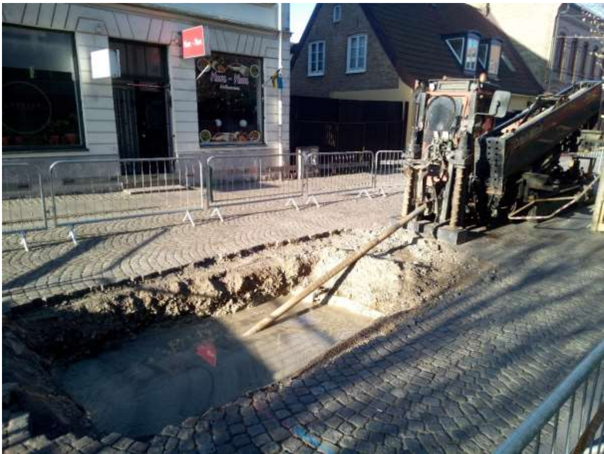
Figur 14. Schakt 7, schakt fyllt med vatten. Fotografiet taget från nordöst.
