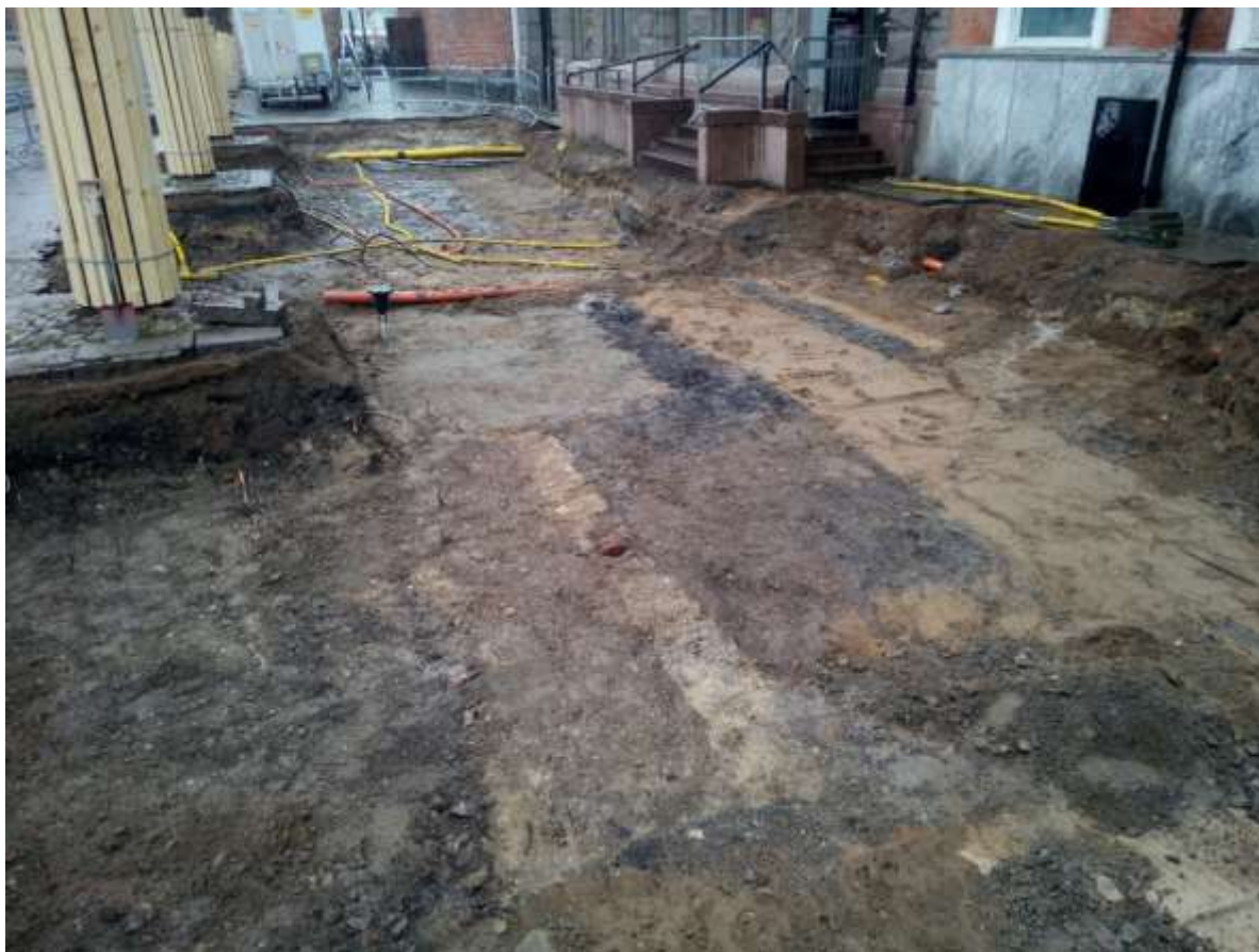
Figur 6. Översikt visande schaktbotten i schakt 1. Här syns flertalet sentida nedgrävningar i form av ledningsdragningar. Det mörka stråket mitt i bilden kunde konstateras vara återfyllda massor från kulvertgrävningen år 1959. Fotografiet taget från öster.
