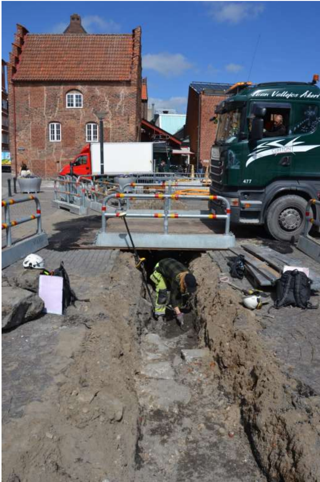
Figur 13. Grundmuren (6:4) undersöks, söder om Krognoshuset. Foto från söder.
