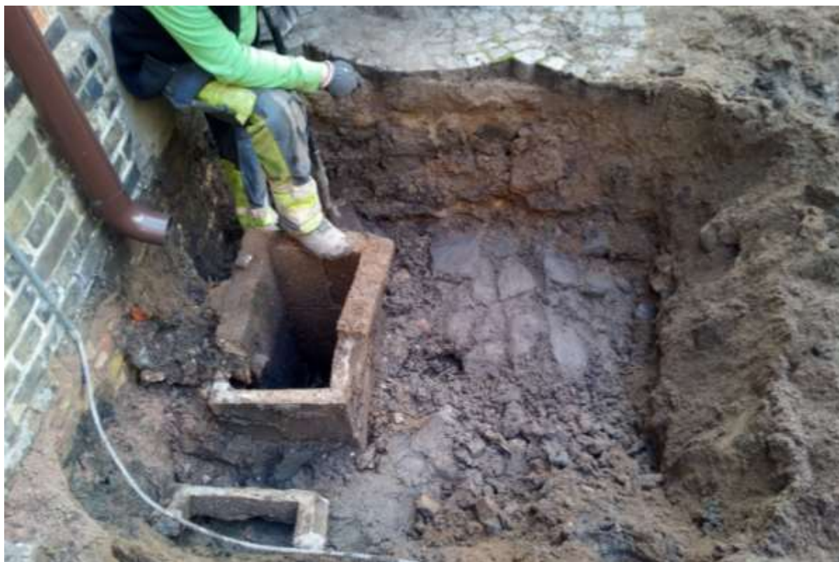
Figur 5. Schakt 2, med den äldre av de två stenläggningarna framrensad. Foto från söder.
