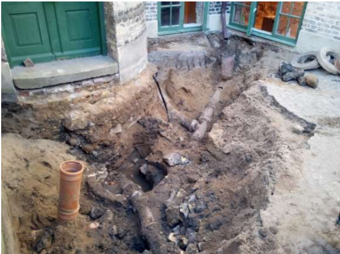
Figur 4. Schakt 1, sett från öster.
