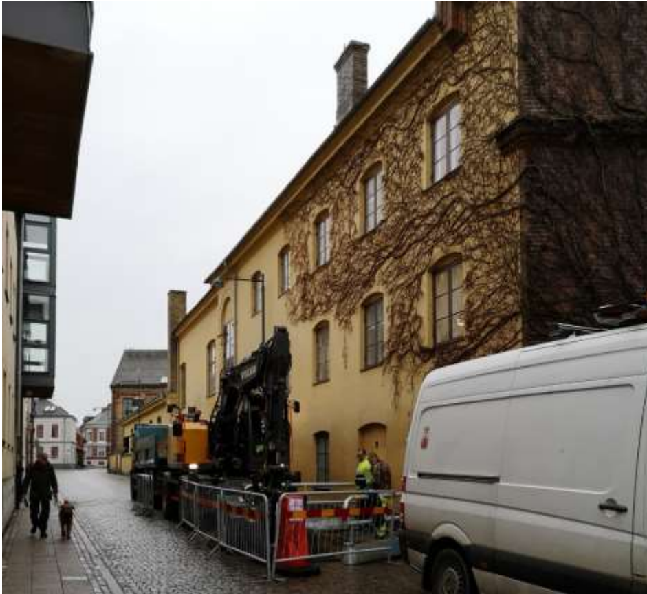
Figur 2. Område för sättningskada i Paradisgatan. Fotografiet taget från väster.
