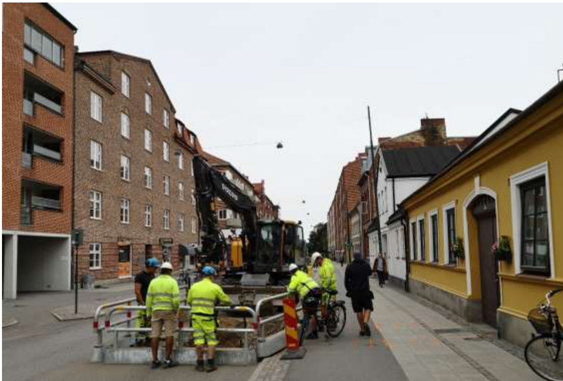
Figur 3. Platsen för sättningskadorna i höjd med Stora Södergatan 57 och 46. Fotografiet taget från norr.
