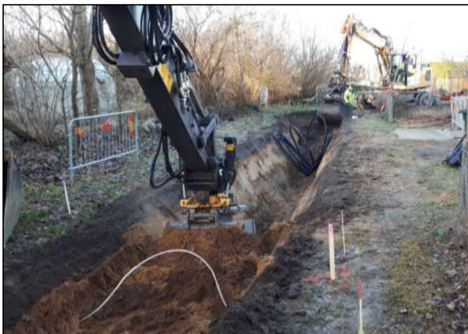
Figur 3. Schakt 9, Norra Vombsvägen. Exempel på schaktningsförfarandet. Två maskiner arbetar samtidigt med anläggandet. Maskinen närmast i bild schaktar för nerläggande av vatten- och avloppsledningarna medan maskinen i borte delen av bilden breddar schaktet och anlägger ny väg. I förgrunden sticker en vit elledning upp.
