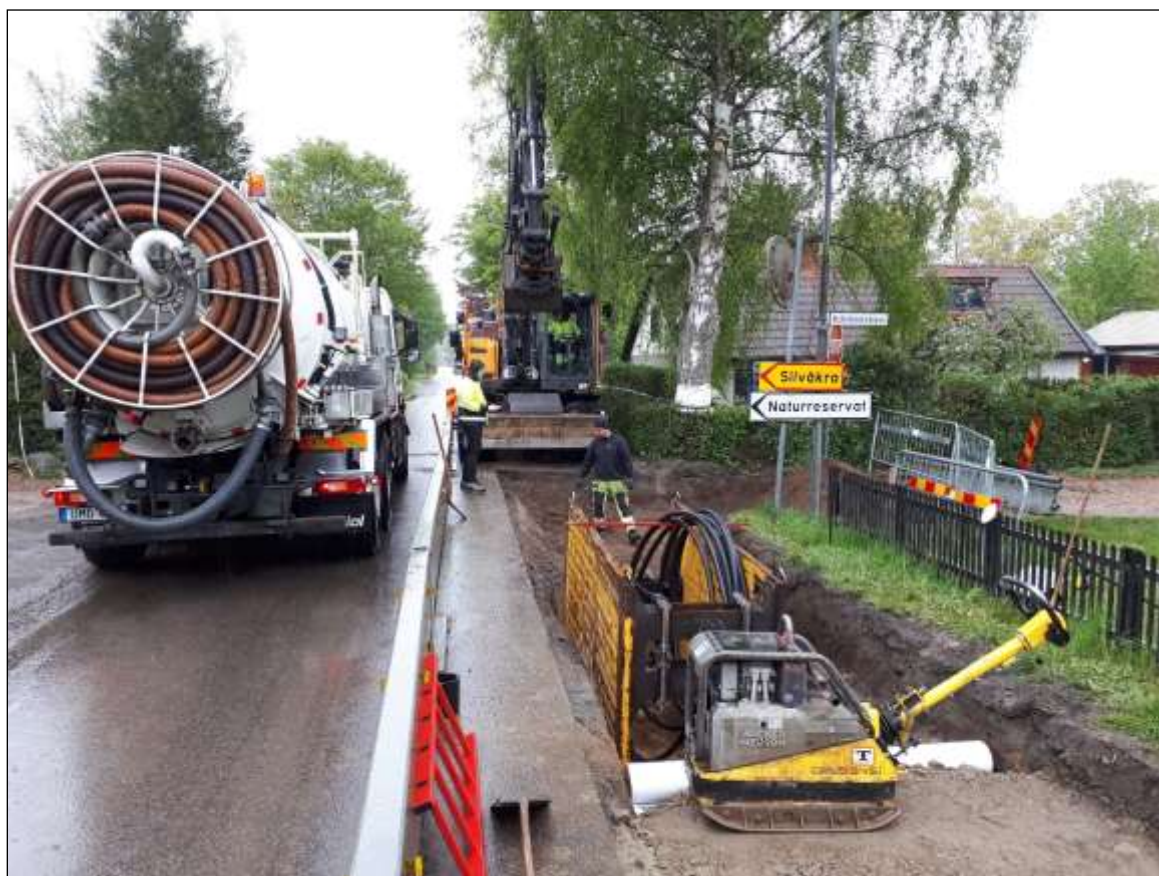
Figur. 131. Arbetsbild, schakt 49. Järnspons placerat mitt i schaktet, som flyttades under arbetets gång. Foto mot norr.
