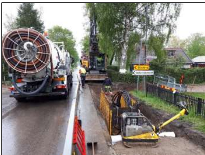
Figur 6 a och b. Schakt 49, Södergårdsvägen, arbetsfotografi taget från söder respektive norr. I schaktet syns den flyttbara spont som fungerar som extra säkerhet vid arbete nere i schaktet.
