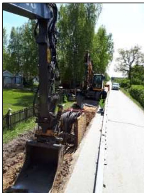
Figur 6 a och b. Schakt 49, Södergårdsvägen, arbetsfotografi taget från söder respektive norr. I schaktet syns den flyttbara spont som fungerar som extra säkerhet vid arbete nere i schaktet.
