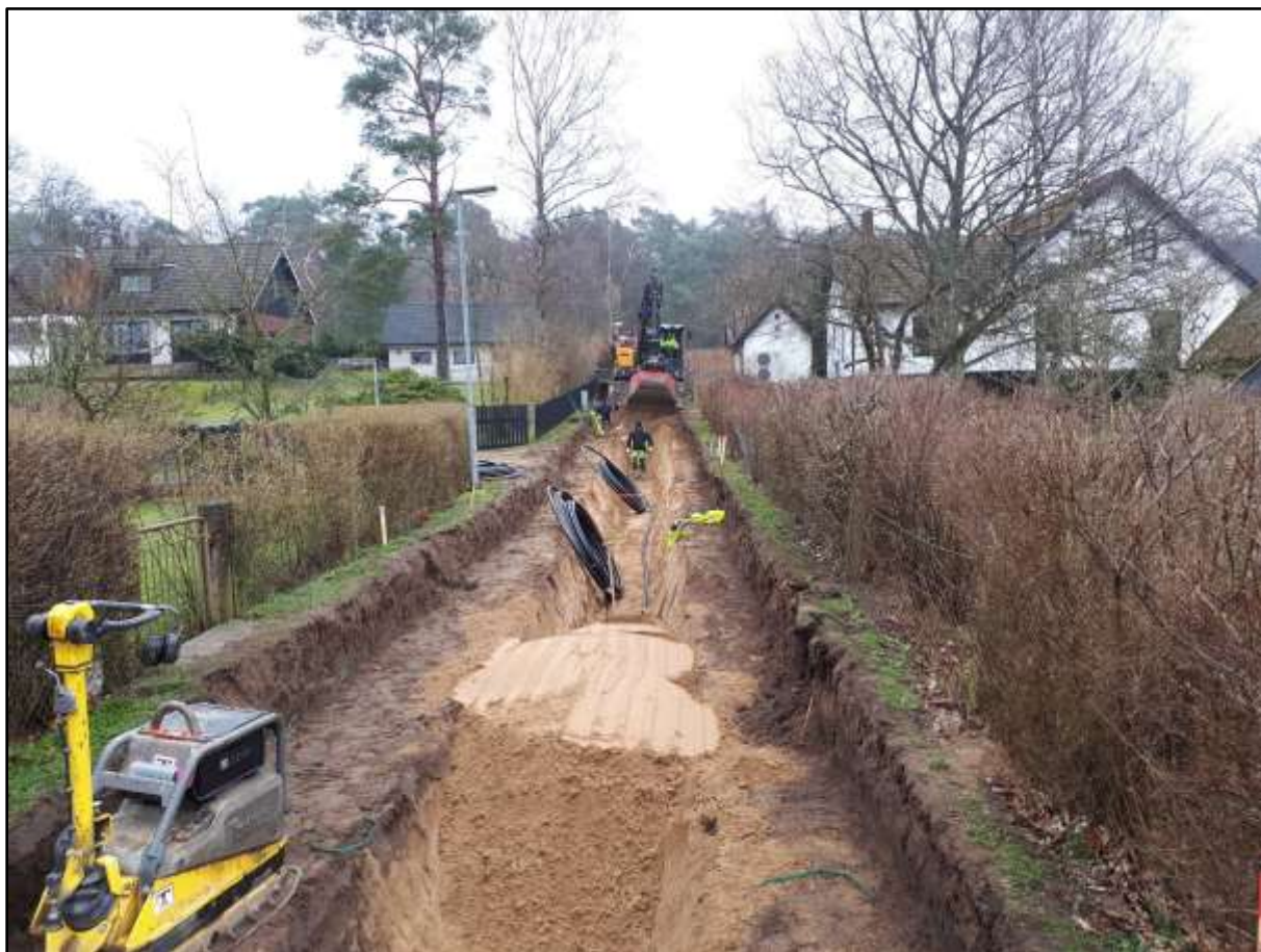
Figur 68. Schakt 37–38, Gamla skolvägen, översikts/arbetsfoto taget från väster. Ett kraftigt bärlager i vägen kombinerat med el- och fiberledningar på båda sidor av vägen.
