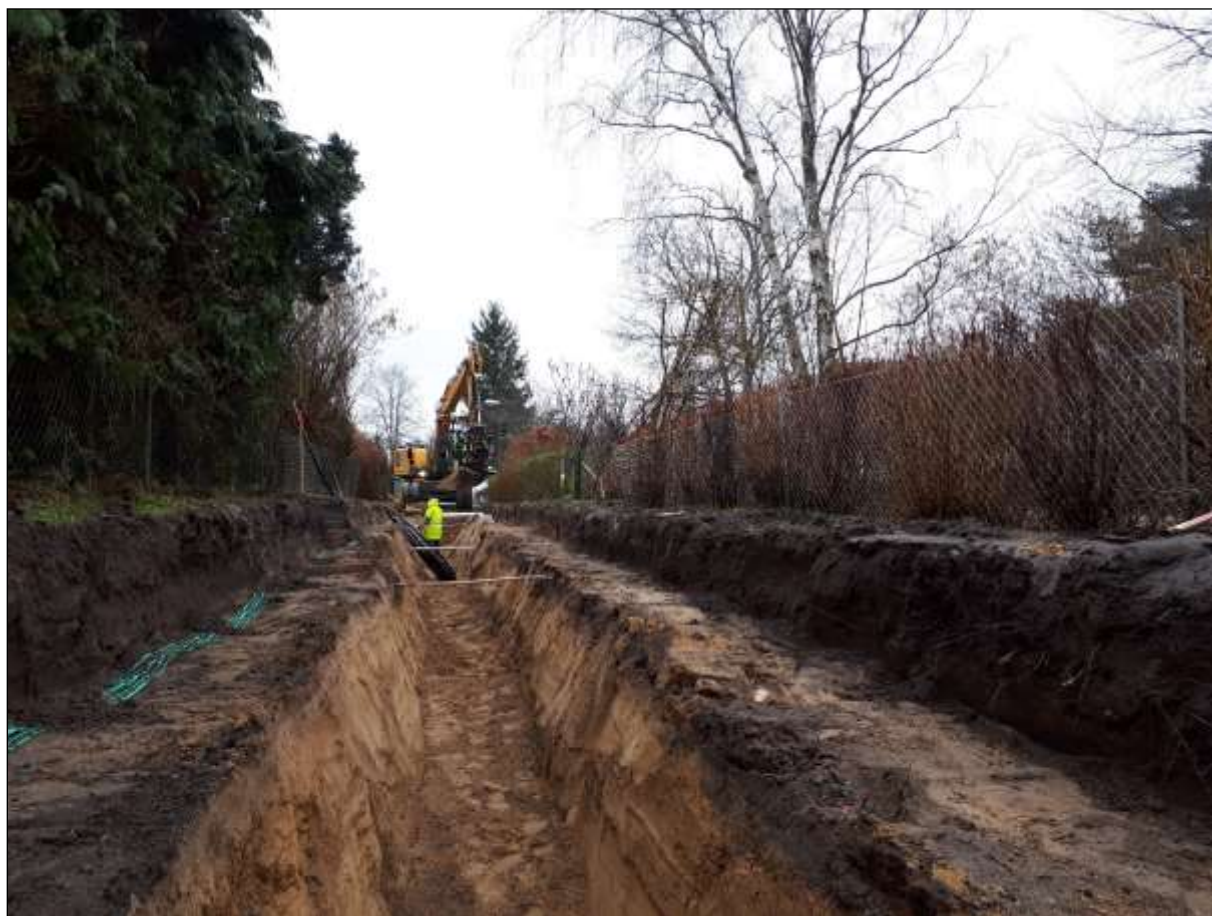
Figur 123. Översiktbild på schakt 35 och 36, Gamla byvägen. Fiberkablar och elledningar löper på ömse sidor om djupschaktet i mitten av gatan. De korsar även schaktet på ett flertal ställen. Foto taget mot norr.
