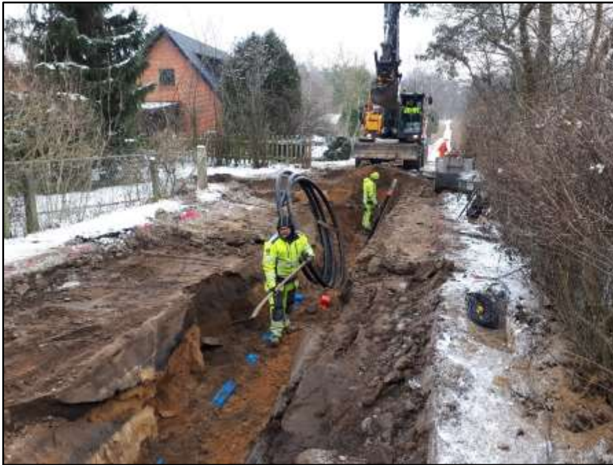
Figur 112. Schakt 25–26, Södergårdsvägen. Arbetsbild som visar det djupare schaktet i mitten där vatten- och avloppsslangarna läggs, samt breddningen för ny vägbeläggning vid sidorna.
