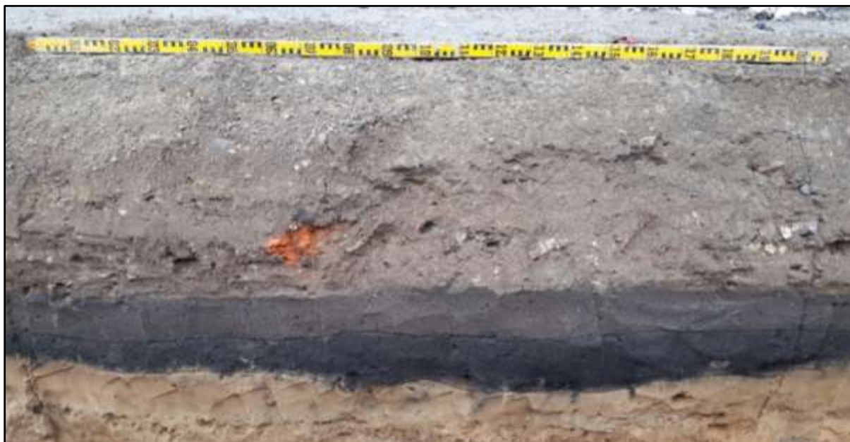
Figur 110. Schakt 24, sektion nr 68. Ett 0,50–0,60 m djupt väglager ligger ovanpå ett ca 0,20–0,30 m djupt kulturlager.
