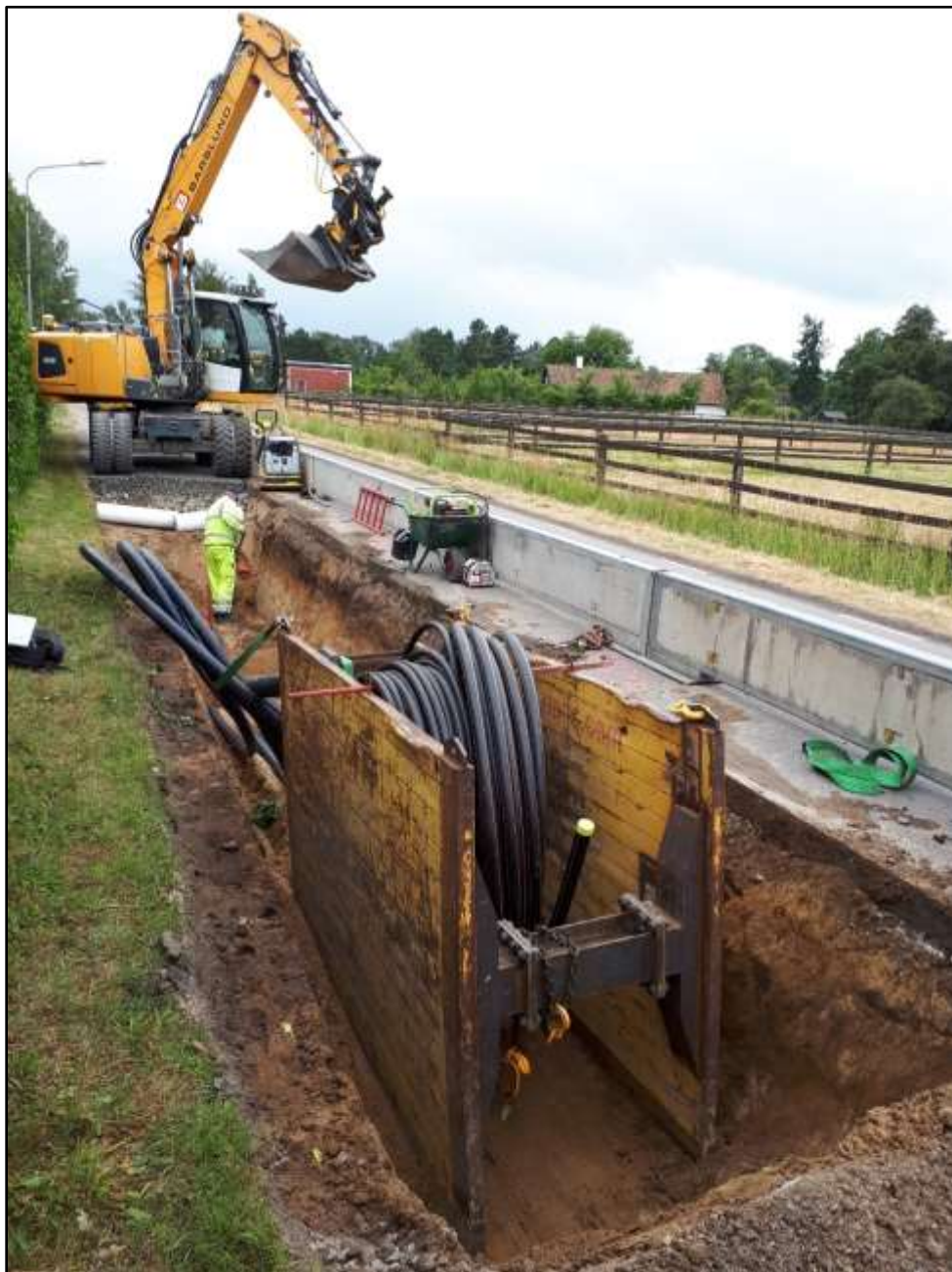
Figur 32. Schakt 54, arbetsbild från norr i Vombsvägens/schaktets norra del.
