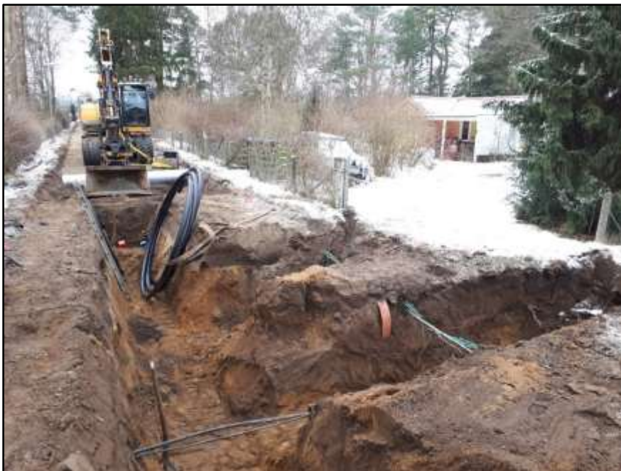
Figur 114. Schakt 26, Södergårdsvägen. Bilden visar den del av schaktet där nya serviser ska sättas till de intilliggande husen och där ett flertal äldre ledningsgrävningar har nedlagts ner till morän.
