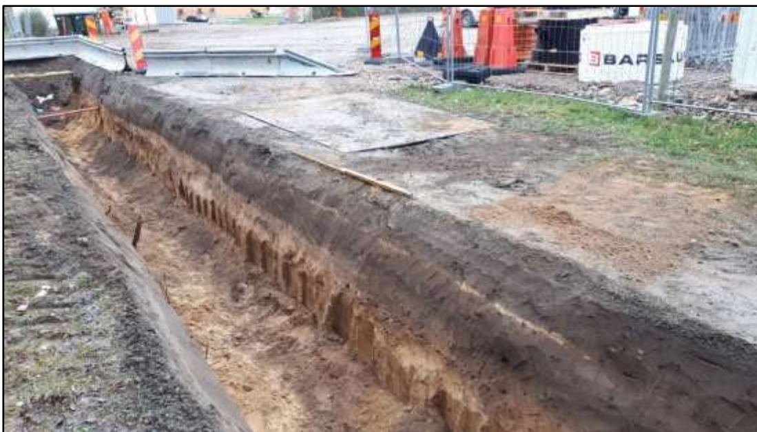
Figur 107. Översikt av schakt 13, Västra Vombsvägen. Ett cirka 0,50 m djupt kulturlager delas av ett par centim djupt sandlager som tolkas som sand från den sterila jorden, förmodligen ett resultat av sandflykt.
