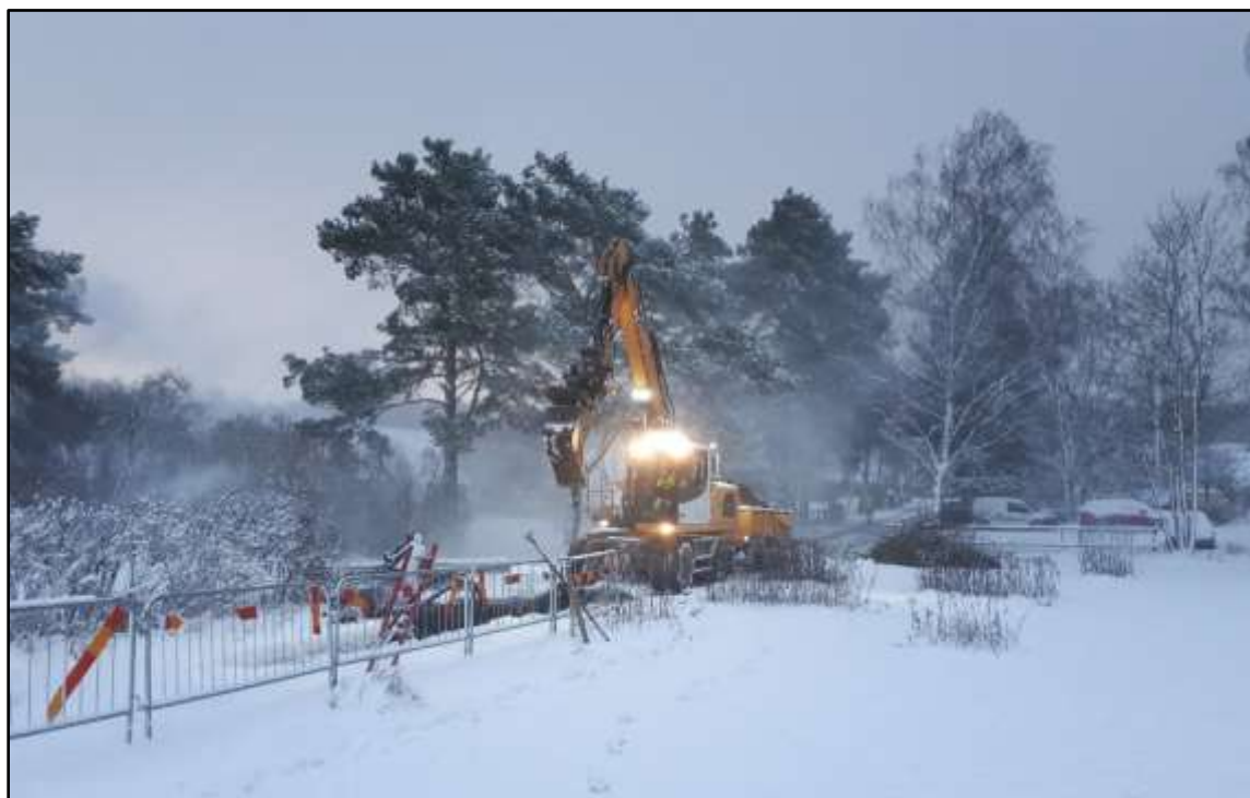
Figur 55. Snöstormar innebar svåra arbetsförhållanden under arbetet med Schakt 21.
