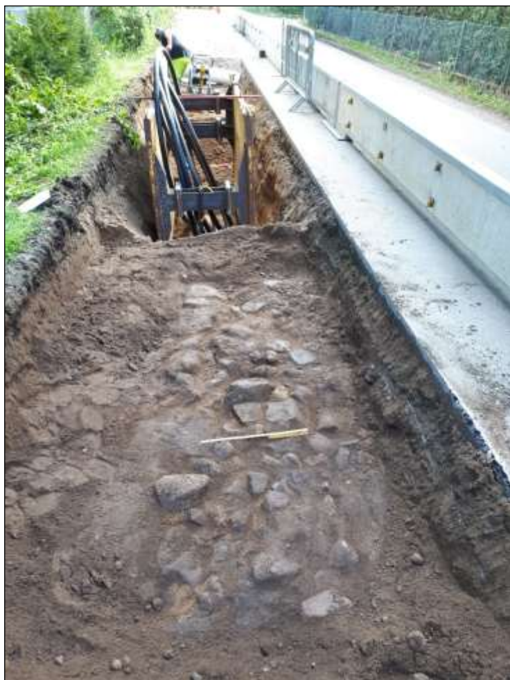
Figur 137. Schakt 50, Vombsvägen. Stenkonstruktion A264, tolkad som vägbeläggning. Många av stenarna hade kraftiga dimensioner. En svag tendens till att de allra största stenarna låg i vägens kant kunde skönjas. Foto taget mot söder.
