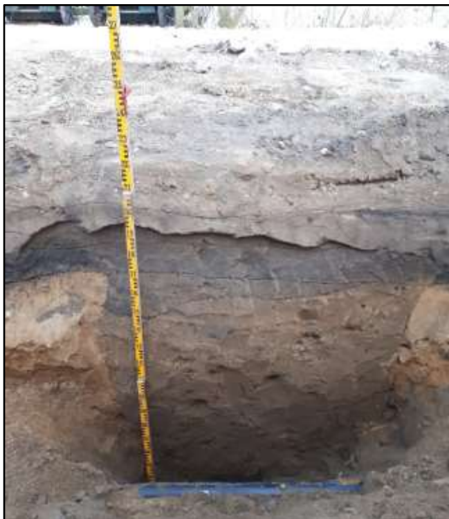
Figur 111. Schakt 25, Sektion nr 69, Södergårdsvägen. En brunn som går ner ca 2,50 m under gatunivå. Den nya vattenledningen syns i nederkanten av bilden. Schaktdjupet för denna är 1,60 m. Resterande djup grävdes för hand för att hitta slutet på brunnen. Det var därför inte möjligt att få med botten på brunnen i bild.
