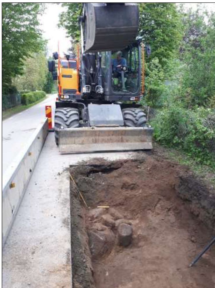
Figur 136. Schakt 50, Vombsvägen. stenkonstruktion med stenarna A255–263. De första större stenarna som påträffades i Vombsvägen tolkades först som syllstenar. Efterhand när schaktningen fortsatte norrut visade det sig dock tydligt att det handlade om en vägyta, eller väguppbyggnad. Ett par av stenarna på bilden är rubbade ur sitt läge och har därför hamnat på högkant. Foto taget mot norr.
