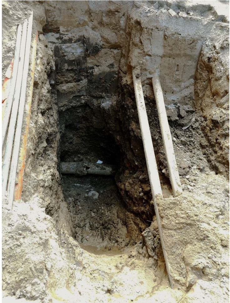
Figur 3 Den sydvästra delen av schaktet, med det aktuella avloppsröret i botten, visar situationen vid start av dag 2.
