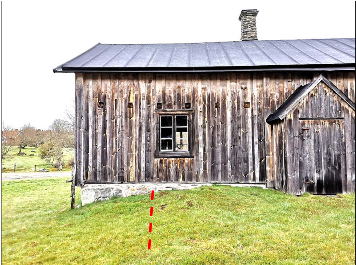
Figur 10. Fotografi taget på västra delen av mangårdsbyggnad före schaktning i maj år 2021. En nivåskillnad i terrängen skulle undersökas och om några uppstickande stenar ingick i en stenkant. Den streckade röda linjen markerar nivåskillnaden och de uppstickande stenarna anas närmast byggnaden. Fotografiet taget från söder.
