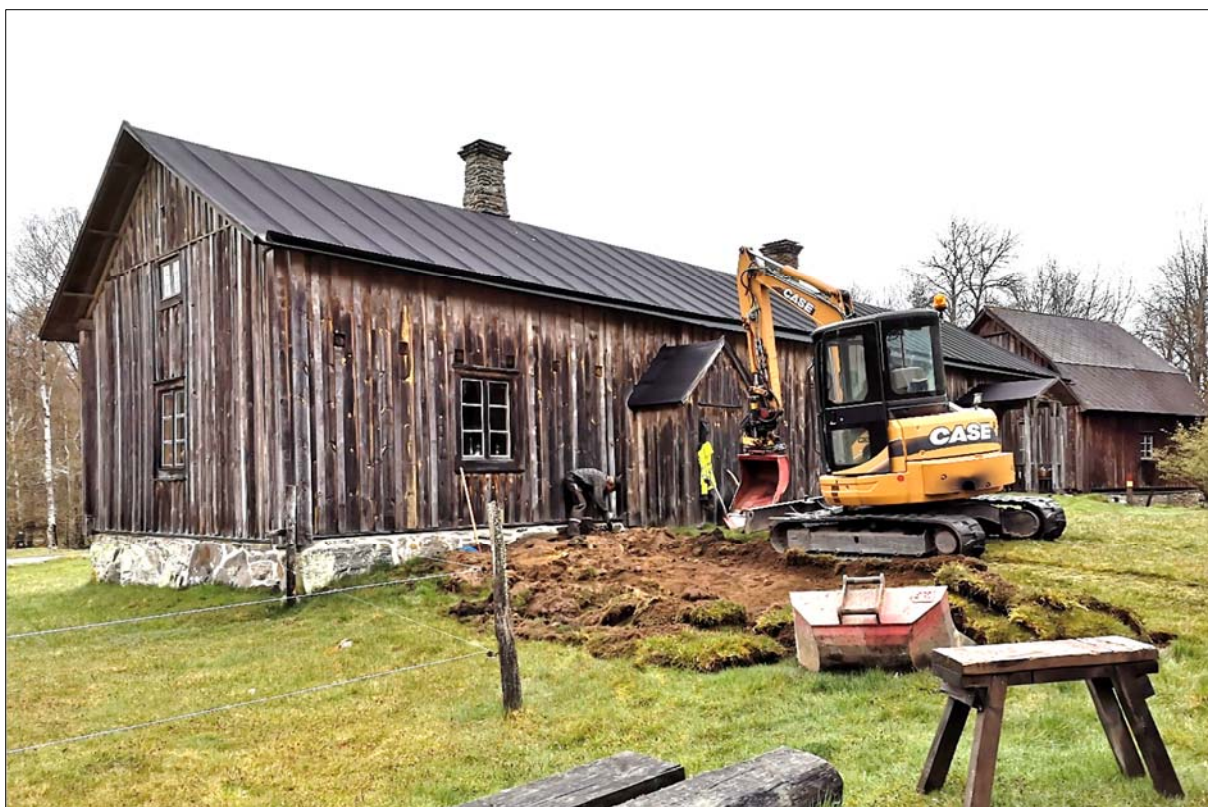
Figur 11. Schaktningsarbetet pågår inom undersökningsområdets västra delar. Timmerman Olof Andersson kontrollerar att tillräckligt med jord tas bort från fasaden invid utbyggnaden. Fotografiet taget från sydväst.
