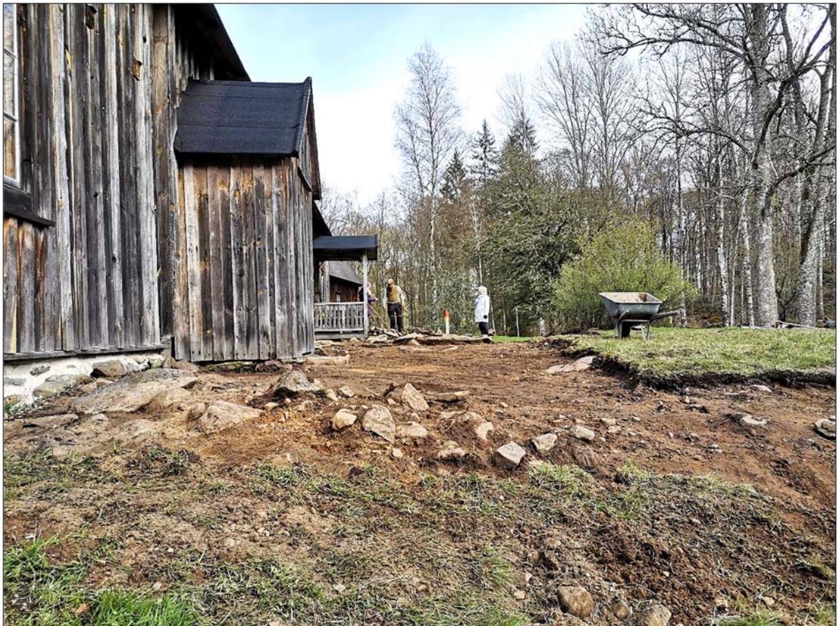
Figur 32. Vy över den avbanade ytan från väster. Närmast i bild terrasseringskanten i väster. Odlingsbäddens stenkant skymtar längre bak i bild och påförda massor kan anas vid skottkärran.
