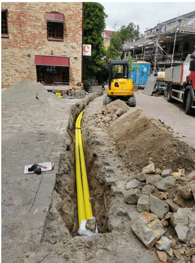
Figur 6. Schaktet för elledningar tvärs över fastigheten. Sett från öster.
