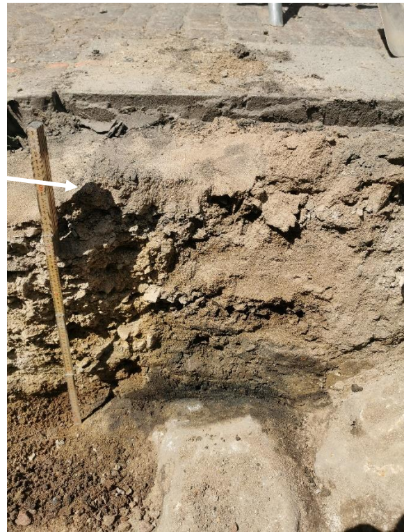
Figur 5. Sektion i schakt utanför Sankt Thomas kyrkas huvudingång, där stengrund påträffades under bärlager och sand på ett djup av 0,55 m. Sedd från öster.
