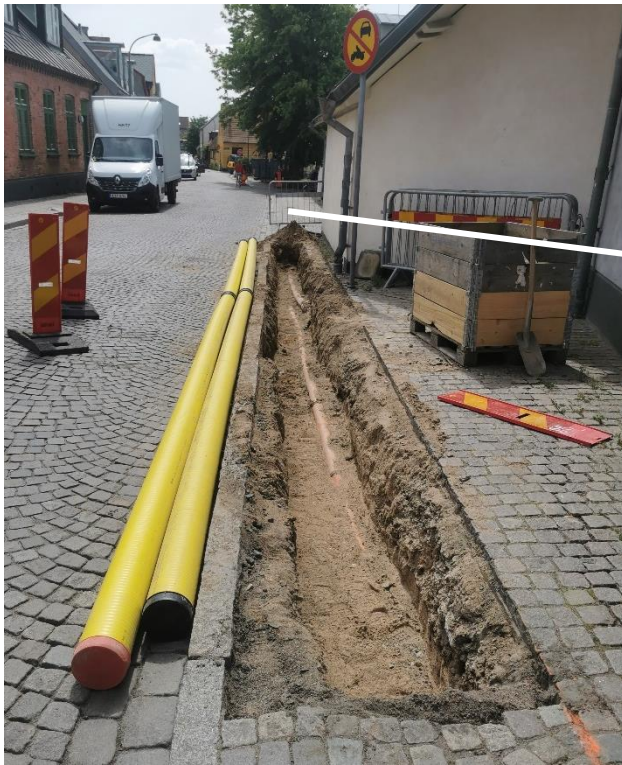
Figur 4. Stora Tomegatan 8A, ner till Kv Maria Magle 6, sedd från norr.
