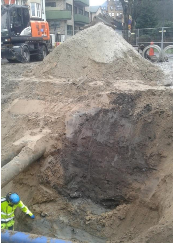
Figur 12. Vallgraven i korsningen Östra Vallgatan/Dalbyvägen sett från söder. Fjärrvärmeledning kan ses vänster i bild och i förgrunden ligger VA-ledning som lades ner 2006.
