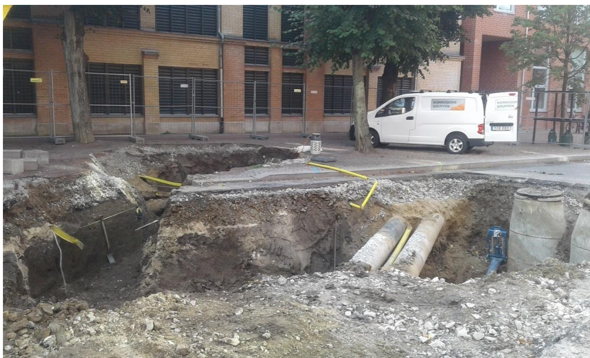
Figur 8. De två schakten i korsningen Brunnsgatan/Södra Esplanaden, sett från norr.
