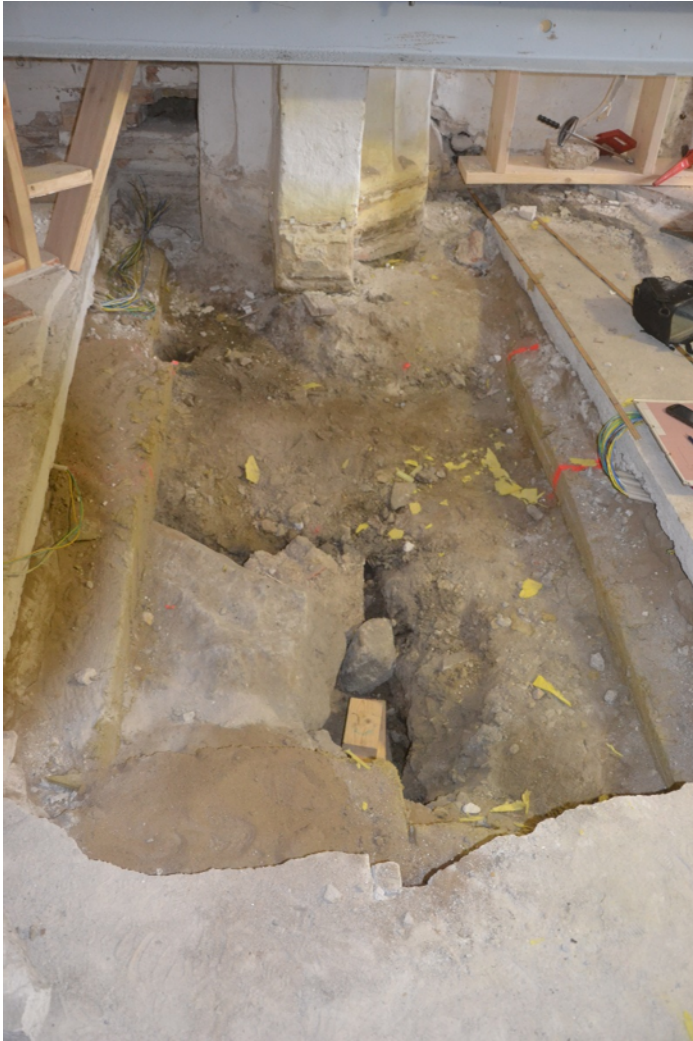
Figur 6. Provgropen i förgrunden, och den påbörjade handgrävningen för grundförstärkning mot valvpelaren. Fotografi från söder.
