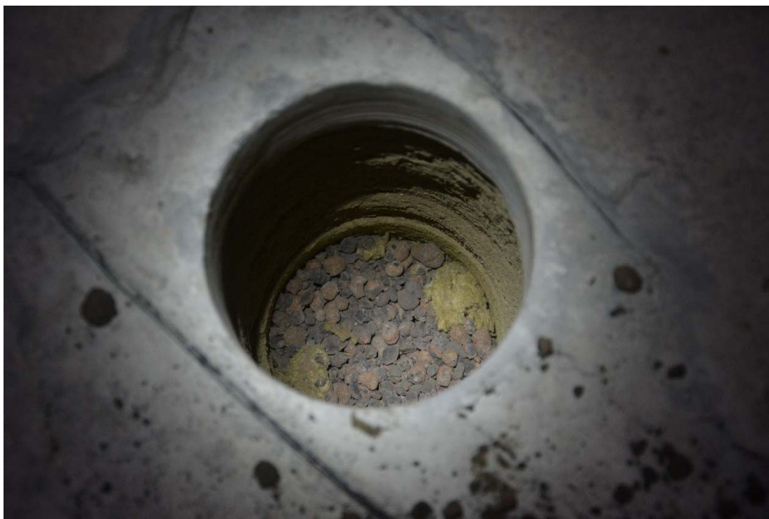
Figur 5. Borrhprov 2 med lecafyllning.
