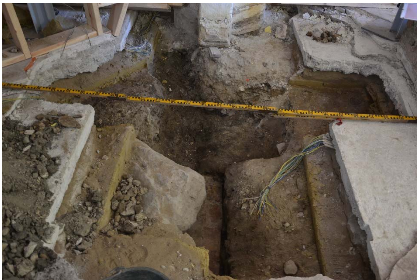
Figur 8. Arbetsområdet för den norra grundförstärkningen, med den tidigare provgropen samt området för handgrävning. Fotografi från söder.
