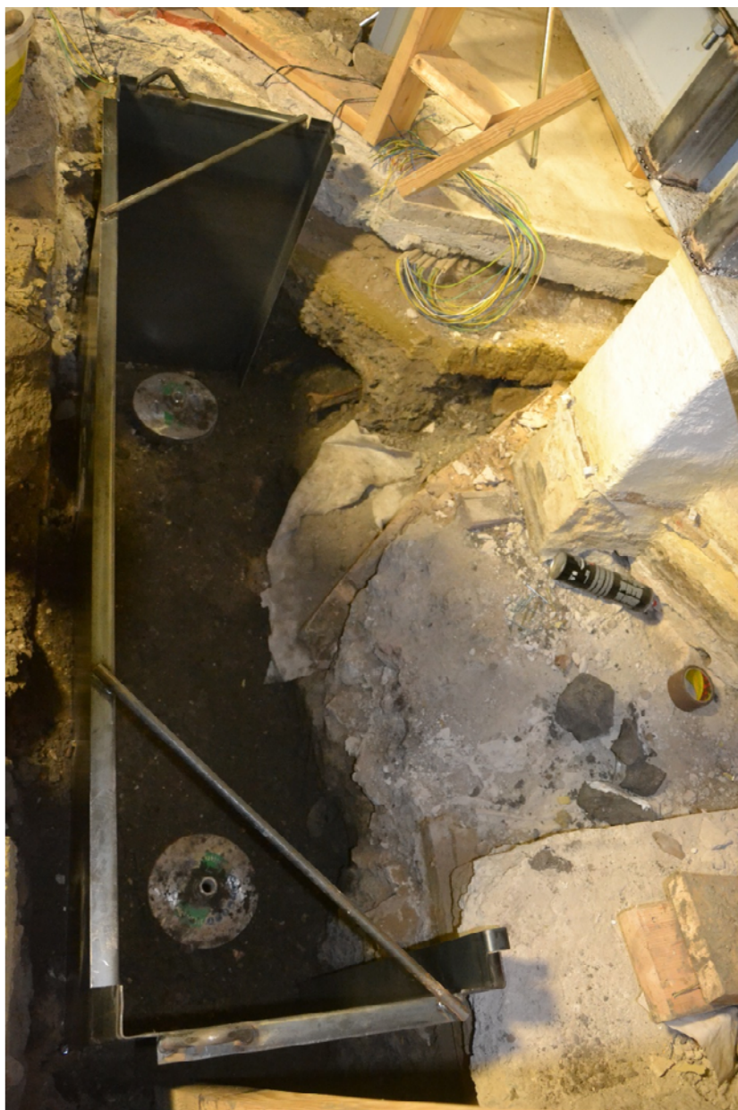
Figur 10. Form och pålar för den första grundförstärkningen, på den norra sidan. Fotografi från öster.
