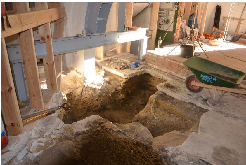
Figur 9. Arbetsområdet för den första grundförstärkningen, fotografi från sydöst.
