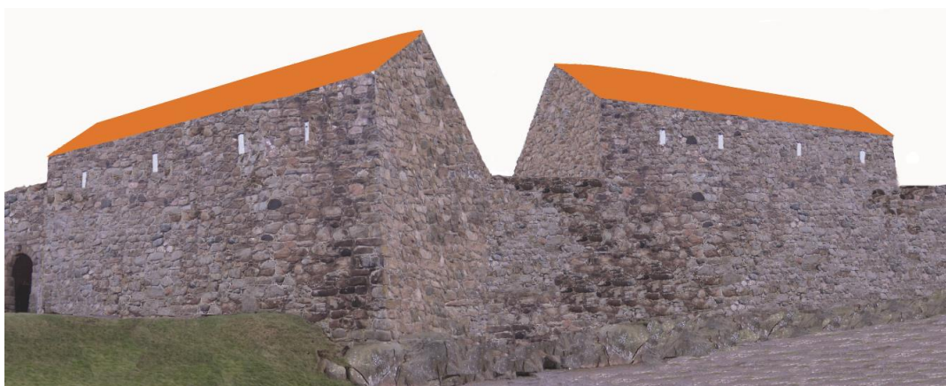
Figur 74. De två byggnaderna från slutet av 1280-talet på Varbergs borg.
