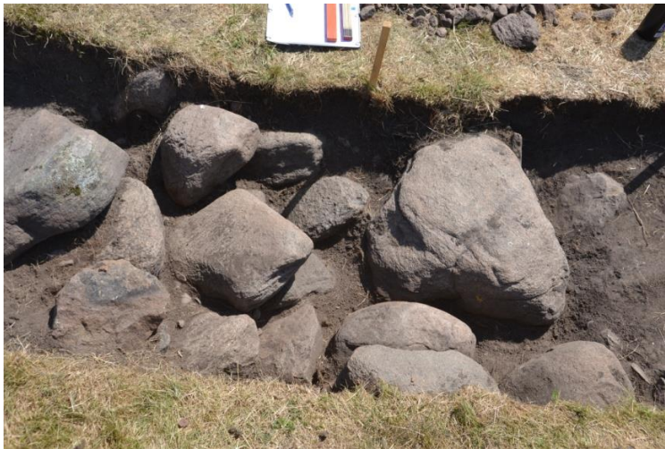
Figur 63. Schakt 5 och grundmuren. Fotografi från norr.
