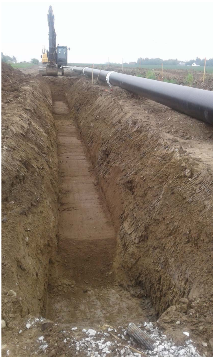
Figur 4. Schaktet för fjärrvärmledning i Stora Råby, under pågående övervakning.
