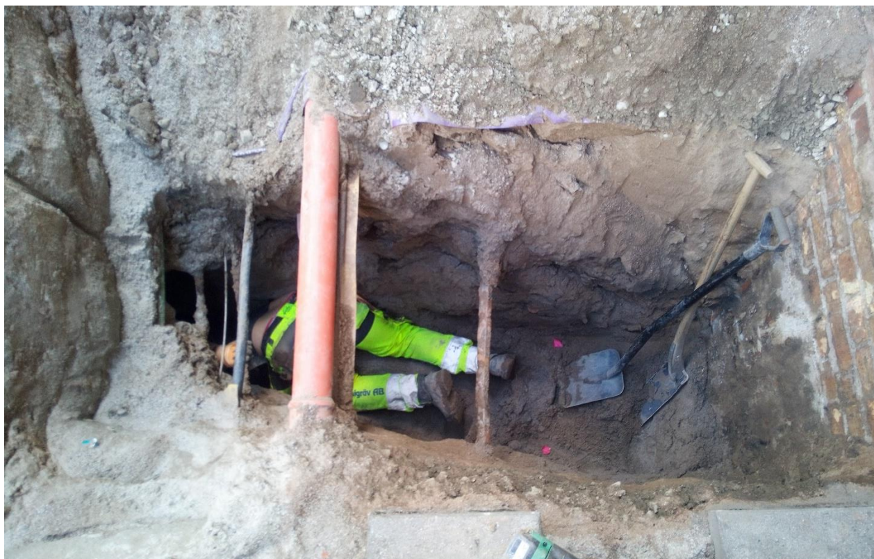
Figur 3. Anläggaren tunnelgräver i djupschaktet inom schakt 1.
