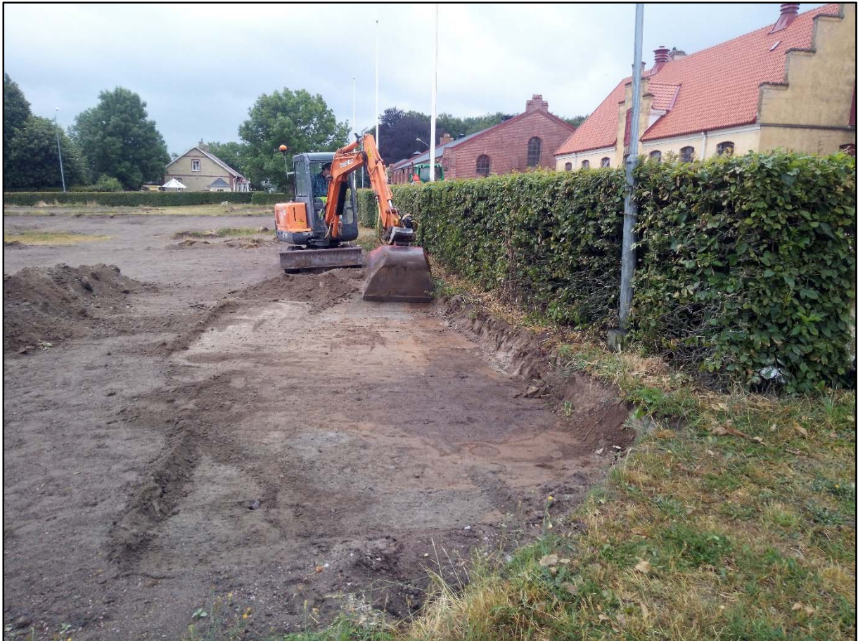
Figur 4. Pågående schaktning längst i väster. Den mörka fläcken mitt i bilden var nedgrävt modernt material med bland annat finfördelade plastpartiklar.
