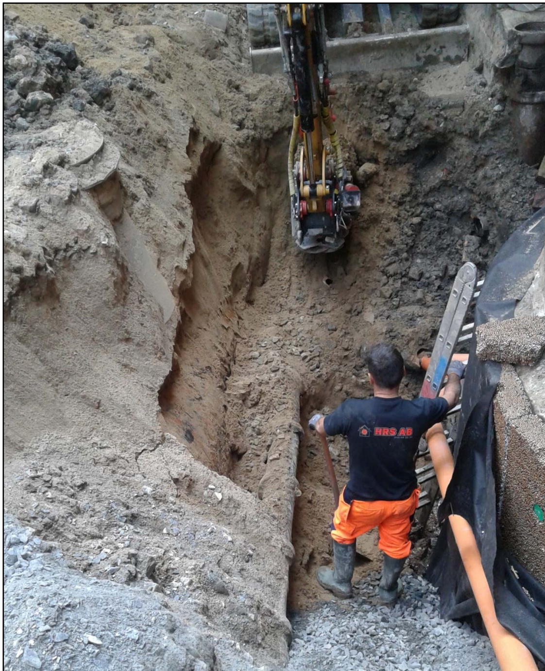
Figur 8. Schaktning i området av oljetanken som grävdes ned år 1962. Massorna runtomkring var lösa och schaktkanterna rasade ofta. Foto taget från norr.
